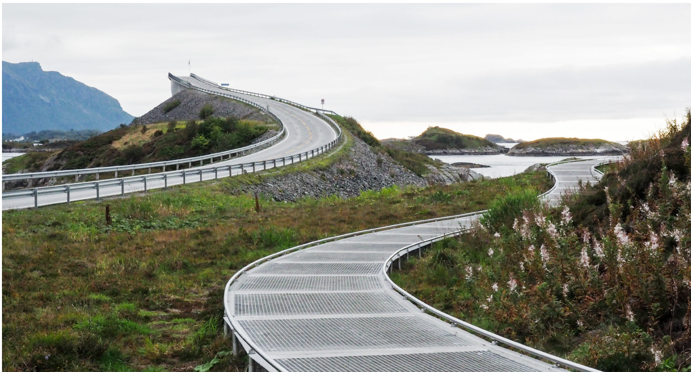
Atlantehavsvegen ved Storseisundet. Atlantehavsvegen inngår i ein kystveg som bind Averøya og fastlandet ved Hustadvika. Vegstrekninga er freda. Foto: Siri Wolland, Riksantikvaren.
