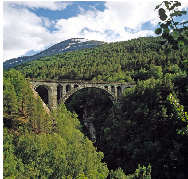
Kylling bru, Raumabanen. Foto: Møre og Romsdal fylkeskommune.
