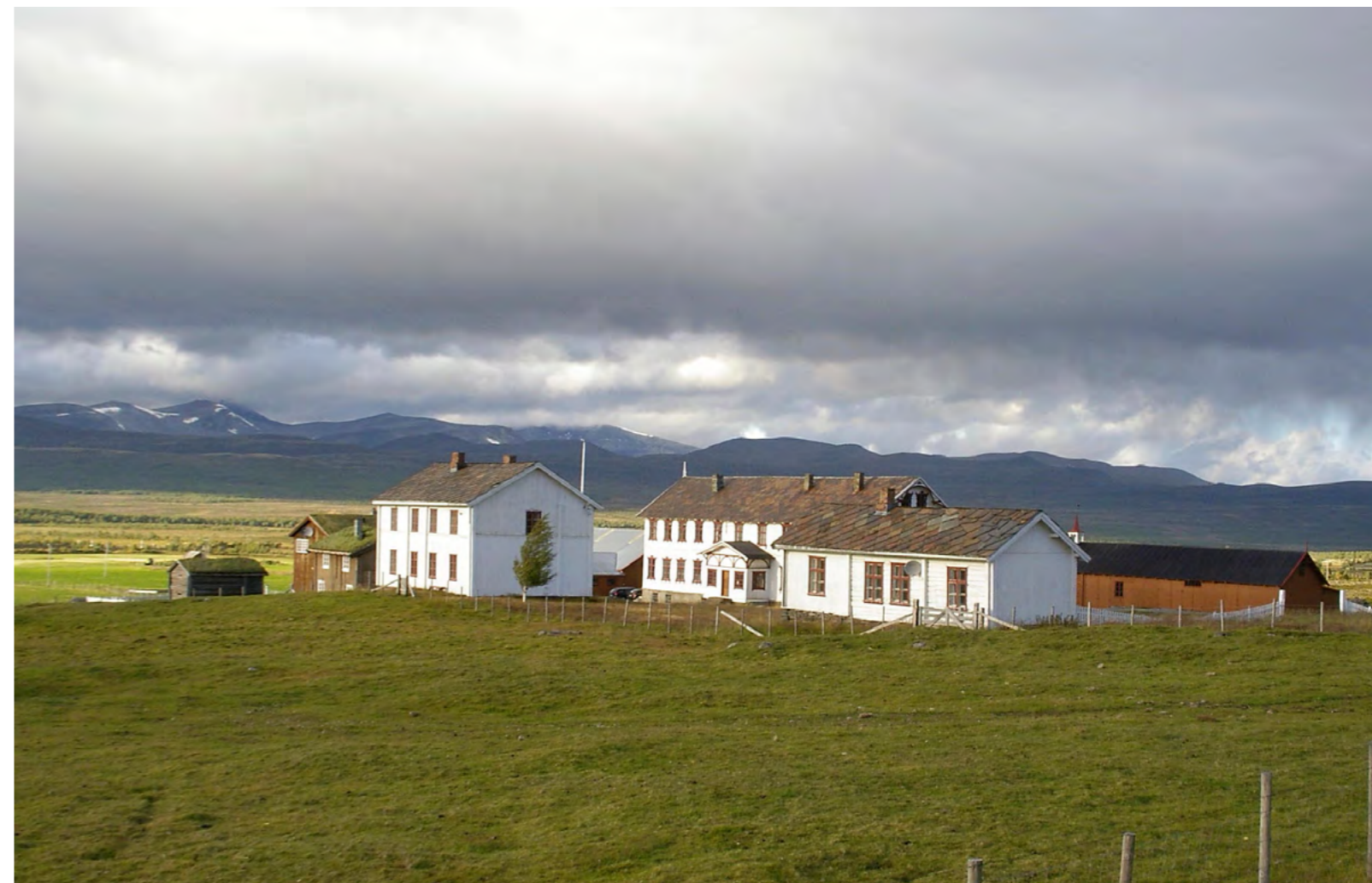
På Fokstugu vart det tidleg etablert skystasjon og overnatting for reisande over Dovrefjell. Dagens pilegrimar finn framleis enkel overnatting her. Foto: Ragnhild Hoel, Riksantikvaren
