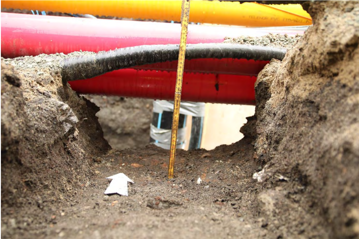
Figur 23: 25 cm med intakte kulturlag ble fjernet i den nordre delen av trasèen. Bilde tatt mot nord. Da_62848_122.
