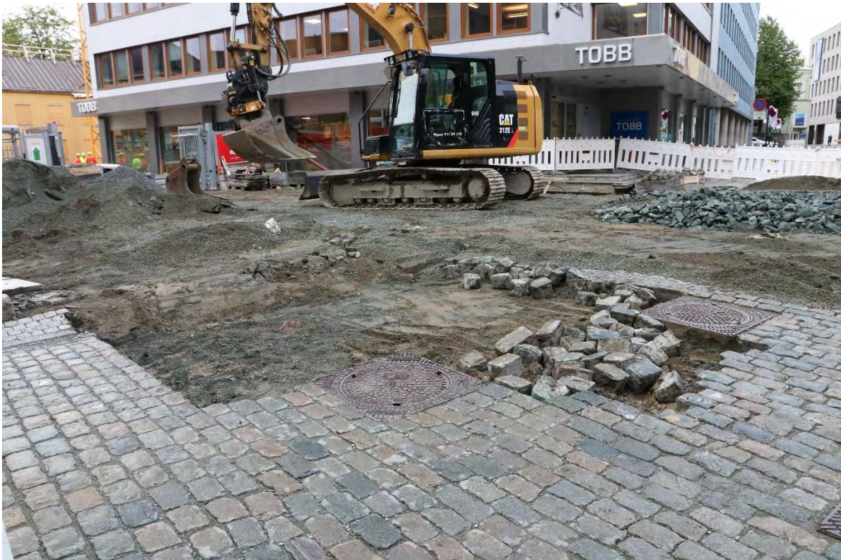
Figur 9: Arbeidsbilde. Sjakt 3 graves fra kum nederst i bildet. Sett mot sørvest. Da_62848_028
