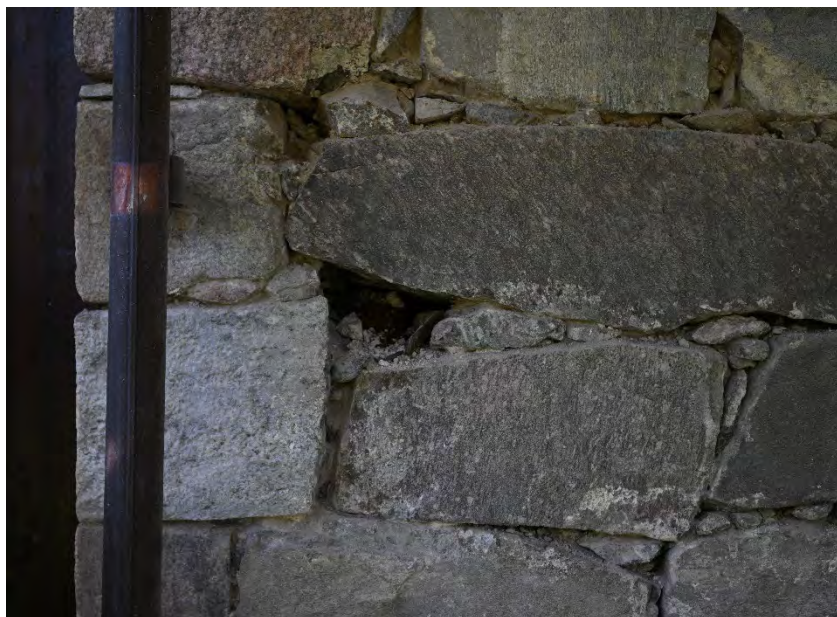
Fig. 25. Skipets nordøstre hjørne, stillashull for materialprøve 5 og 6.
