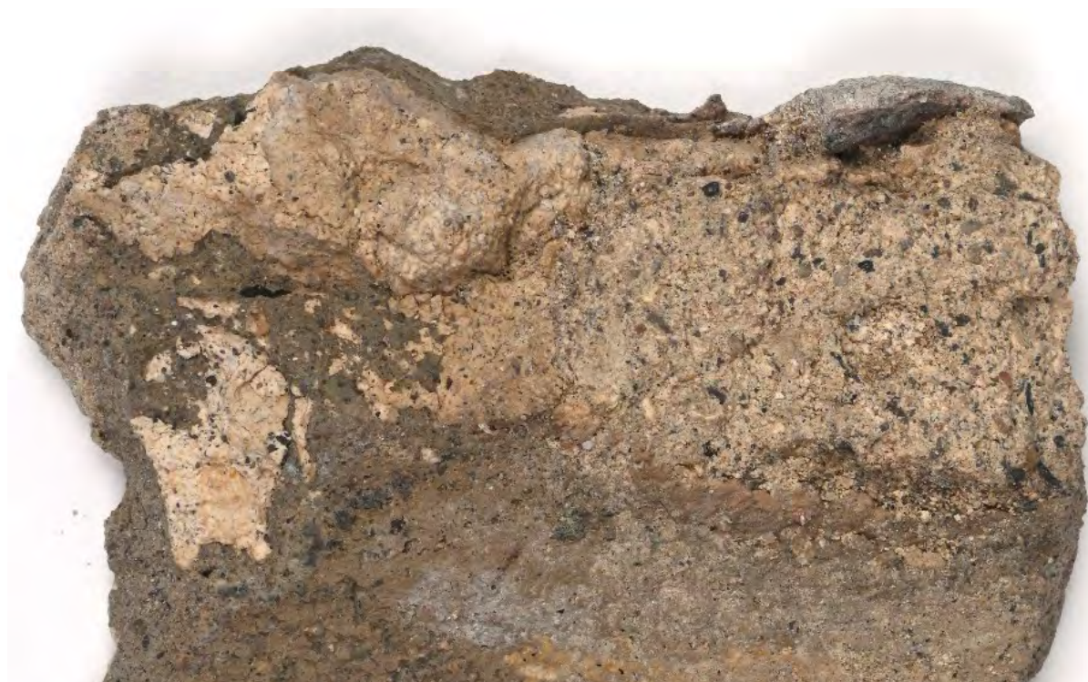
Fig. 21. Detalj av baksiden med rester av eldre puss og/eller fugemørtel.
