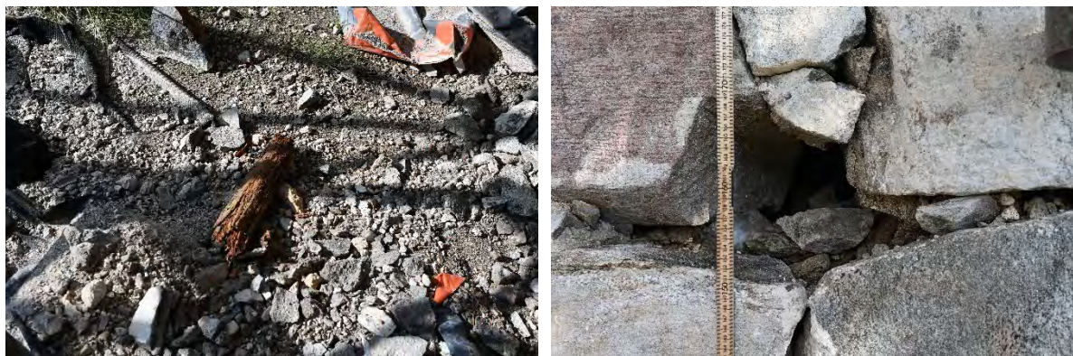
Fig. 13 og 14. Materialprøve 1 ble funnet liggende på bakken under stillaset på sørsiden av koret og kom helt tydelig fra et hull i murverket over.
