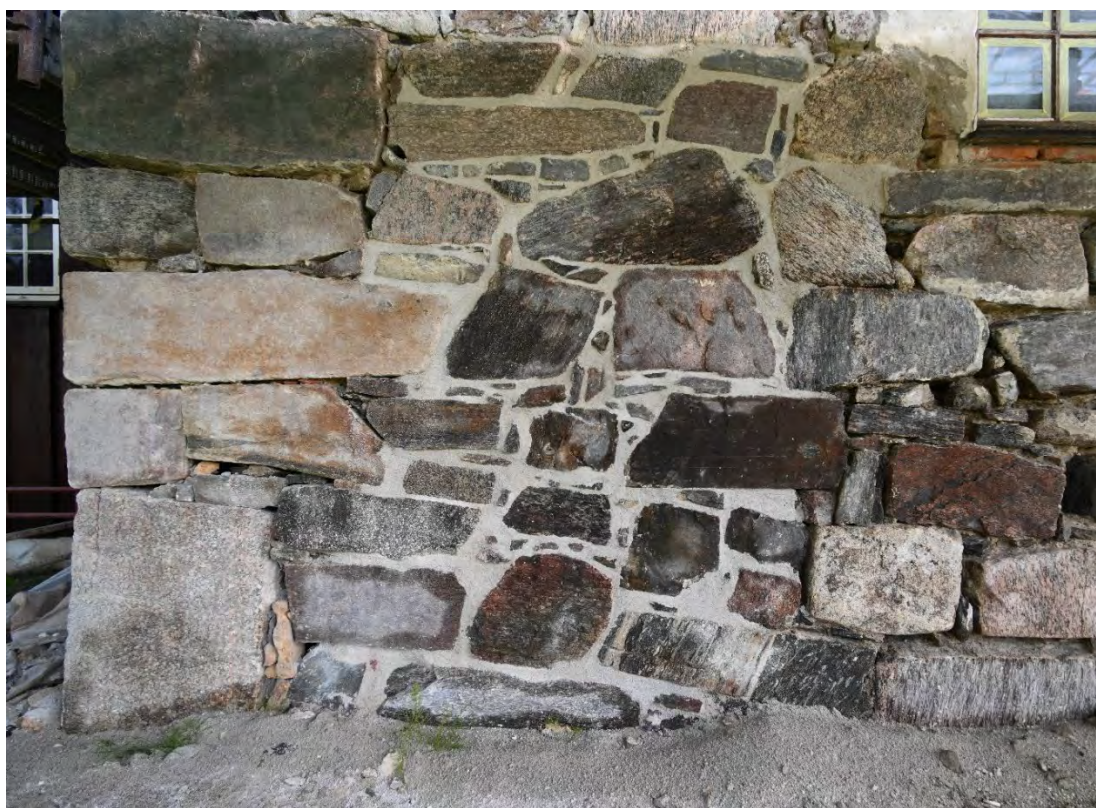
Fig. 50. Skipets sørvestre hjørne sett fra sør, 25. august 2022. Prøvefelt med nye fuger med kalkmørtel.
