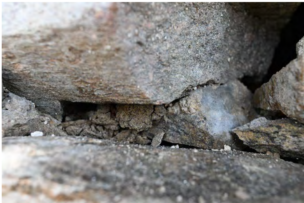
Fig. 16. Mørtel i underkant av hull for stillasstokk (materialprøve 1), før uttak. Prøvene ble tatt ca. 150 cm over bakkenivå og ca. 55 cm fra skipets sørøstre hjørne.
