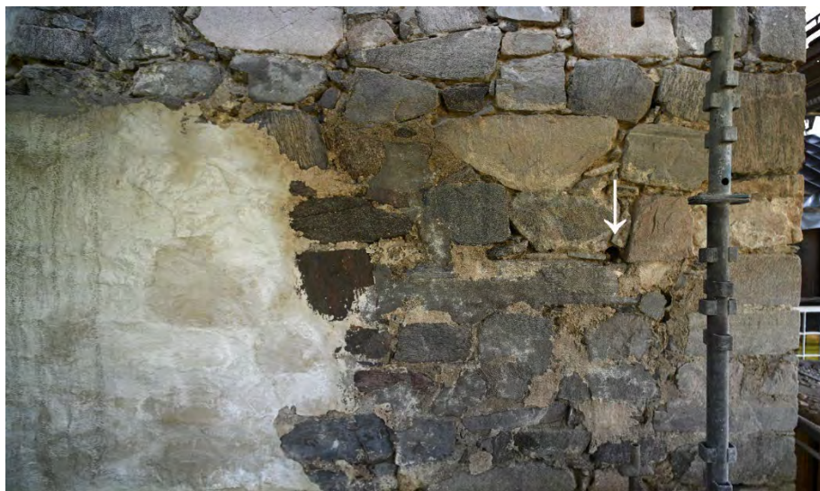
Fig. 34. Pilen viser stillashullets plassering og hvor materialprøvene er tatt.
