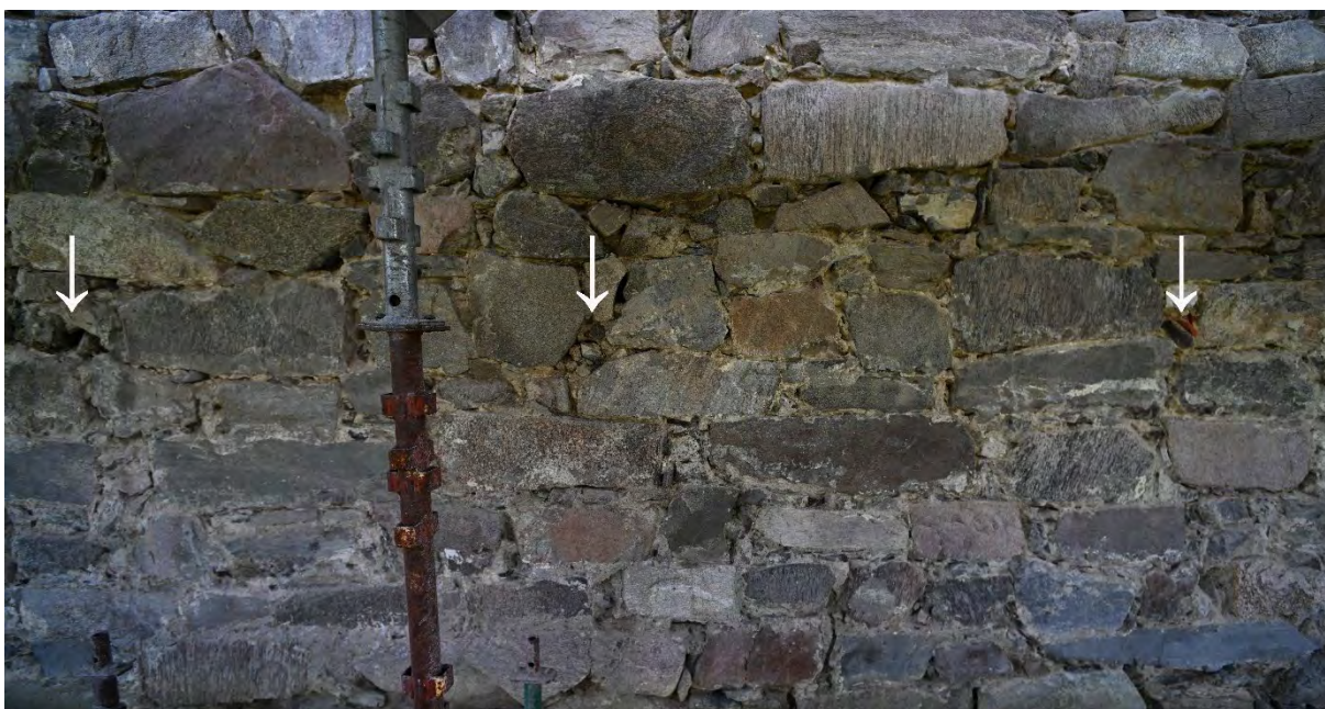
Fig. 48. Nordveggen, stillashull uten treverk, delvis gjenmurt, nr 2, 3 og 4.
