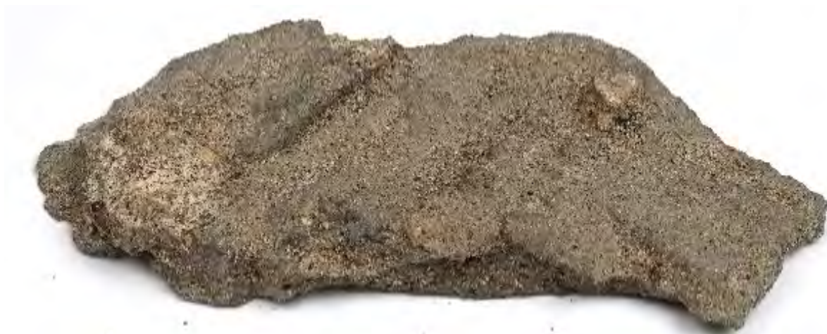
Fig. 24. Baksiden av den harde sementholdige pussen har rester av eldre mørtel.
