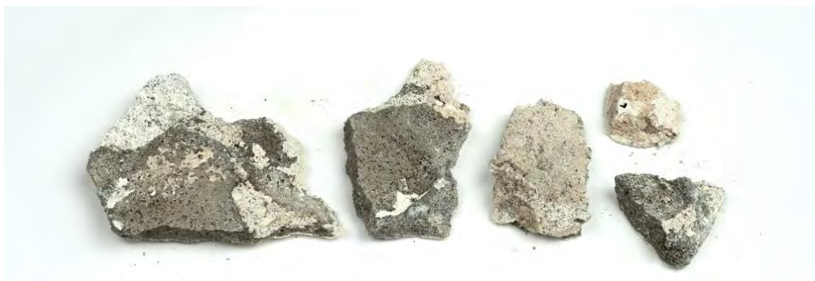
Fig. 30. Hard sementholdig puss med eldre kalkmørtel på baksiden.
