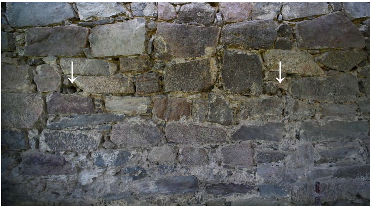
Fig. 47. Nordveggen, stillashull uten treverk, delvis gjenmurt, nr. 1 og 2.
