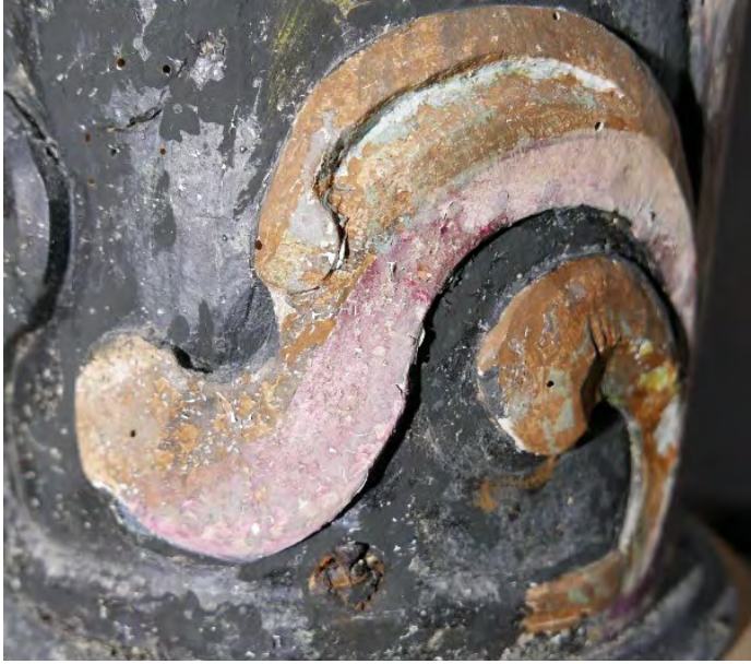
Fig. 13 Testfelt 4, nedre høyre søyleskaft før konsolidering i 2020.
