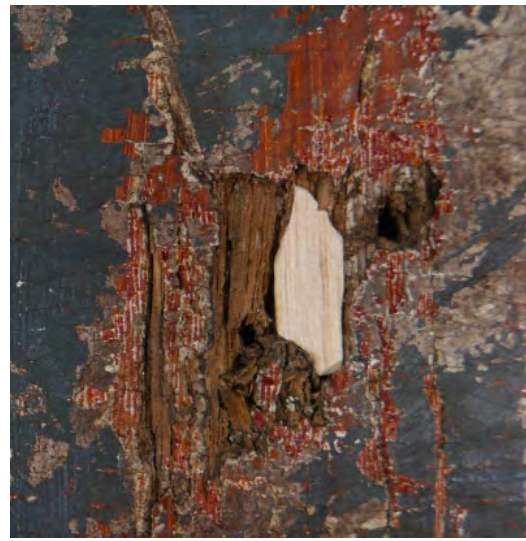
Punkt E. Hullet er tappet før spuns ble lagt på. Spunsen er i furu og ru i overflaten for å passe omgivelsene.
