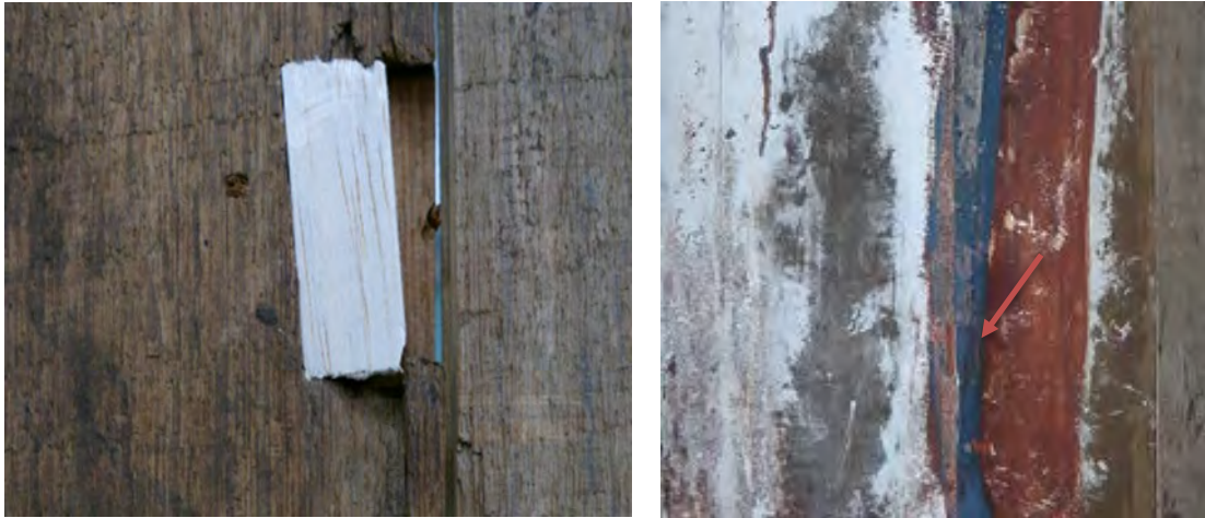
Punkt J Denne klossen holder en innfelling på plass. Innfellingen var løs, men kunne ikke tas ut og limes. Den ble limt langs den ene kanten før denne klossen ble festet.
