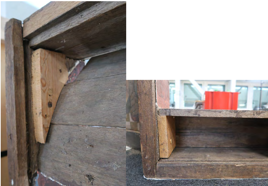
Feste av baldakin (venstre) og feste av panel og front til korpus (høyre).
