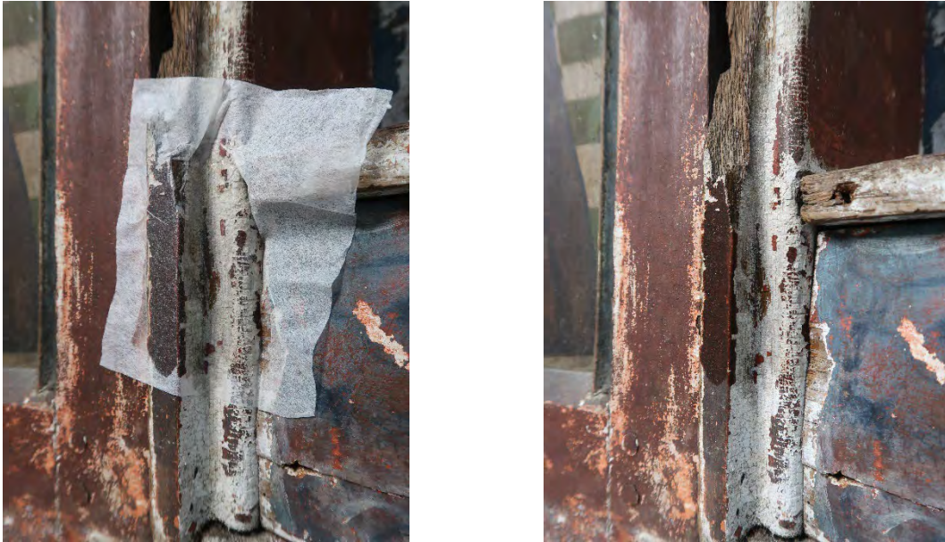
Listverk flatekonsolidert med metylcellulose.
