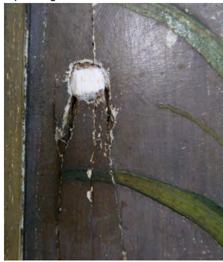
Hull B innside før og etter spunsing.
