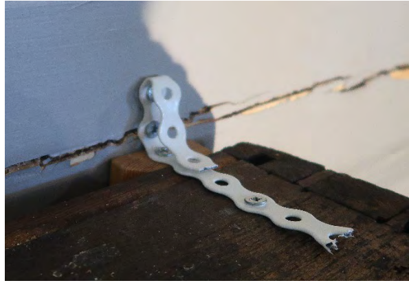
Alterskapet ble festet til kirkeveggen med patentbånd.
