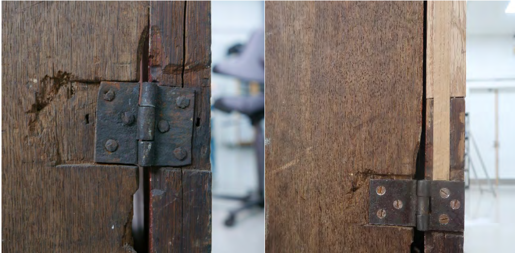
Gammel hengsle nederst på venstre fløydør. Ny hengsle nedre på venstre fløydør.
