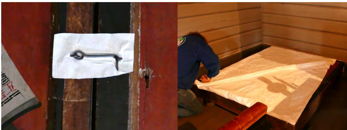
Beskyttelse med Tyvek.
