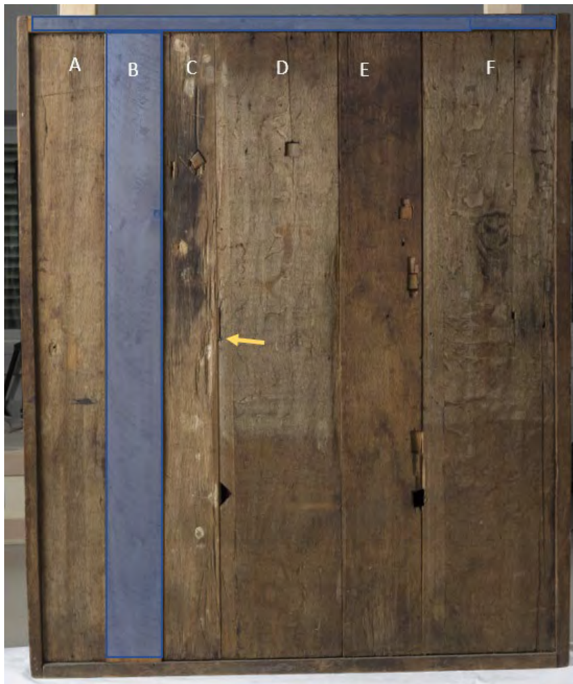
Blåmerkede elementer er sekundære og i furu. Øverste blåmerkede del er kun en list, ikke hele toppstykket.
