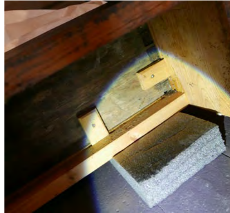
Løse klosser var tredd inn i et spor i side og forkant av sokkelen og skrudd opp i skapets underside.
