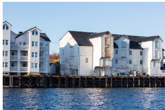
Storsalteriet er et eksempel på en bygning som har en viktig rolle i helheten
