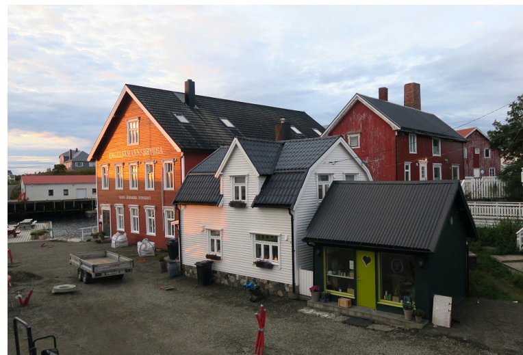
Bygningsmiljø på Torget. Bygningsmassen fra 1900-tallet huser i dag flere forretninger og næringsdrivende. Foto: Jorun Aaresvik Hals
