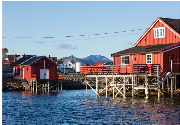
Bygging på pelers
