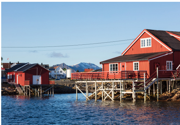
Bygging på pelers.
