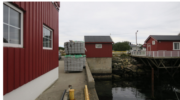
Bilde av pumpestasjon. Foto: Jorun Aresvik Hals, Riksantikvaren
