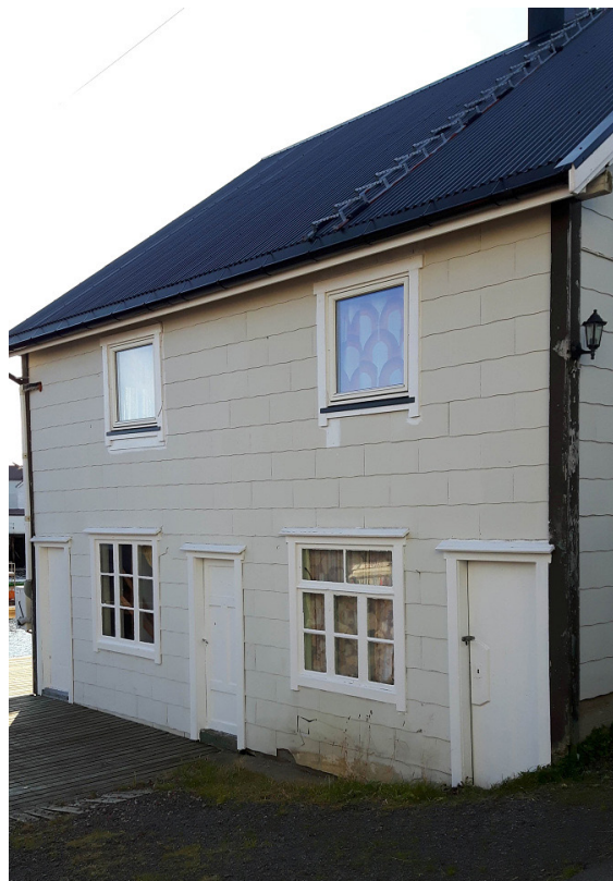
Etternitt er et materiale som ble populært på grunn av sin holdbarhet i værharde strøk fra 1950-tallet. Etternitten inneholder asbest, men kan ersattes med asbestfrie alternativer.
