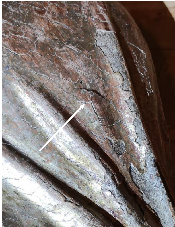
Detalj Hellig Olav. Takformet oppskalling. Maling og grundering har ikke lenger plass på underlaget
