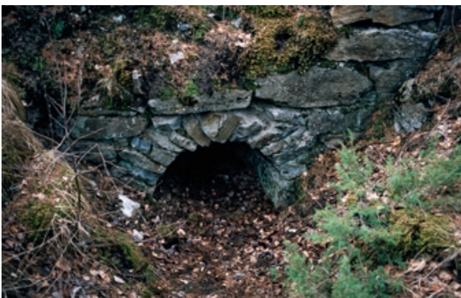
Figur 6.3.5-1. Overgrodd murverk med hvelv på Mjøskastellet, Stein i Ringsaker kommune, Hedmark. Foto: Riksantikvaren, Anne-Sophie Hygen
