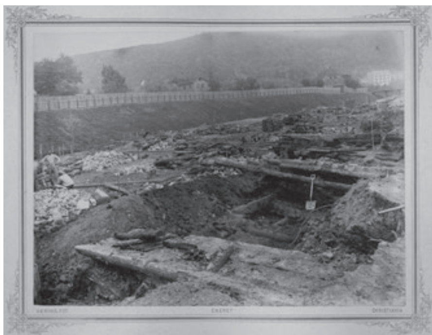
Figur 1.0-1. Fra arbeidene med Smaalensbanen på 1870-tallet, da levninger av middelalderbyen Oslo i Gamlebyen for første gang ble gravet fram i større omfang og dokumentert av arkitekt Peter Blix. Udatert fotografi fra Fortidsminneforeningens arkiv. Foto: Væring, Oslo (Christiania)
