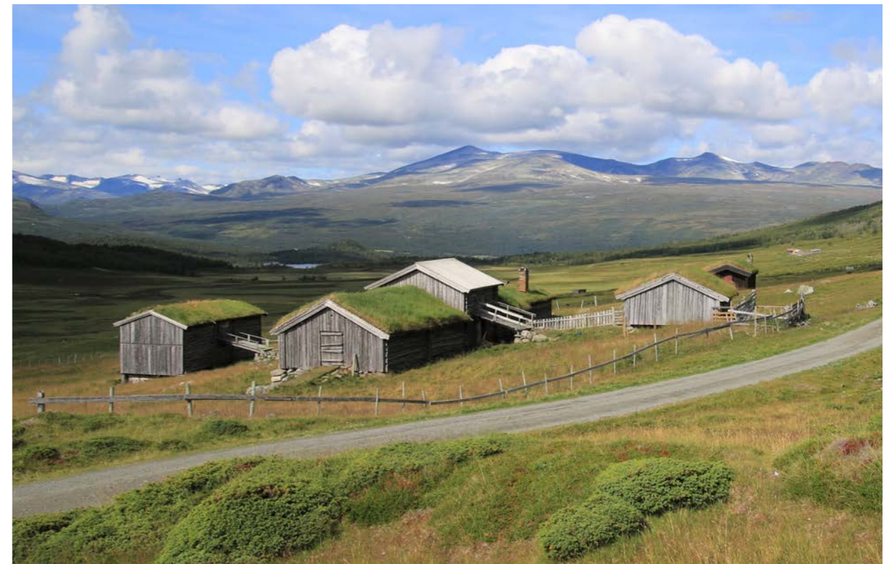
Bygningane på Kvarbergsetra er typiske for setrene i Sjudalen og Griningsdalen. Vintersetringa sette andre krav til bygningane – sela var store, og fjøsa har dei karakteristiske «måsåtreva». Foto: Kari Stensgaard, NIBIO
