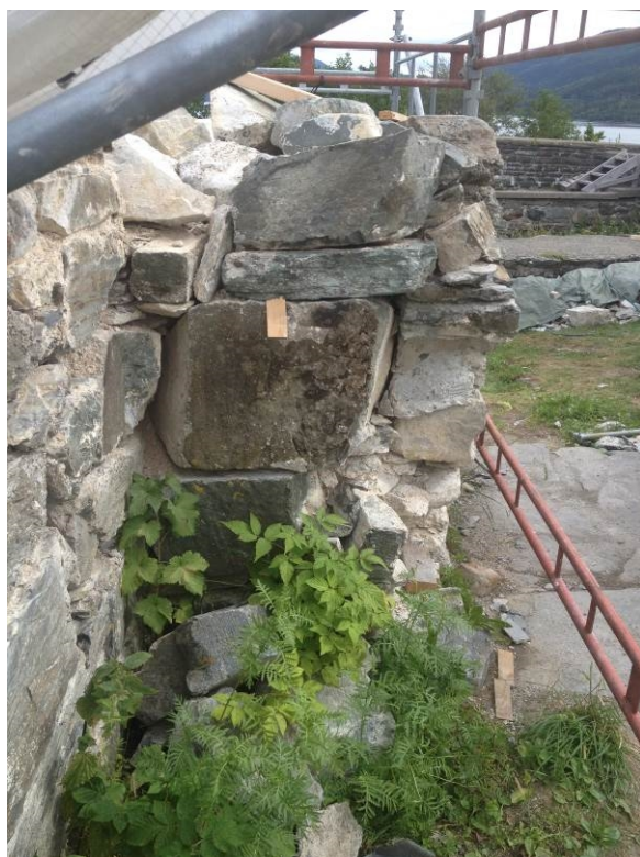
Foto20061138_232: Utrast klebersteinshjørne som i dag er murt tilbake. Foto av det ferdige hjørnet vil komme i neste rapport.
