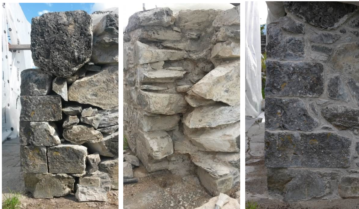
Foto 20140813_133, 20140814_114 og 20061137_069: Viser klebersteinshjørne ved inngangen til rom103 på søndre side. Bilder er tatt før, under og etter ommuring.
