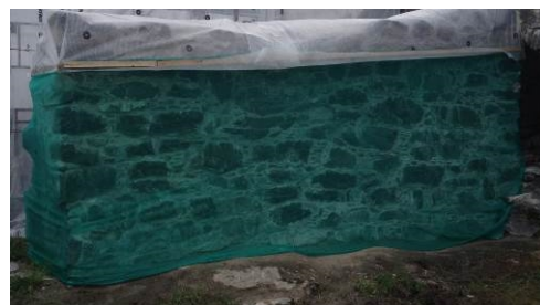
Foto 20061138_098: Ferdig mur mellom rom 101 og 102 tildekket for en periode på omkring 3 måneder. Murverket er tett på toppen så vann ikke kommer inn i murverket. Veggene er dekket med nett for å kunne ettervanne og samtidig gi murverket luft.
