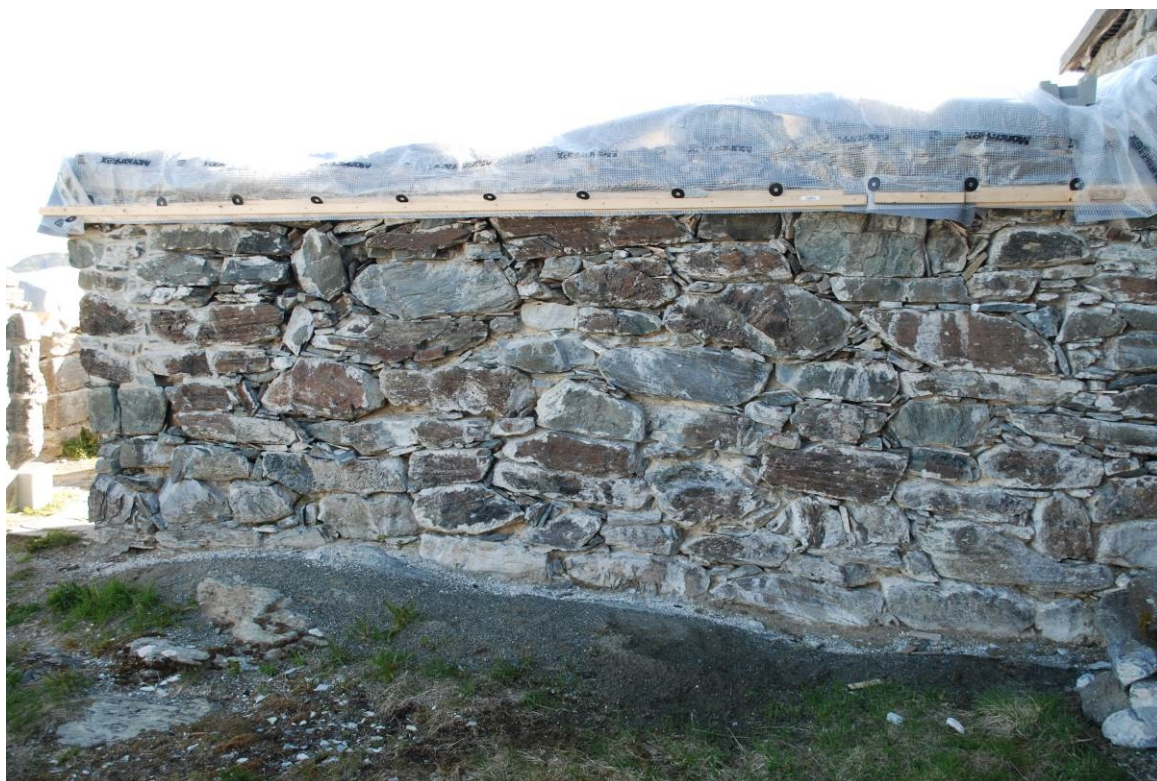
Foto 20061137_001: Vestre side av mur mellom rom 101 og 102. Bildet er tatt våren 2014 rett før oppstart av konserveringsarbeidet. Tildekkinga av toppen ble utført på oppdrag for byggherre 2013.
