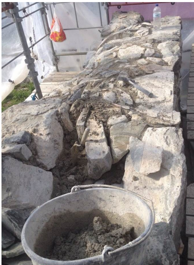
Foto 20061138_083: Toppdekke under arbeid. Etter at toppdekket ble ferdig ble murverket vannet i tre uker. Muren ble så dekket til i ytterligere tre måneder før tildekking ble fjernet
