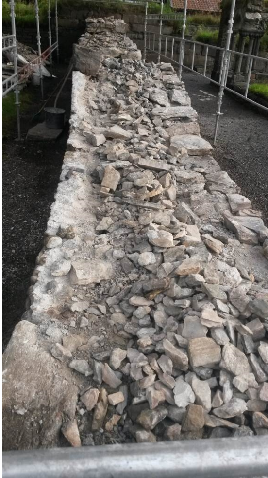
Foto 20140809_120 og 11_161: Betongplate på toppen er fjernet. Bildet til høyre viser prosessen med å rense muren ned til fast murkjerne.
