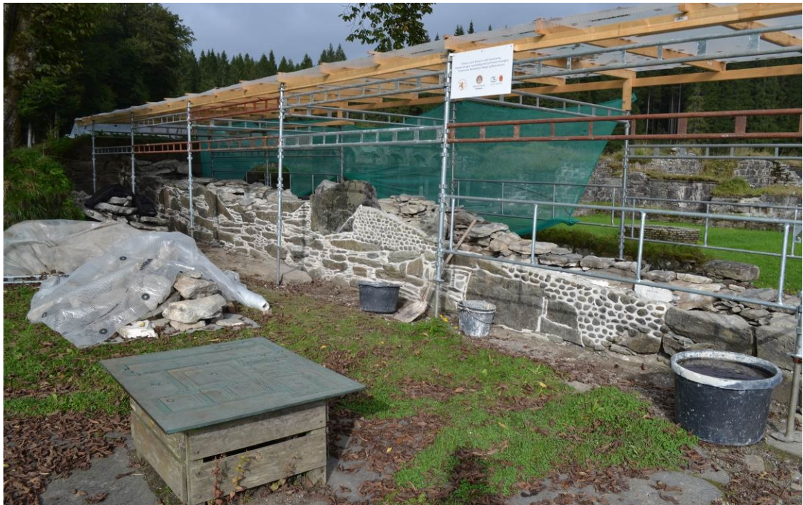
Foto 20052208_015: Spekking av vestre side av vestmur.
