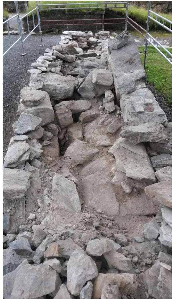
Foto 20140809_120 og 11_161: Betongplate på toppen er fjernet. Bildet til høyre viser prosessen med å rense muren ned til fast murkjerne.
