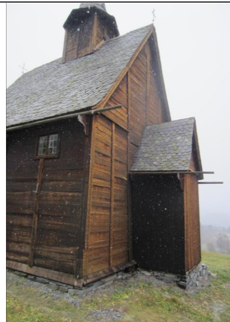
Lomen stavkirke. Vestre del sett fra nord.
