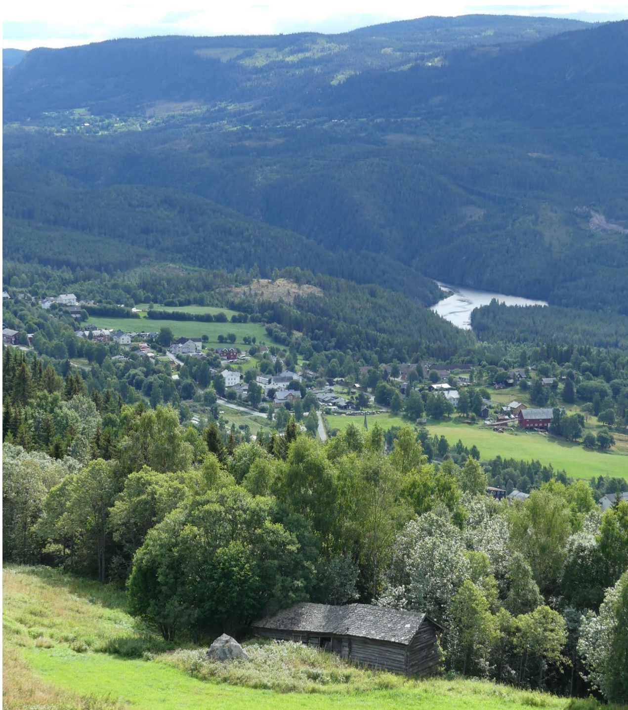
Figur 6: Der terrenget er bratt ligger utløene gjerne plassert i nedre kant av enga. Disse er ofte vanskelig tilgjengelige og lite egnet for ny bruk, noe som kan resultere i forfall og tap. Av 21 gjenstående utløer/sommerfjøs i Nord-Aurdal er 14 % av sterkt truet og 38 % truet. Foto: HT/ASPLANVIAK 2020 (5420019060).
