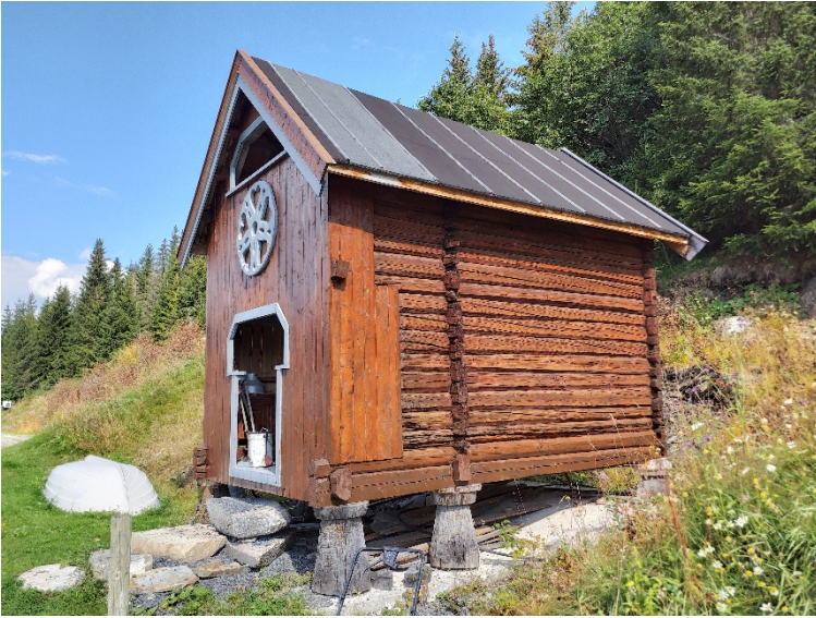
Figur 18: Flytting innenfor samme tun blir ikke registrert som tap, mens flytting til annet sted registreres som tap. Her et stabbur som er flyttet internt på tunet og satt i god stand. Utskifting av taktekking er en mindre endring (C). Foto: KSO/ASPLAN VIAK 2020 (5420001043).
