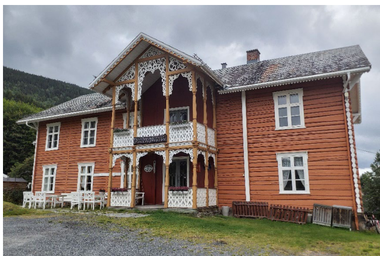
Figur 39: Frydenlund skyssstasjon i Aurdalsbyen er et godt eksempel på en uendret, godt vedlikeholdt bygning med høy kulturhistorisk verneverdi. Foto: KSO/ASPLAN VIAK 2020 (5420018044).
