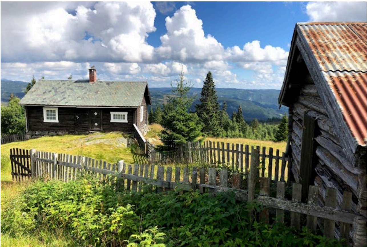
Figur 30: Selene på stølene har blitt tatt i bruk som fritidsboliger etter at seterdriften ble lagt ned. Selene er derfor gjennomsnittlig i bedre stand enn de øvrige utmarksbygningene. Her stølen Slettan. Foto: HT/ASPLAN VIAK 2020.
