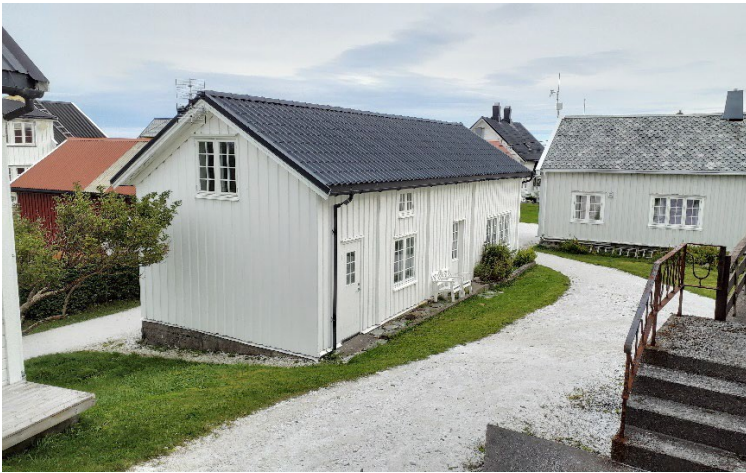
Figur 15: Eksempel på en liten endring (C). Bygningens karakter er noe endret gjennom generelt vedlikehold. Her er blant annet taket rehabilitert med nye takplater i metall. Foto: HT/ASPLAN VIAK 2020 (15480001005).
