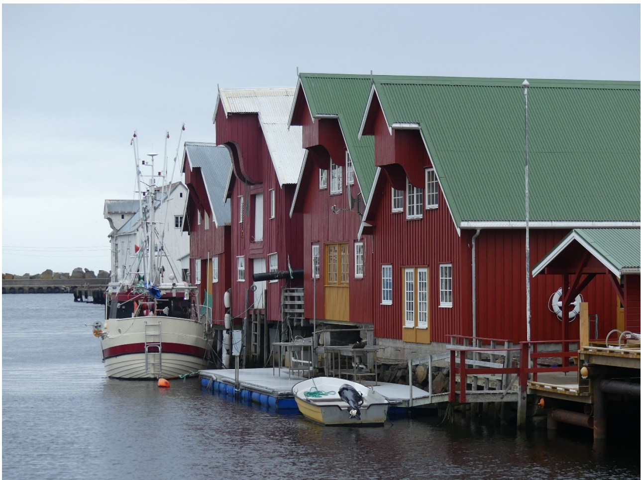
Figur 2: Naust, sjøhus og fyr utgjør 18 % av den kontrollregistrerte bygningsmassen på Fræna. Denne bygningskategorien har den laveste tapsandelen på kun 3 % i løpet av de 10 årene som har gått siden forrige registrering i 2010. Foto: HT/ASPLAN VIAK 2020.
