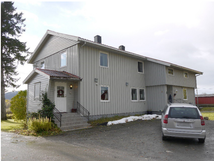
Figur 17: Eksempel på stor endring (A). Større ombygging, slik at bygningens opprinnelige volumkarakter er endret. Bildet over er samme bygning slik den ble SEFRAK-registrert i 1979. Foto: Å Damman/NIKU 2010 (15480012014).
