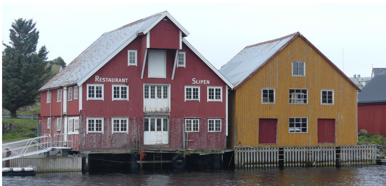
Figur 47: Bygningstypen sjøhus og brygger omfatter større bygninger over flere etasjer brukt til produksjon og lagring. I dag er mange tatt i bruk til nye næringer. Her et bilde fra miljøet rundt havna i Bud. Foto: HT/ASPLAN VIAK 2020.
