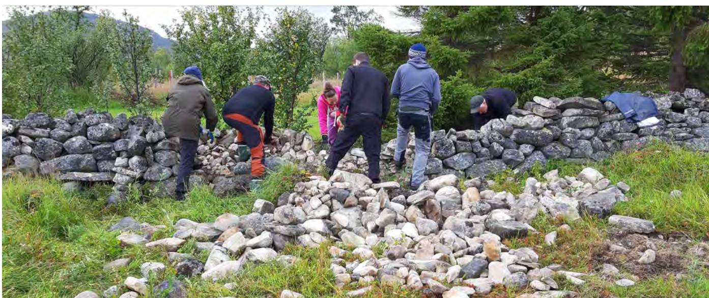
Arbeidsgjengen i gang med demontering av gammelt gjerde.
