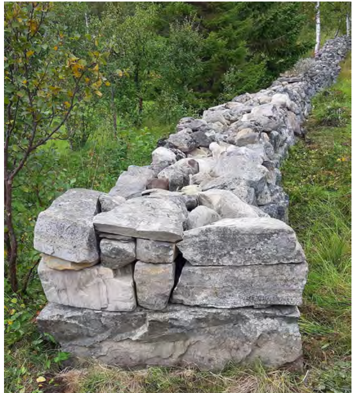
Ferdig reparert mur. Legg merke til hvordan kistemuren er bygd opp, med steiner på begge sider og deretter fylt igjen med mindre steiner.
