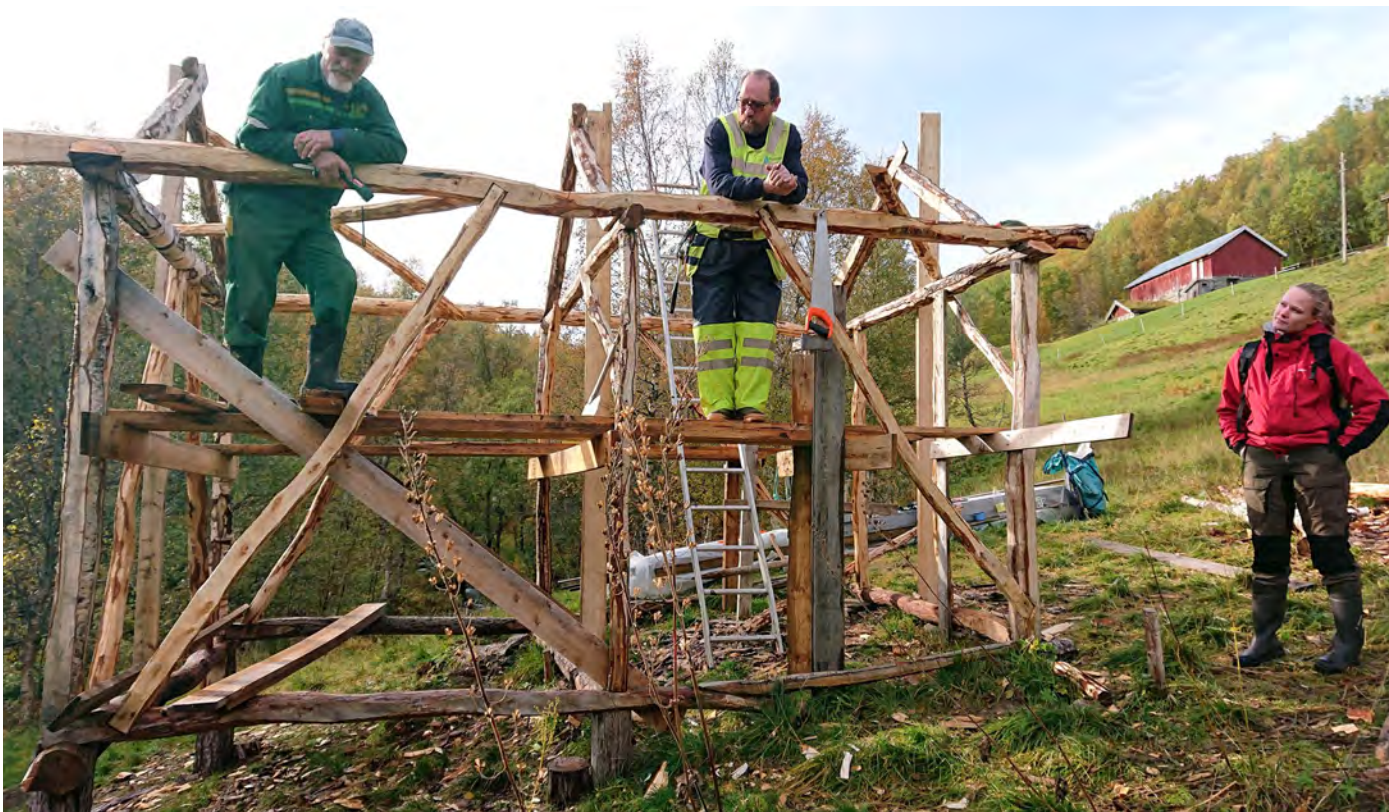
Bygging av høysjyttje i Kjelvika. Foto: Gerd Bente Jakobsen.
