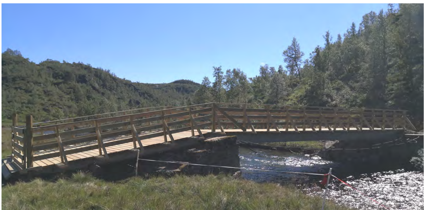
Brua er ferdig. Foto: Sveinung Havrevoll
