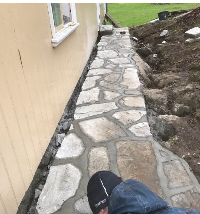
Pågående arbeid med gangvei ved gjestehuset. Alle foto: Hans Magnus Sætra
