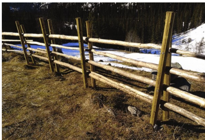
Fint nytt slåtegjerdje på Storstaul i Svartdal. Dette er ein gamal måte å gjerde på. Her ved bruk av liggande skanta grantre og impregnerte ståande stolpar. Foto: Gunleik Mæland
