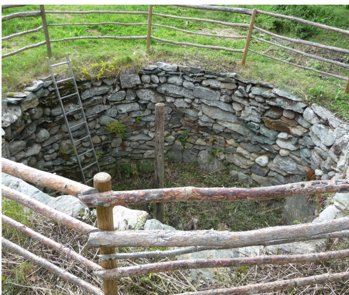
Ulvestugu. Ulvegrava har en diameter på ca. 4,7 m og dybden er ca. 2,8 m. Foto: Stig Horsberg
