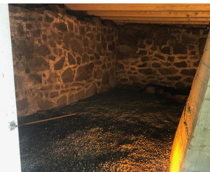
Øverst: Her skal det på plass ny låvebro. Nederst: Masseutskifting i gjødselkjelleren.
