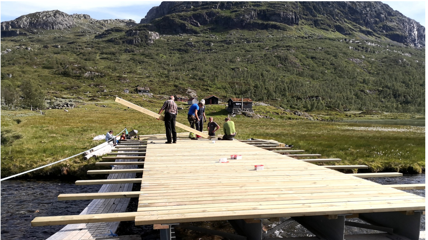
Brua under bygging, med ein del av arbeidsgjengen. Foto: Sveinung Havrevoll
