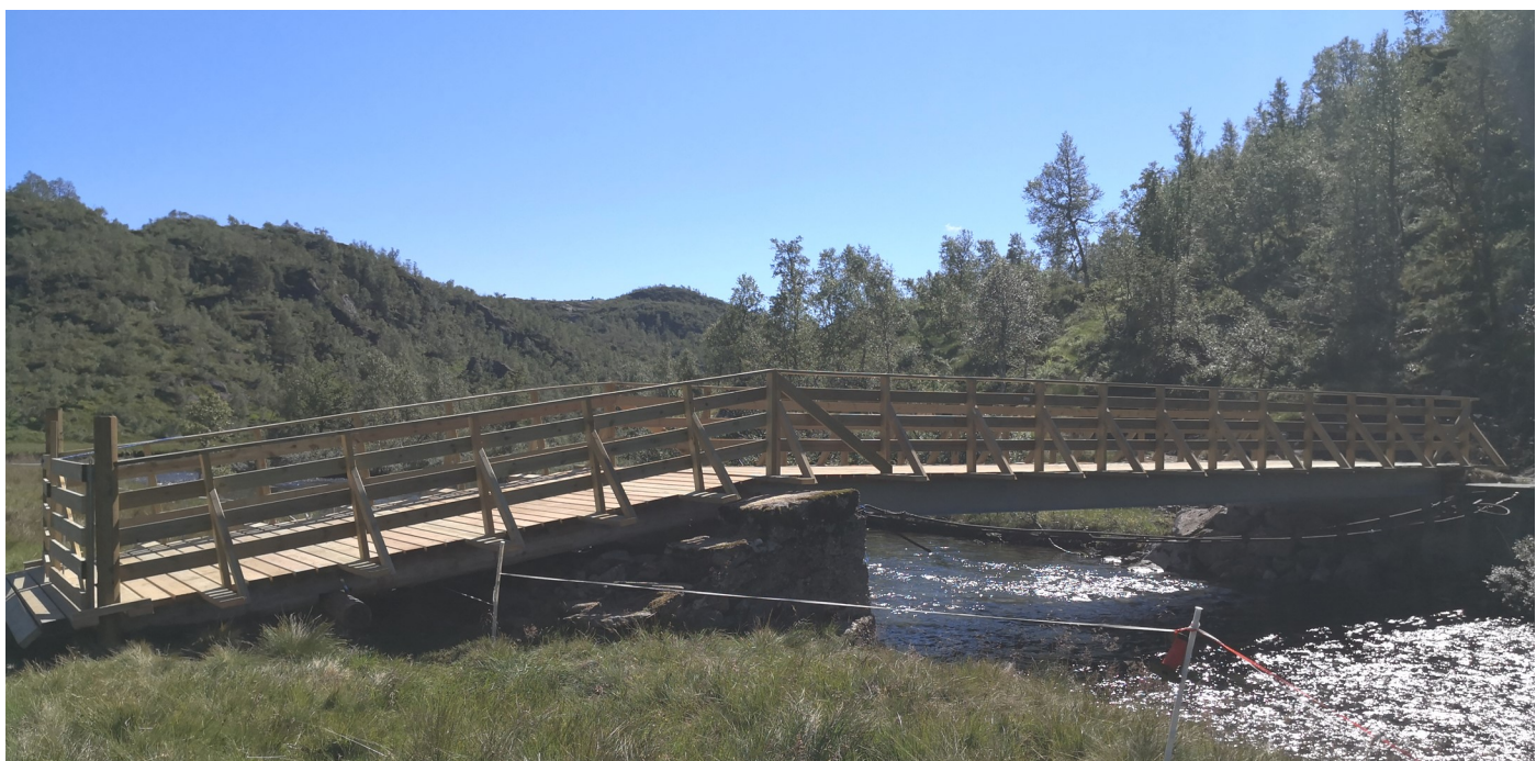
Brua er ferdig. Foto: Sveinung Havrevoll
