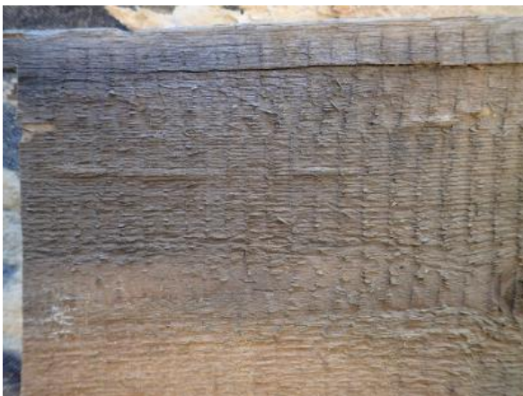
Foto 11. Angrep rett under overflaten kan oppdages ved at det tynne overflatesjiktet buler noe ut på grunn av det tettepakke boremålet i larvegangene.
