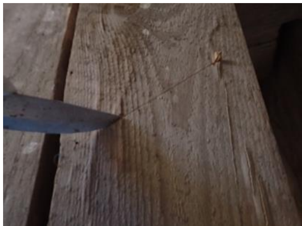
Foto 12. Bruk av kniv kan forenkle påvisningen av husbukkskader.
