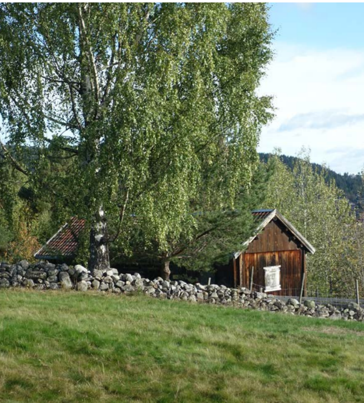
På Bergeløkka står en av de svært få gjenværende løkkelåvene på sin opprinnelige plass, og med alle funksjoner bevart: oppholdsrom, høyla, redskapsrom og dø. Foto: Jørn Jensen, Viken fylkeskommune
