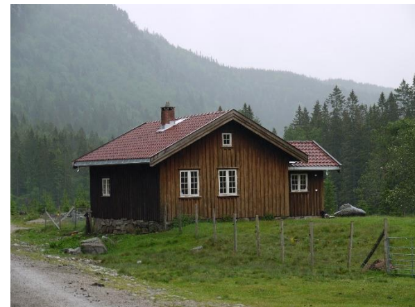
Venstre: Skogstua på Årmodt ble registrert som uendret og truet i 2014. Høyre: I 2019 var huset istandsatt og det ble registrert som intakt (god teknisk tilstand). Takteking, panel og vinduer var fornyet, og nytt inngangsparti var tilbygd, slik at huset ble registrert med B-endring (mindre volumendring) (08210008153). Foto: ÅD/NIKU 2014 og 2019
