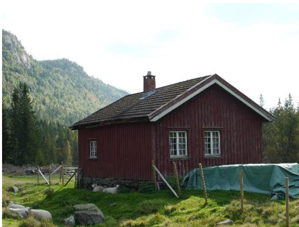
Venstre: Skogstua på Årmodt ble registrert som uendret og truet i 2014. Høyre: I 2019 var huset istandsatt og det ble registrert som intakt (god teknisk tilstand). Takteking, panel og vinduer var fornyet, og nytt inngangsparti var tilbygd, slik at huset ble registrert med B-endring (mindre volumendring) (08210008153). Foto: ÅD/NIKU 2014 og 2019
