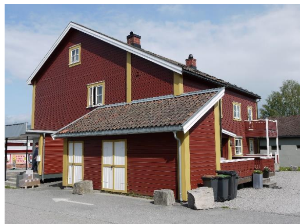
Venstre: Våningshuset på Brenne er tilbakeført til sveitserstil og er registrert som B-endret og «tilbakeført til eldre uttrykk» (08210004024). Høyre: Et eldre tilbygg med saltak er revet og erstattet med nytt tilbygg med pulttak. Bygningen er registrert med B-endring og «deler av hus revet» (08210008034). Foto: ÅD/NIKU 2019
