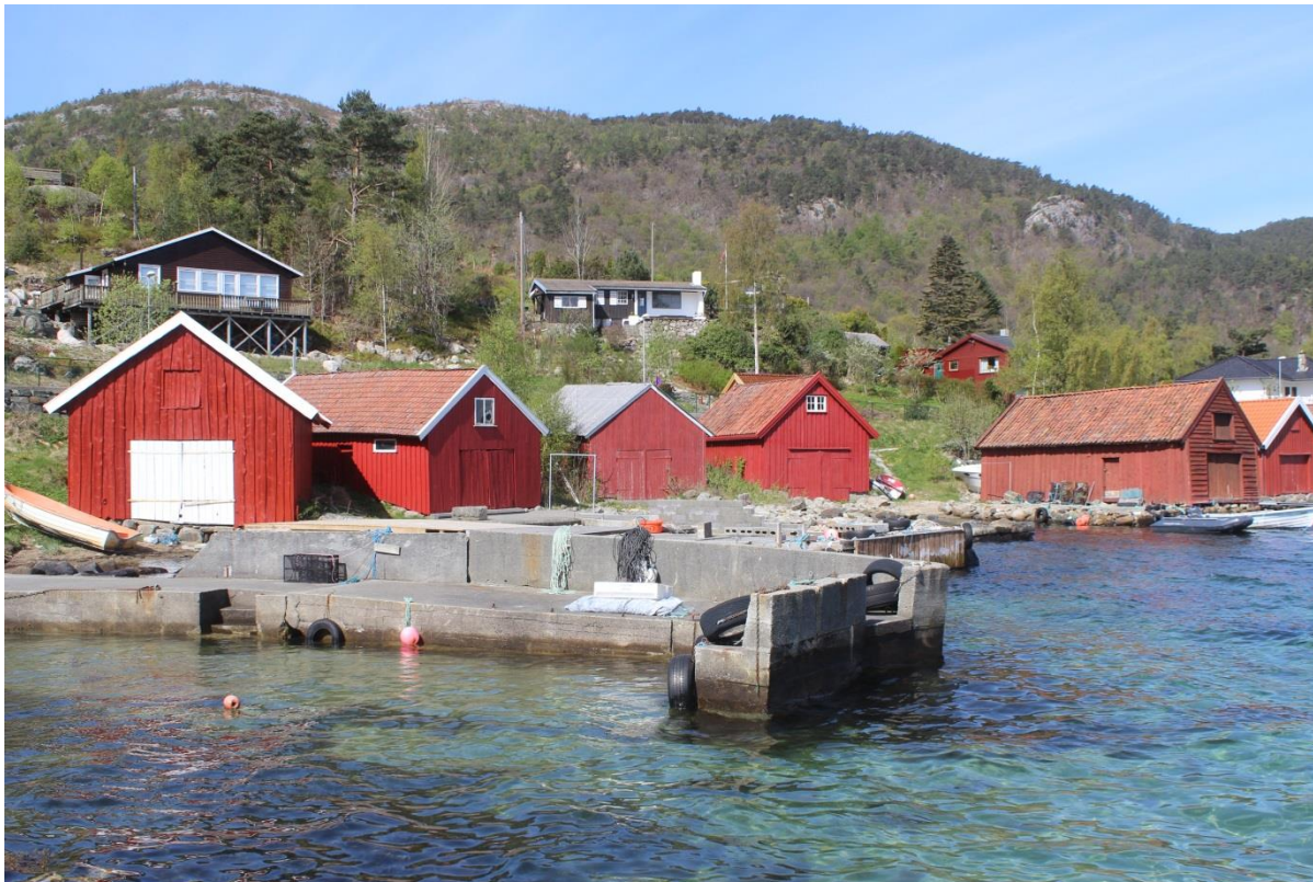
44 SEFRAK-registrerte sjøhus og naust ble undersøkt i Sandnes. Ett var tapt, åtte av de gjenstående var truet av forfall, men ingen var sterkt tuet. Naust og sjøhus har få volumendringer (9 %) (11020034045). Foto: RM/NIKU 2017
