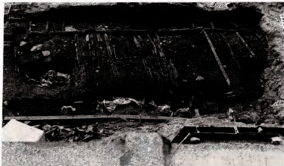
Fig. 36. Fase 8. Bygning K347 på tomt 2B + 3 fra N. Foto: RA 1985.
