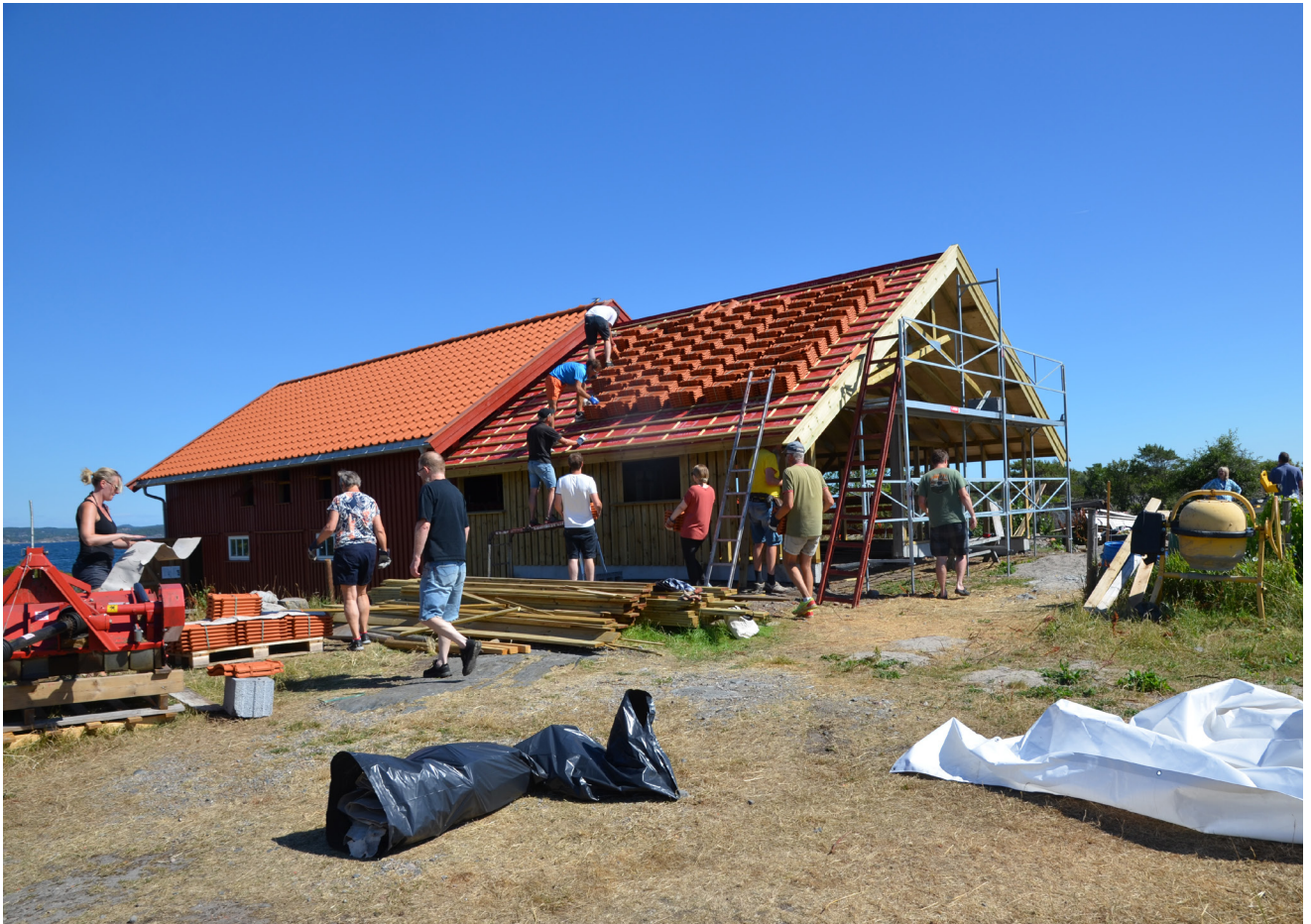
Tilbygg for villsauene. Det var ikke noe å si på dugnadsinnsatsen når taksteinen skulle på plass.
