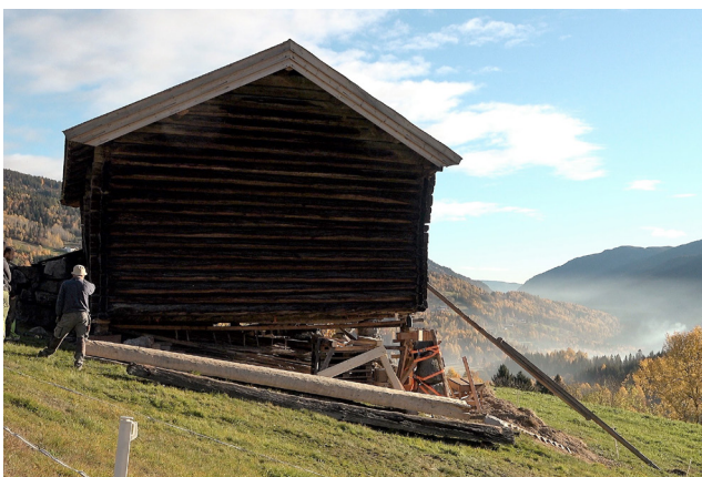
Restaurering av låven på den freda garden Sud-Åbø i Hjordal. Dei som restaurerer, venta lenge på å få tak i ein høveleg, lang, tettvaksen stokk som kunne brukast til dette. Foto: Videoarkivet AS, Seljord
