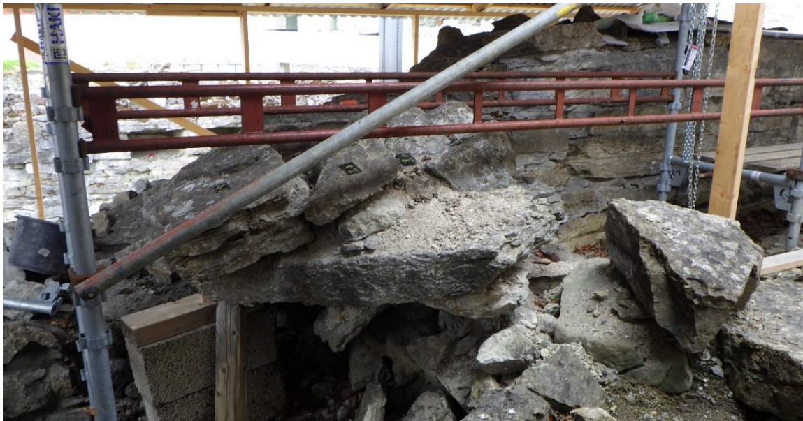
Situasjonen i Kns sørligste del slik den var ved oppstart i 2018.
