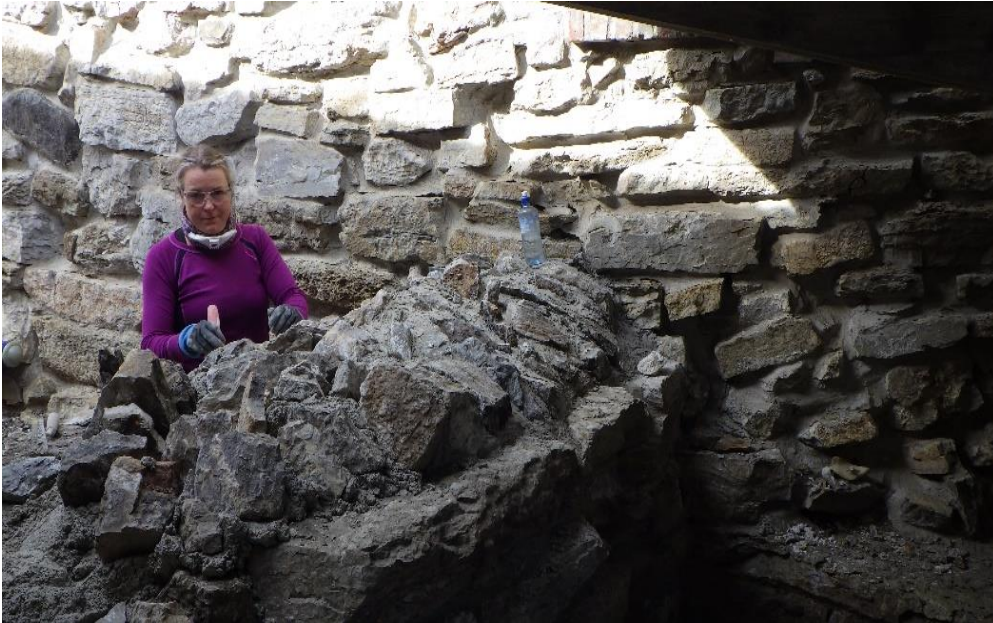
Anne Kathrine pinner og spekker fugene rundt de murte steinene i toppdekket.
