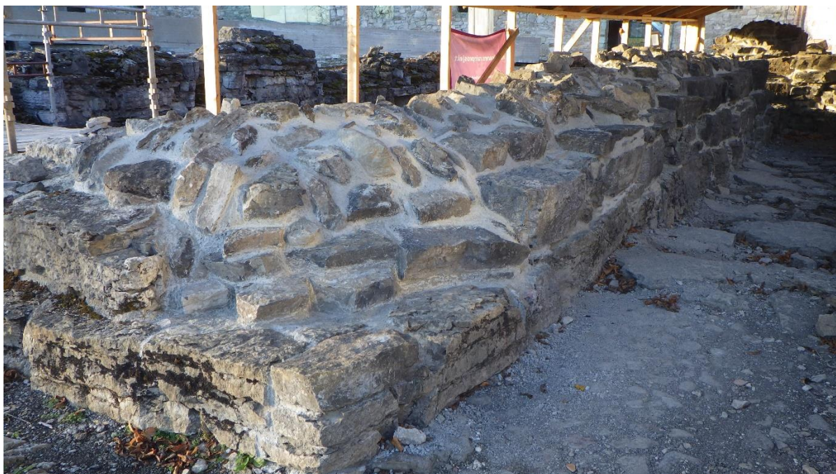
Toppdekket på nordre murverk i tårnet, sett mot vest.
