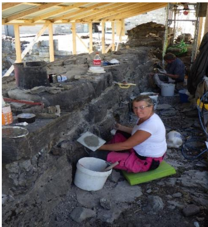
Anne Kathrine og Tom spekker vangene i nordre murverk på tårnet med egenbrent kalk.
