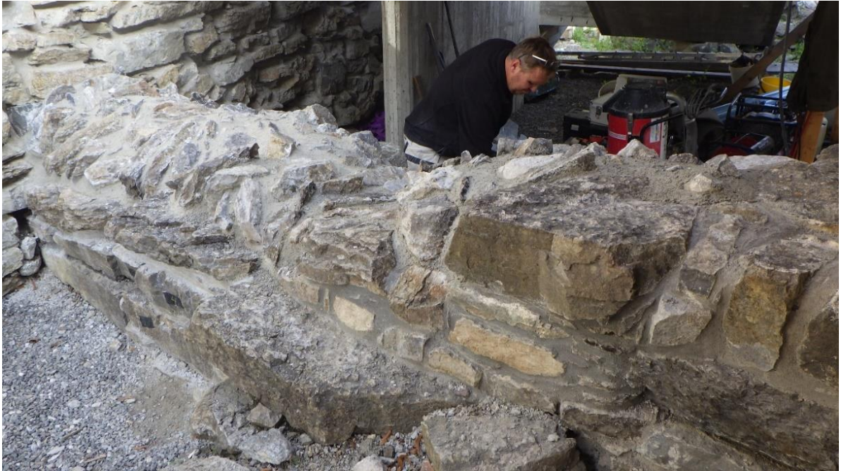
Kn sett mot øst, ferdig restaurert.
