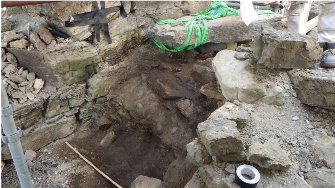
Lagstrukturen i Kn i sør. Til venstre sees nordre tårnmur, lengst til høyre sees feltet der de to murverkene Kn og Km møtes.
