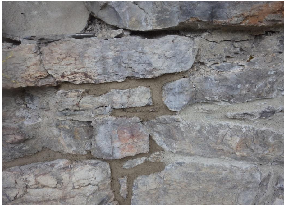
Bildet av prøvefelt (2017) med egenbrent kalk til venstre, originalt kalkmørtel oppe til høyre, og brent kalk fra Franzefoss nede til høyre.
