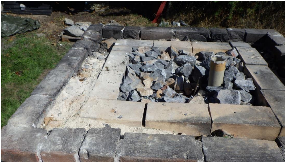
I årets andre kalkbrenning ble kalkovnen ble fylt med knyttnevestor kalkstein.
