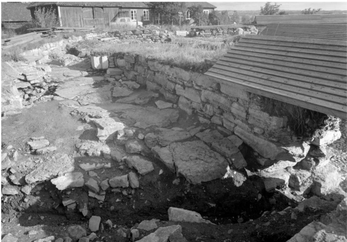
Nordre tårnmur sett mot øst i 1957. Det gjennombrutte feltet i muren fra 1700-tallet sees til høyre i bildet. Foto: R. Normann, 1957.
