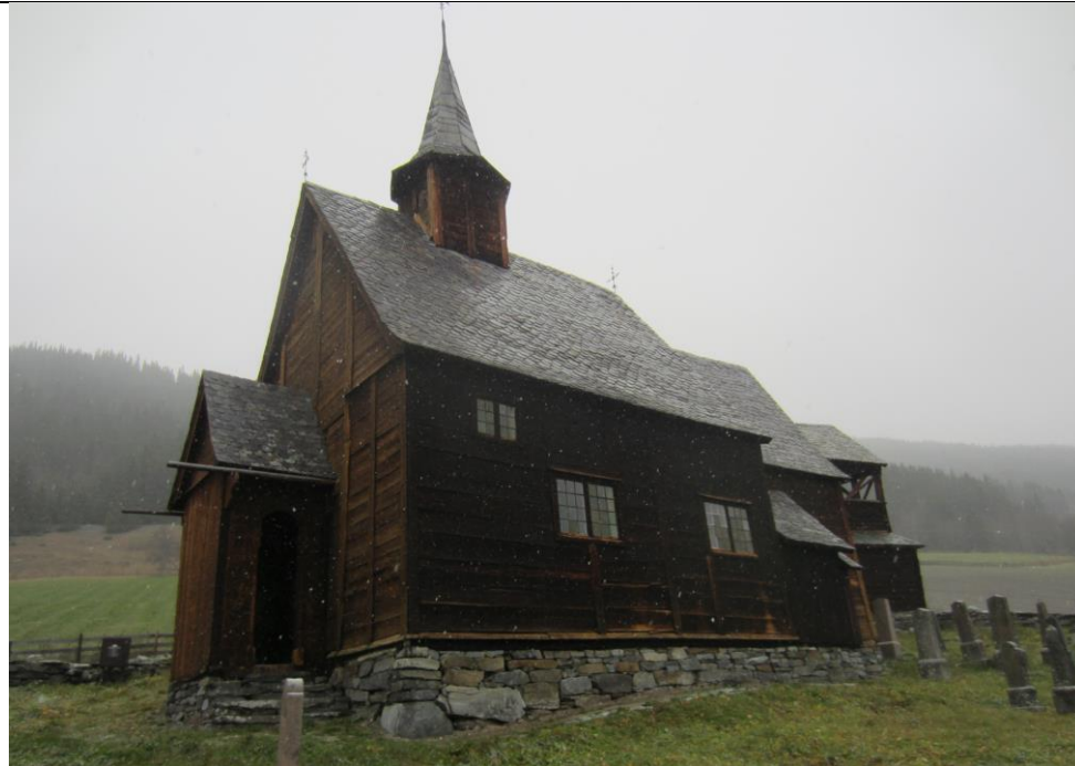
Kirken sett fra sydvest. Inngangen til «våpenhuset» er fra sydsiden.
