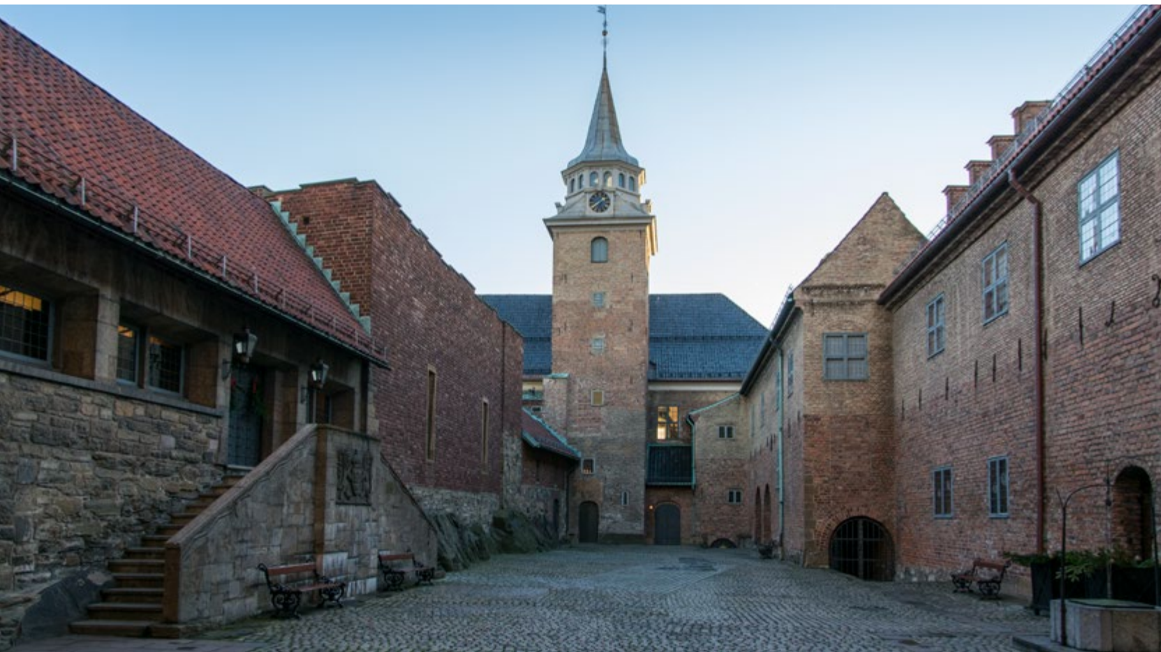
En heis i Blåtårnet (Akershus) med inngang fra Borggården vil gi tilgang til festsalen, slottskirken, langkjelleren og mausoleet. Dette er en god begynnelse, men fortsatt gjenstår det mye arbeid for at anlegget blir godt nok tilrettelagt for alle brukerne. Foto: Dagfinn Rasmussen
