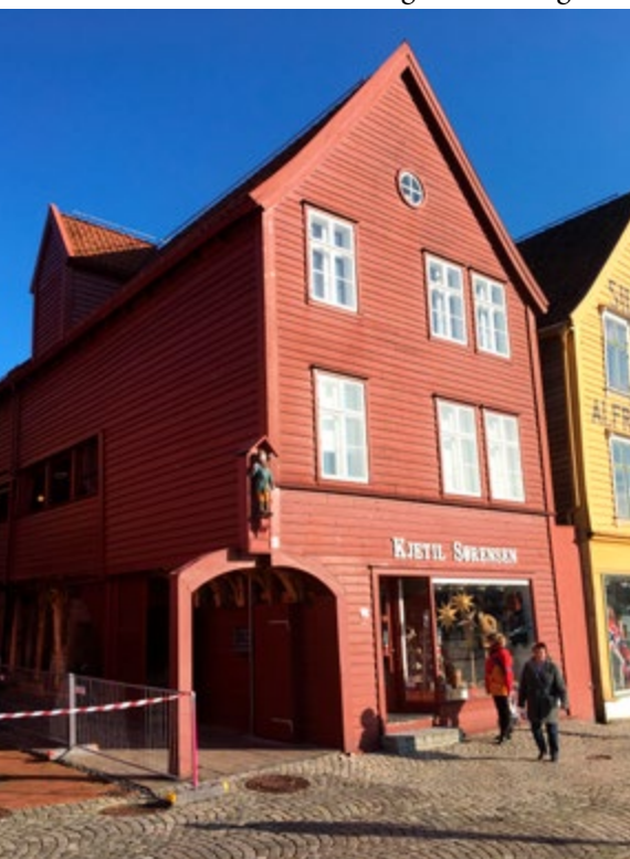
Garmokirka på Maihaugen, Skoger Gamle kirke ved Drammen, Raulandstua på Folkemuseet og Bugården på Bryggen i Bergen er alle med i miljøovervåkningsprosjektet. Foto: NIKU
