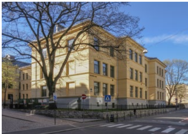
Møllergata skole er den eldste skulen i Oslo. Skulen sto ferdig i 1860, og vart tatt i bruk våren 1861. Foto: Anders Amlø, Riksantikvaren
