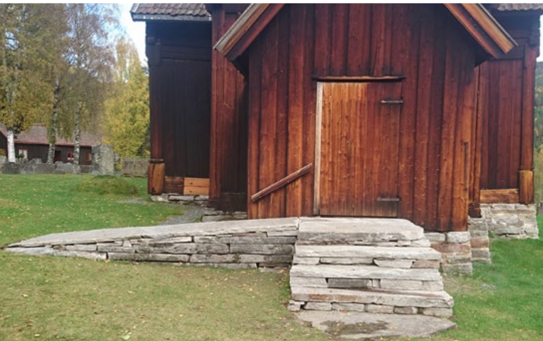
Ved Rollag stavkirke har det nylig blitt gjennomført flere tilgjengelighetstiltak. Til venstre ser vi bilde av hovedinngangen hvor det har kommet på plass en ny rampe og trapp. For at ikke rampen skulle bli for stor og dominerende i møtet med den lille kirken har den fått en stigningsgrad på 1:12. Materialene man har valgt harmonerer også med eksisterende elementer, både i uttrykk og utførelse. Hele konstruksjonen er tørrmurt og den originale trappen er bevart under den nye. Foto: Flavio Carniel/Hege Sejnæs Eilertsen
