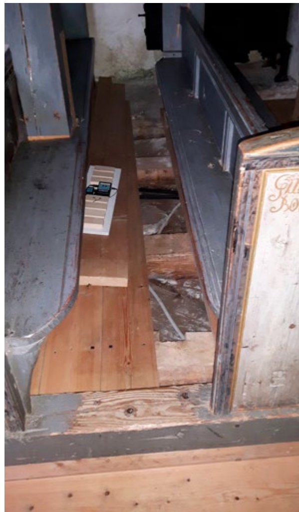
Klimapanel blir montert under gulvbjelkene i Skoger gamle kirke. Foto: Marte Boro, Riksantikvaren
