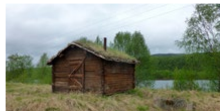
Masi i Kautokeino kommune, Finnmark. Den gamle posthytta står ved Luoddikohka på Turi-gården som et minne om den gamle postveien mellom Alta og Kautokeino som gikk forbi her. Den er en automatisk fredet samisk bygning. Foto: Ingegerd Holand, Riksantikvaren
