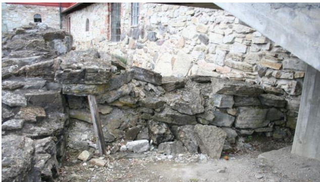
Foto av Kn mot vest og øst. Viser dagens situasjon.
