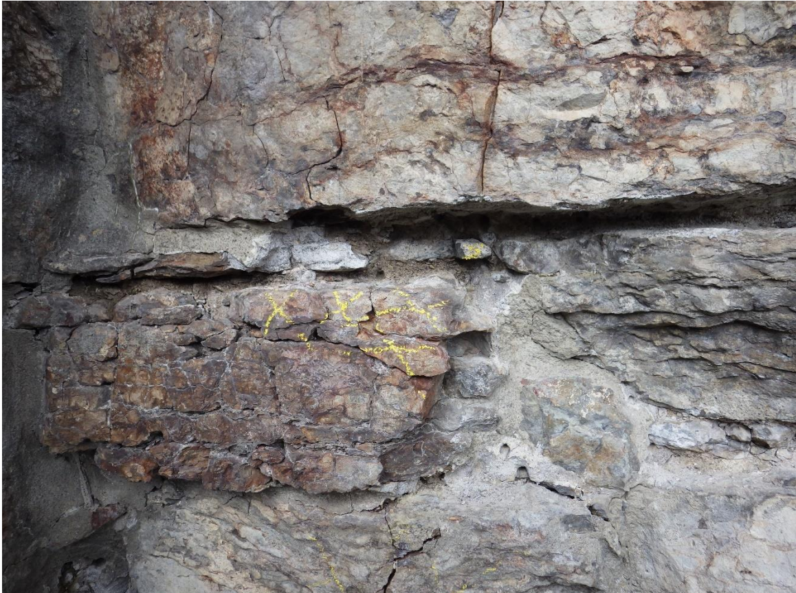
Rødbrent, varmeskadet og fragmentert vange. Hver stein krever mye limearbeider.
