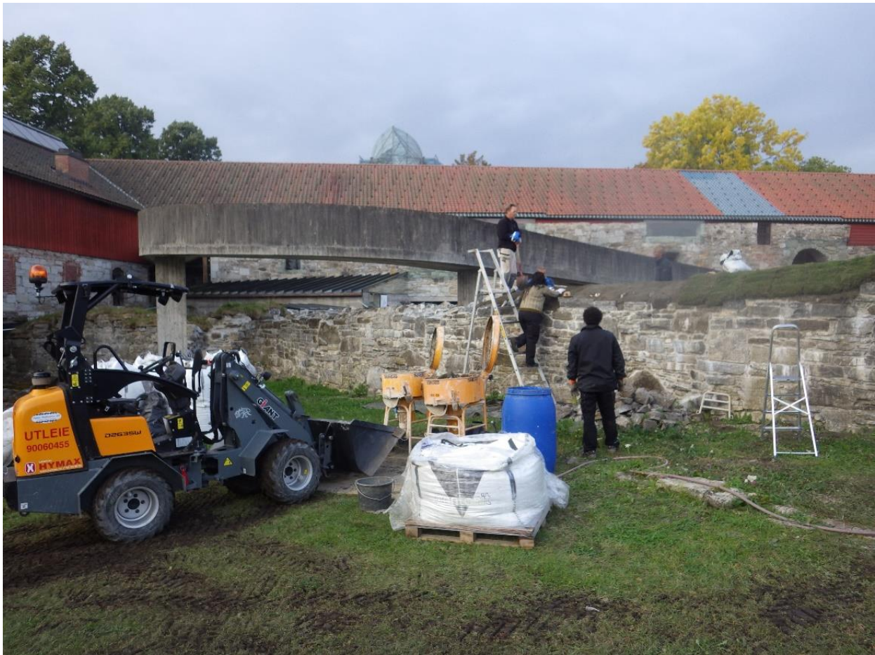
Dugnadsarbeid på museet for legging av toppdekke.
