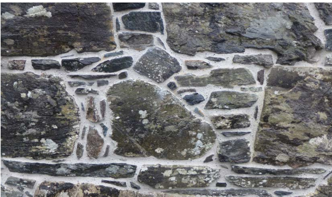
Figur 8. Nylig istandsatte murfuger i vestmurens ytterliv i dagrommet, murt i NHL-mørtel styrke 3,5 (Foto: Byantikvaren 2016).
