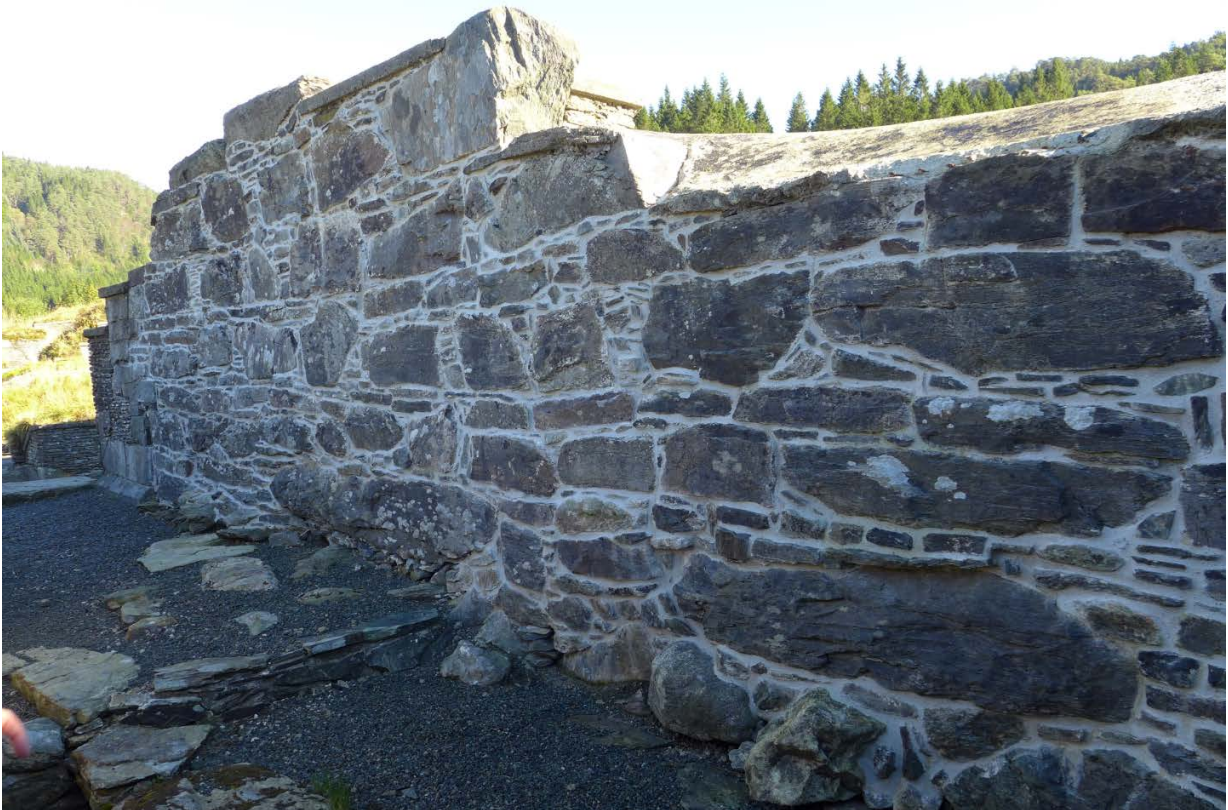
Figur 14. Ferdig istandsatt ytre murliv i vestmuren i dagrommet (Foto: Byantikvaren 2016).
