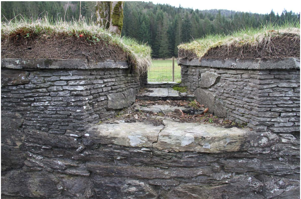
Figur 9. Vindussmyget i sørveggen i dagrommet før istandsetting (Foto: Byantikvaren 2012).
