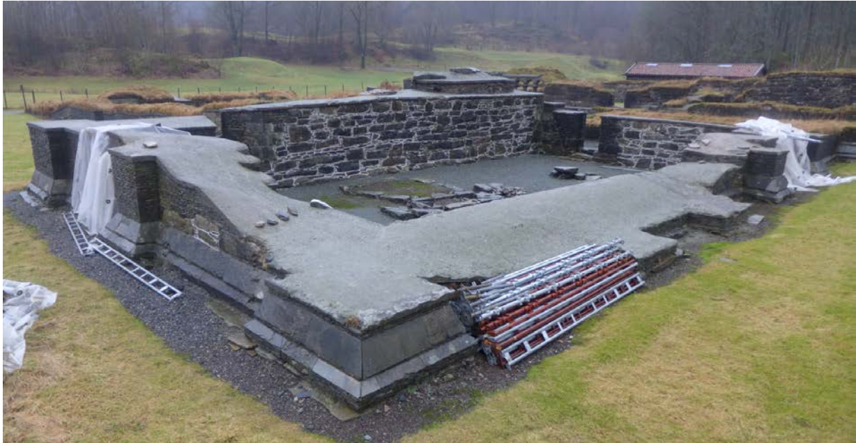
Figur 15. Dagrommet uten torv på murkronene fotografert mot NV (Foto: Byantikvaren 2017).
