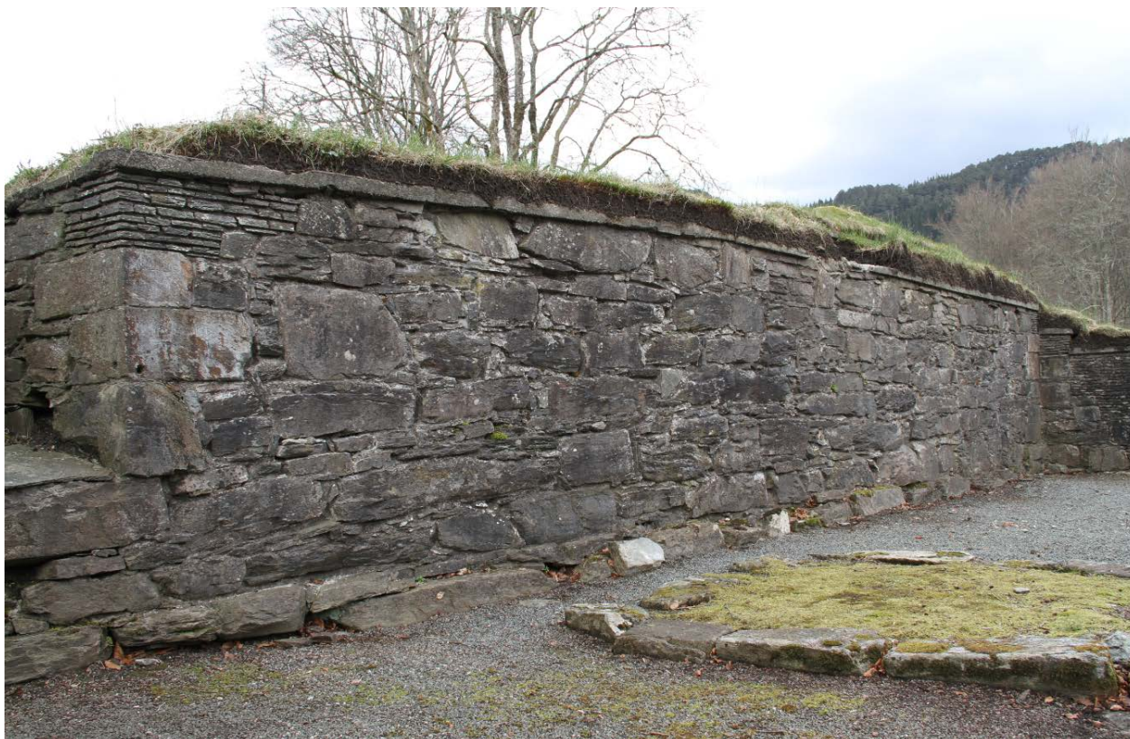
Figur 11. Før tiltaket var murlivet i østmuren i dagrommet spekket med en hard KC-mørtel og murkronen bestod av tykke torvlag over et armert sementdekke (Foto: Byantikvaren 2012).
