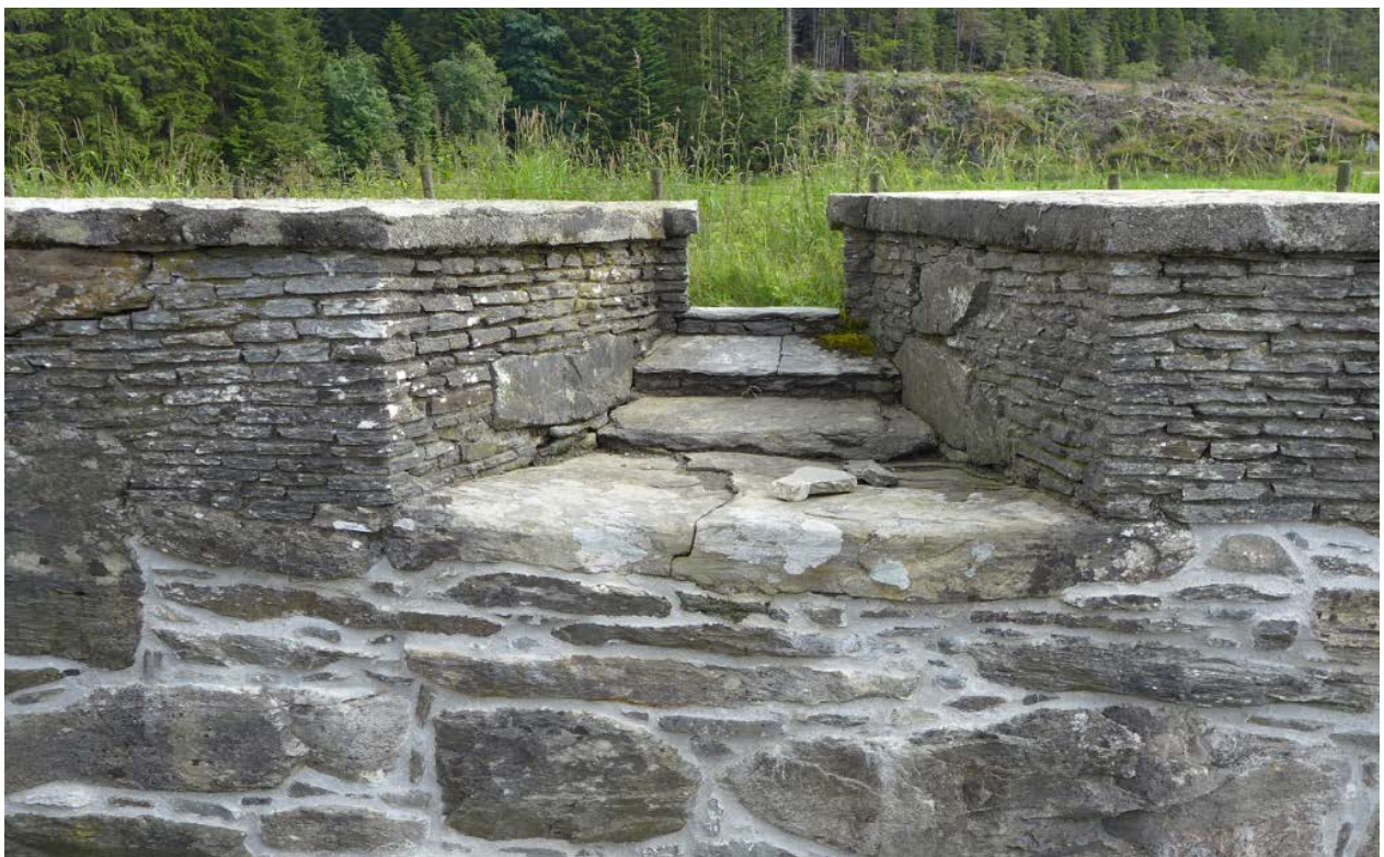
Figur 10. Etter tiltak: Vindussmyg i sørveggen i dagrommet ferdig sikret og konserververt (Foto: Byantikvaren 2016).
