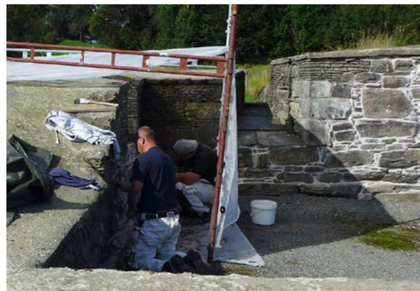
Figur 6. Konservering av indre murliv i sørmuren i dagrommet (Foto: Byantikvaren 2016).
