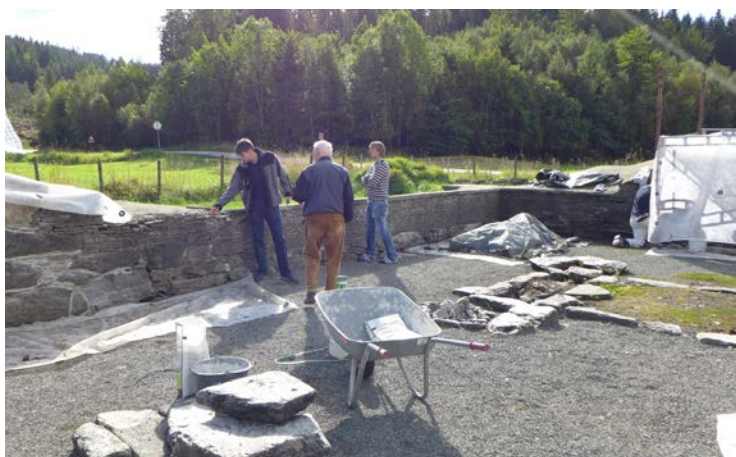
Figur 22. Heming Hagen fra Byantikvaren, murer Geir Magnussen og Hans-Emil Lidén inspiserer murkronen i dagrommet (Foto: Byantikvaren 2017).
