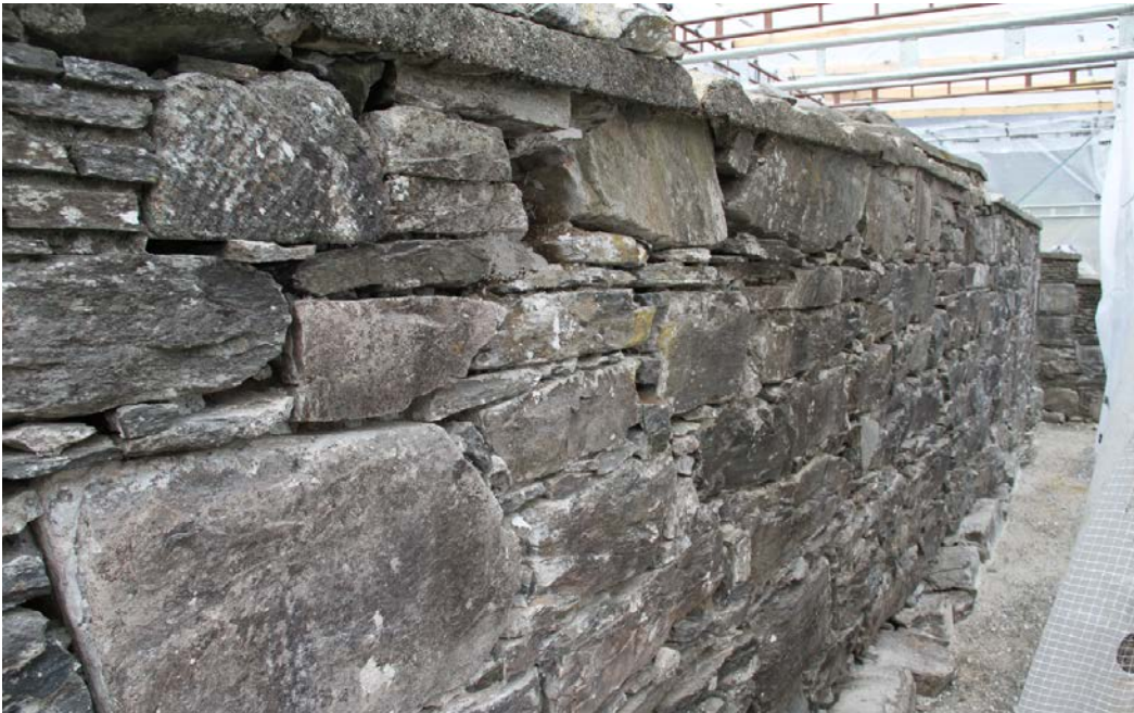
Figur 7. Indre murlivet i vestmuren med utmeislete fuger (Foto: Byantikvaren 2016).
