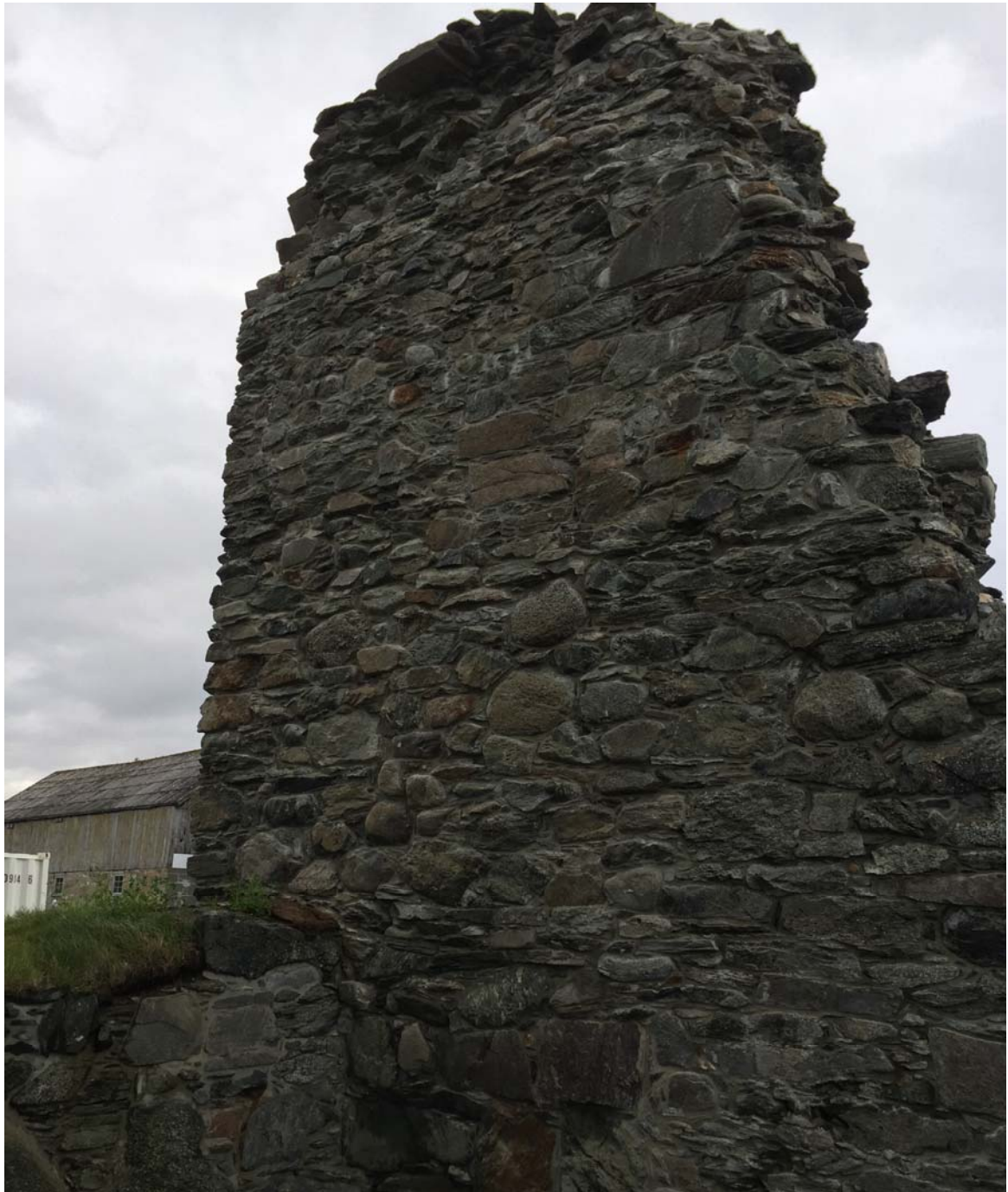
Nord østre vegg utvendig mot sakristi etter fullført konservering.
