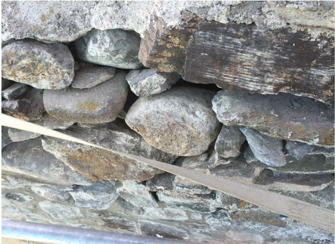
Bilde fra skipets østvegg utvendig under arbeid. Store deler av murverket er nymurt og delvis tørrmurt utenpå original middelalder kjerne. Det er spekket helt inn til murkjernen i en dybde på 50-70 cm som tilsvarer dybden inn til middelalderkjernen i murverket.
