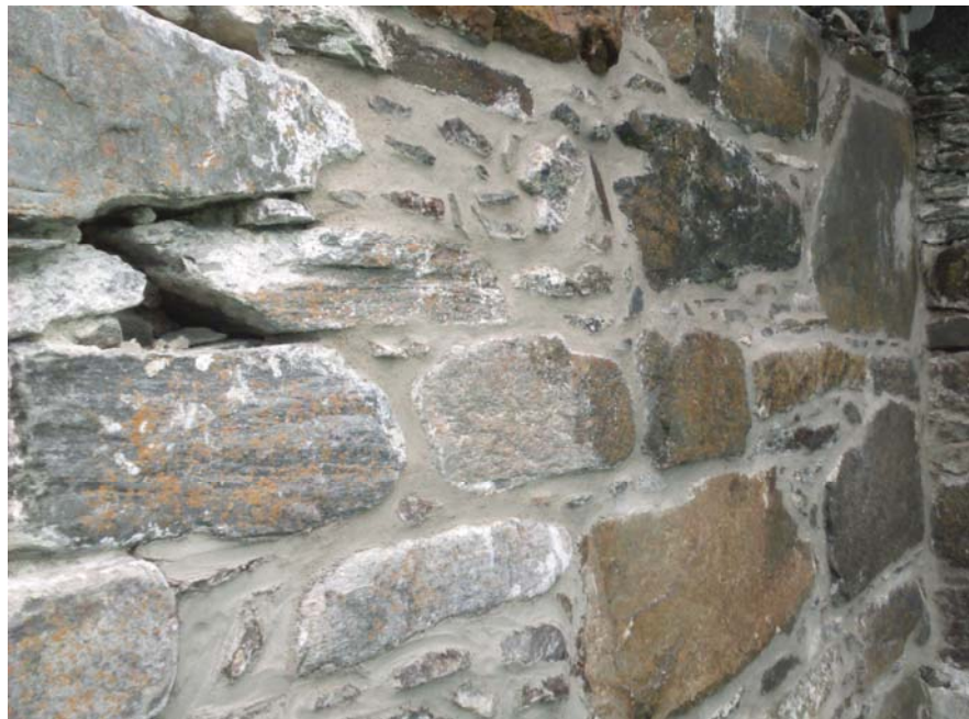
Bilde fra skipets østvegg utvendig under arbeid. Store deler av murverket er nymurt og delvis tørrmurt utenpå original middelalder kjerne. Det er spekket helt inn til murkjernen i en dybde på 50-70 cm som tilsvarer dybden inn til middelalderkjernen i murverket.
