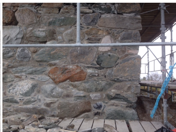
Bildene viser spekking av østvegg mot parkeringsplass under arbeid med spekking og pinning av murverket.
