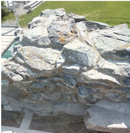
Bildet til venstre viser ferdigstilt topp av mur med nymurt toppdekke sett fra nord. Bildet til høyre viser ferdigstilt topp av mur med toppdekke sett fra øst.
