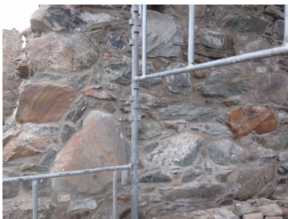
Bildene viser spekking av østvegg mot parkeringsplass under arbeid med spekking og pinning av murverket.
