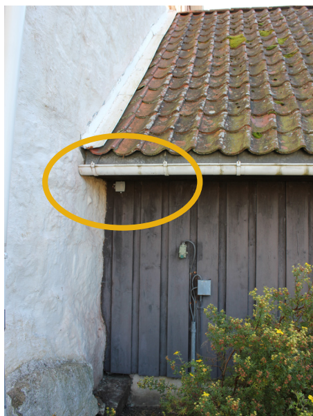
I Ingedal kirke er utesensor montert under raftet på våpenhuset. Sensor for temperatur og fuktighet i kor er trådløs, og kan legges slik at den måler inneklimate i nærheten av interiør og kunst. Foto: Kjersti Ellewsen, Riksantikvaren
