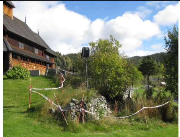
I skråningen sør for kirka hadde deler av muren rast ut.
