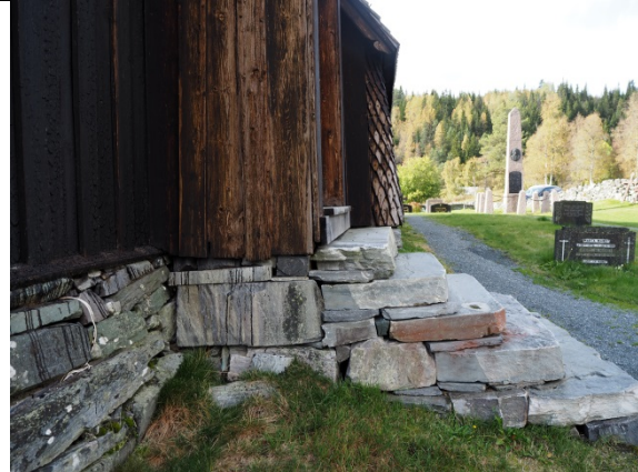
Trappetrinnene i stein opp til sakristiet burde i utgangspunktet helle utad for å slippe at vann samles.
