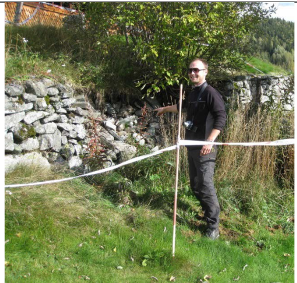
I skråningen sør for kirka hadde deler av muren rast ut.
