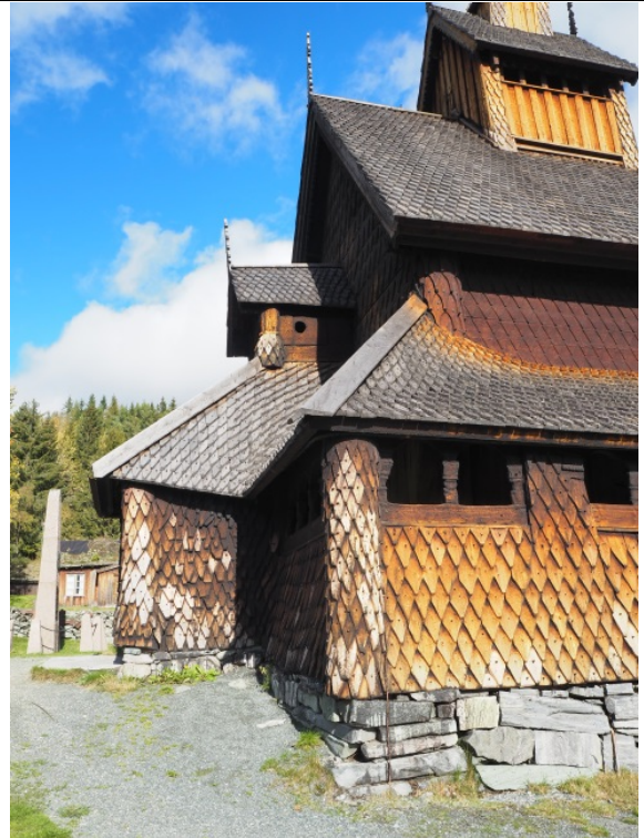
Sydøstre hjørne av kirka. Legg merke til taket over inngangspartiet og svalgangen. Disse er sikret med strekkfisk i metall.
