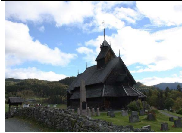
Kirka sett fra parkeringsplass i nordvest. Liten portal i kirkegårdsmuren sees til venstre i bildet.
