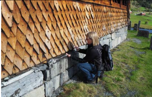
Hjørnet mellom svalgang og inngangsparti; vestvegg mot sør. Svillen viser viser råte og tegn på kraftig fuktbelastning.
