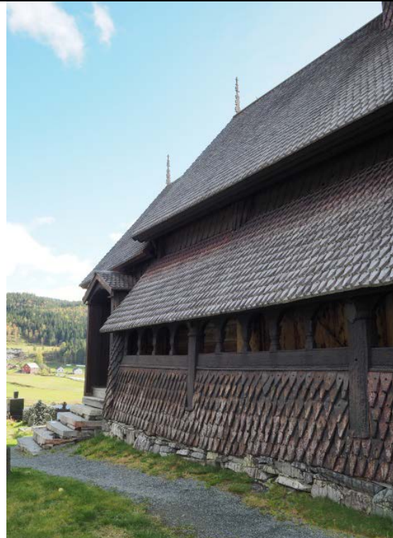
Nordsida og svalgang. Her er grunnmuren eldre og betraktelig lavere. Det vokser gress helt opp inntil muren, men det fantes ikke noen tegn på for høy fuktbelastning.
