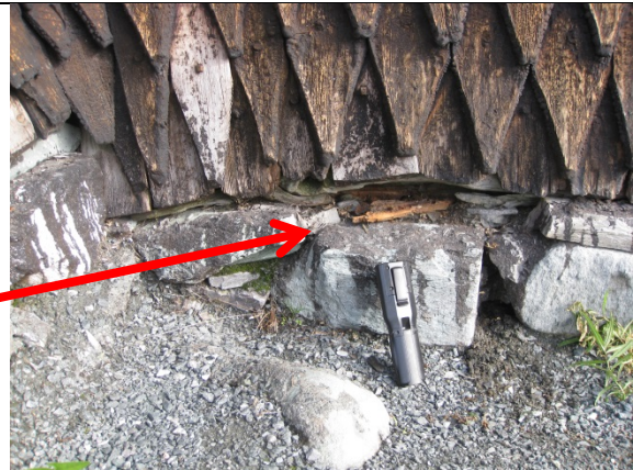
Hjørnet mellom svalgang og inngangsparti; vestvegg mot sør. Svillen viser viser råte og tegn på kraftig fuktbelastning.
