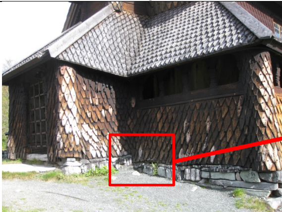
Hjørnet mellom svalgang og inngangsparti; vestvegg mot sør. Svillen viser viser råte og tegn på kraftig fuktbelastning.
