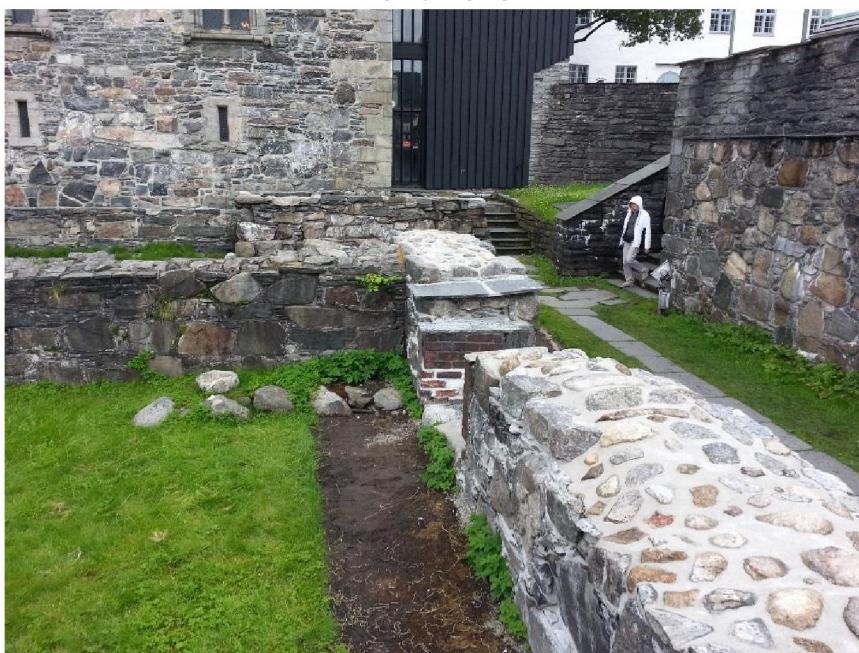
Vesle Steinhall, sørmuren etter utbedring
