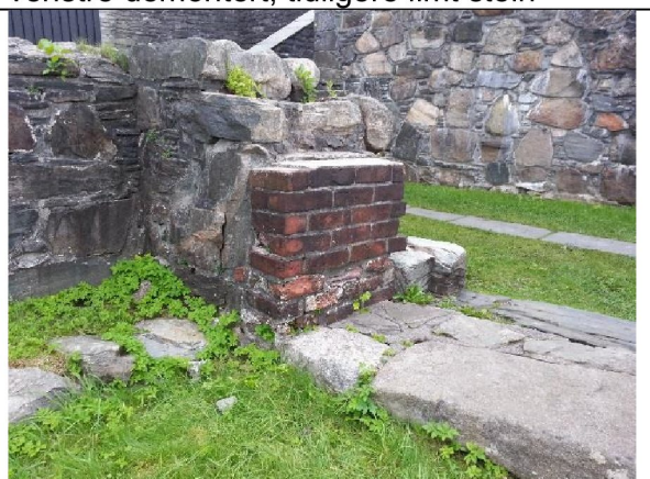
Døråpning med østre del av sørmuren sett fra NV. De nederste skiftene i teglvangen består av originale middelaldertegl som kan være det eldste eksempelet på bruk av tegl i Bergen
