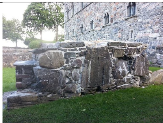
Østre del av sørmuren sett fra S. Nederst mot bakken ble det laget åpne fuger uten mørtel for å hindre frostsprengning. I 2016 ble det også gjort en mindre utbedring av fuger på innsiden av muren, øst for teglvangen til venstre
