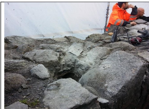
Murkronen i sement over middelaldermuren var tykkere enn antatt og svært krevende å fjerne
