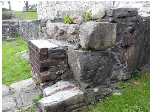
Sørside av mur med inngang inn til rom 1
