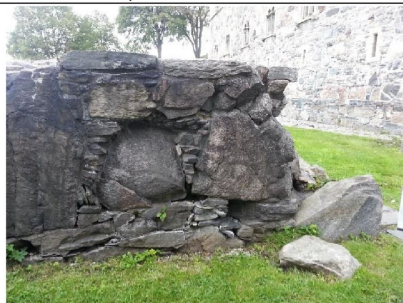
Sørside av mur, østre del mot Håkonshallen
