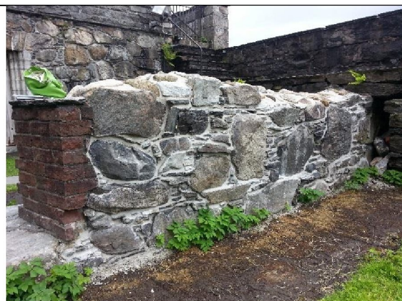
Sørsmuren, vestre del, sett fra innsiden (fra NØ) av rom 1
