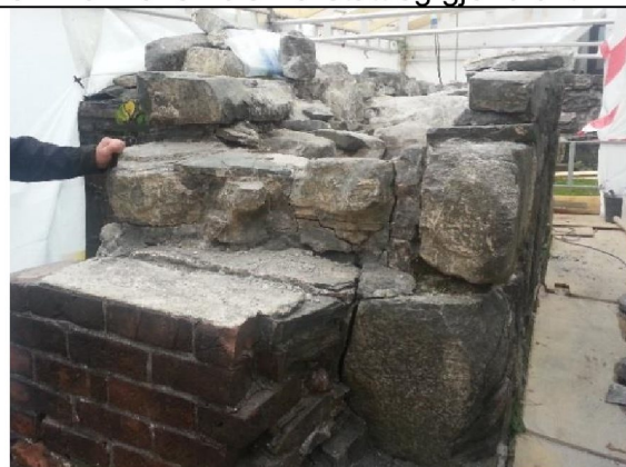
Østre del av muren med murvange inn til rom 1 etter at sementkrone og hellere over de laveste punktene er fjernet
