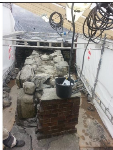
Murkronen i sement over middelaldermuren var tykkere enn antatt og svært krevende å fjerne
