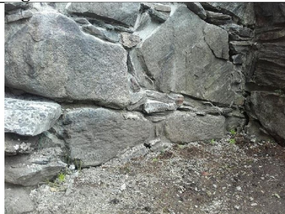
Nordsiden av murvange (sørmuren), parti innerst mot langmur som går parallelt med Håkonshallen, utkrasset og før refuging
