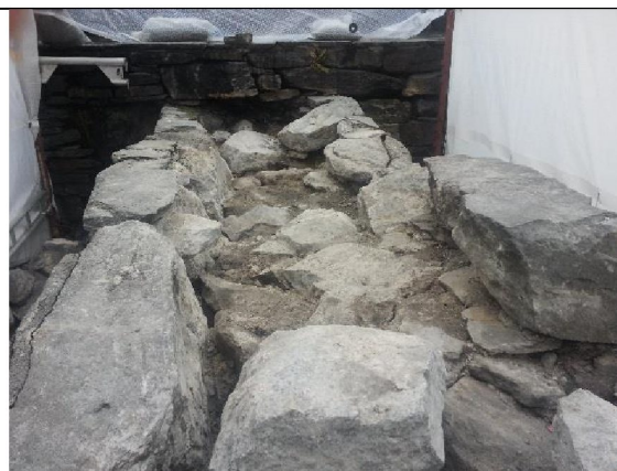
Øverste del av murkrone fjernet i mur mot vest. Steinene ytterst i murskallet lot man stå for at ikke ruinen skulle bli destabilisert før arbeidet kunne starte opp
