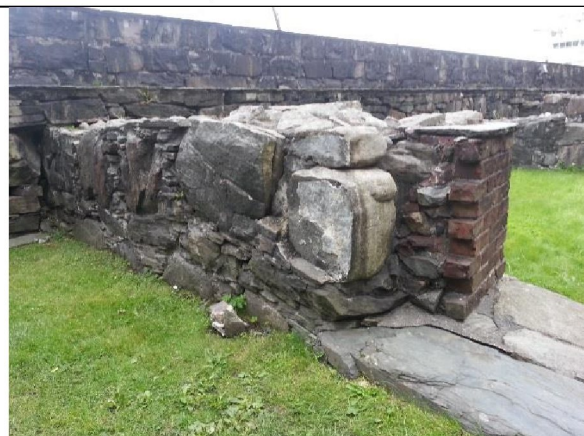
Sørside av mur, vestre del mot Vågen
