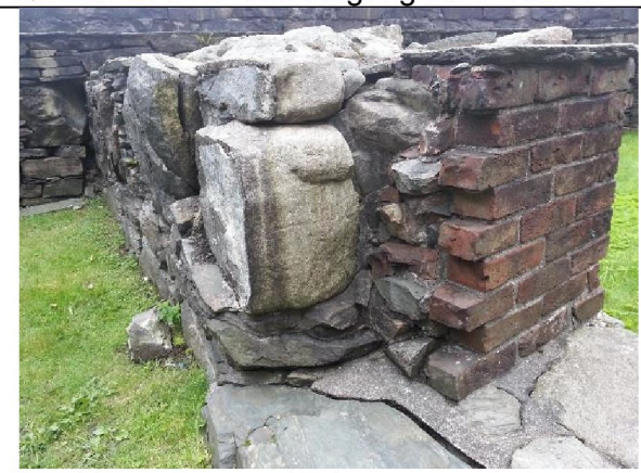
Sørside av mur med rekonstruert teglvange, på vestsiden av åpning inn til rom 1. Til venstre demontert, tidligere limt stein
