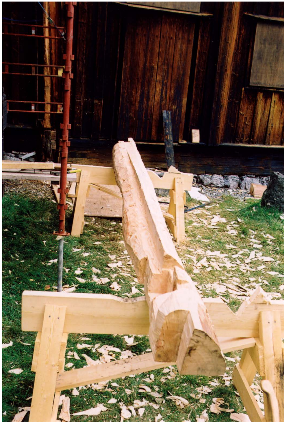
Stav: Ny spuns forma etter resterande SØ- hjørnestav. Spunsen i malma furu vart montert med tradisjonelle handverksmetodar. Foto: Riksantikvaren
