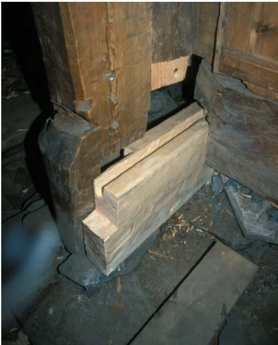
Svill og stav: Utbetring av forbindinga mellom bygningsdelar. Foto: Riksantikvaren
