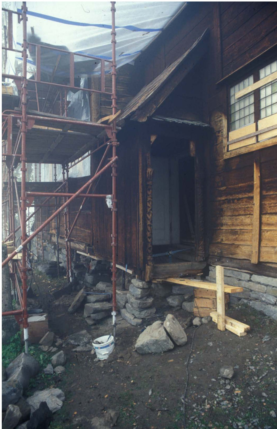
Bislag: Utbetring av muren under bislaget. Foto: Ellen M. Devold, Riksantikvarens arkiv.
