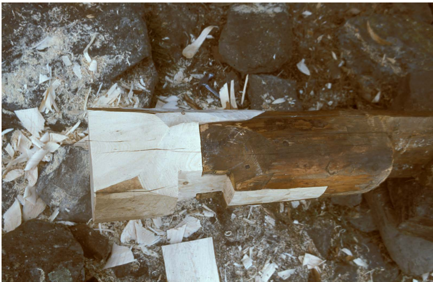
Spunsing: Utbetring av stokkar i støpulen. Foto: Hans Marumsrud, Riksantikvarens arkiv.
