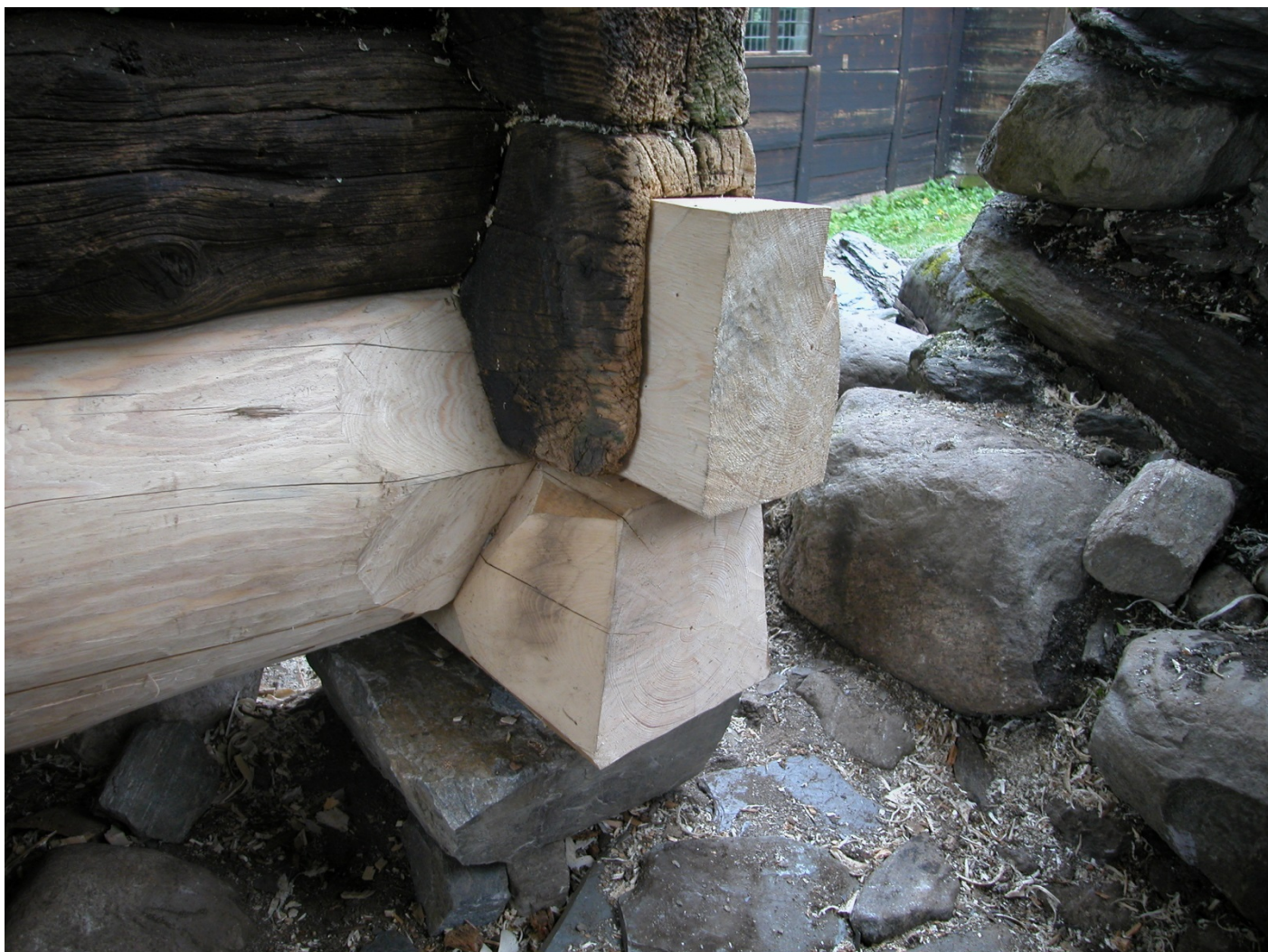
Ny stokk: Utbetring av botnsvillar i støpulen. Foto: Hans Marumsrud, Riksantikvarens arkiv.
