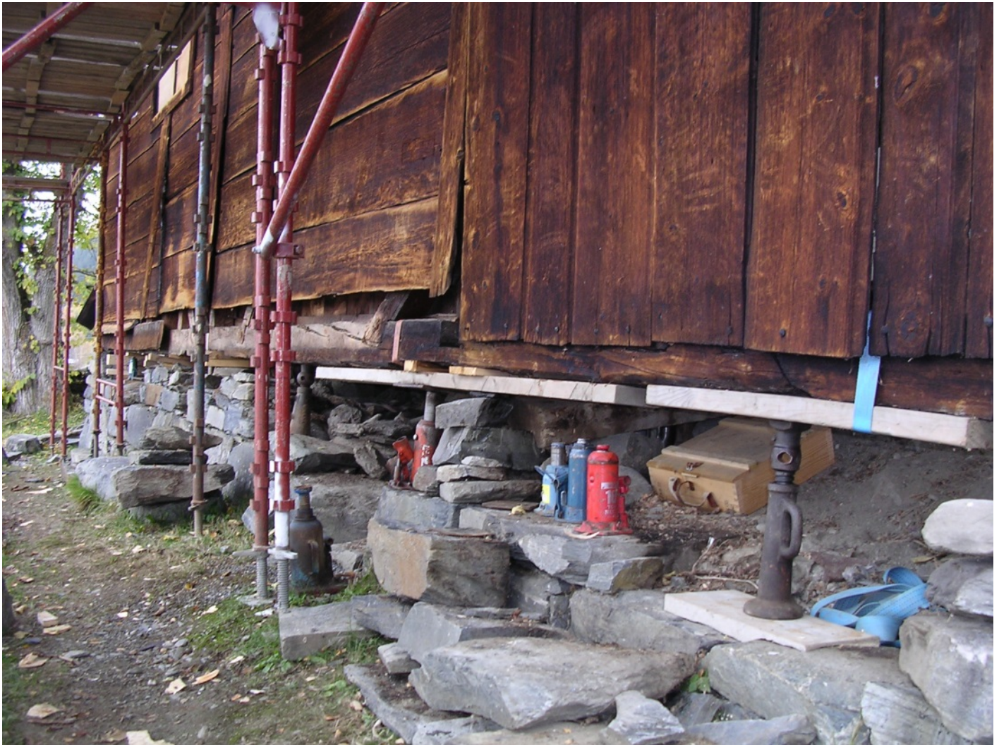
Jekking: Søndre langvegg vert lyft. Foto: Ellen M. Devold, Riksantikvarens arkiv.
