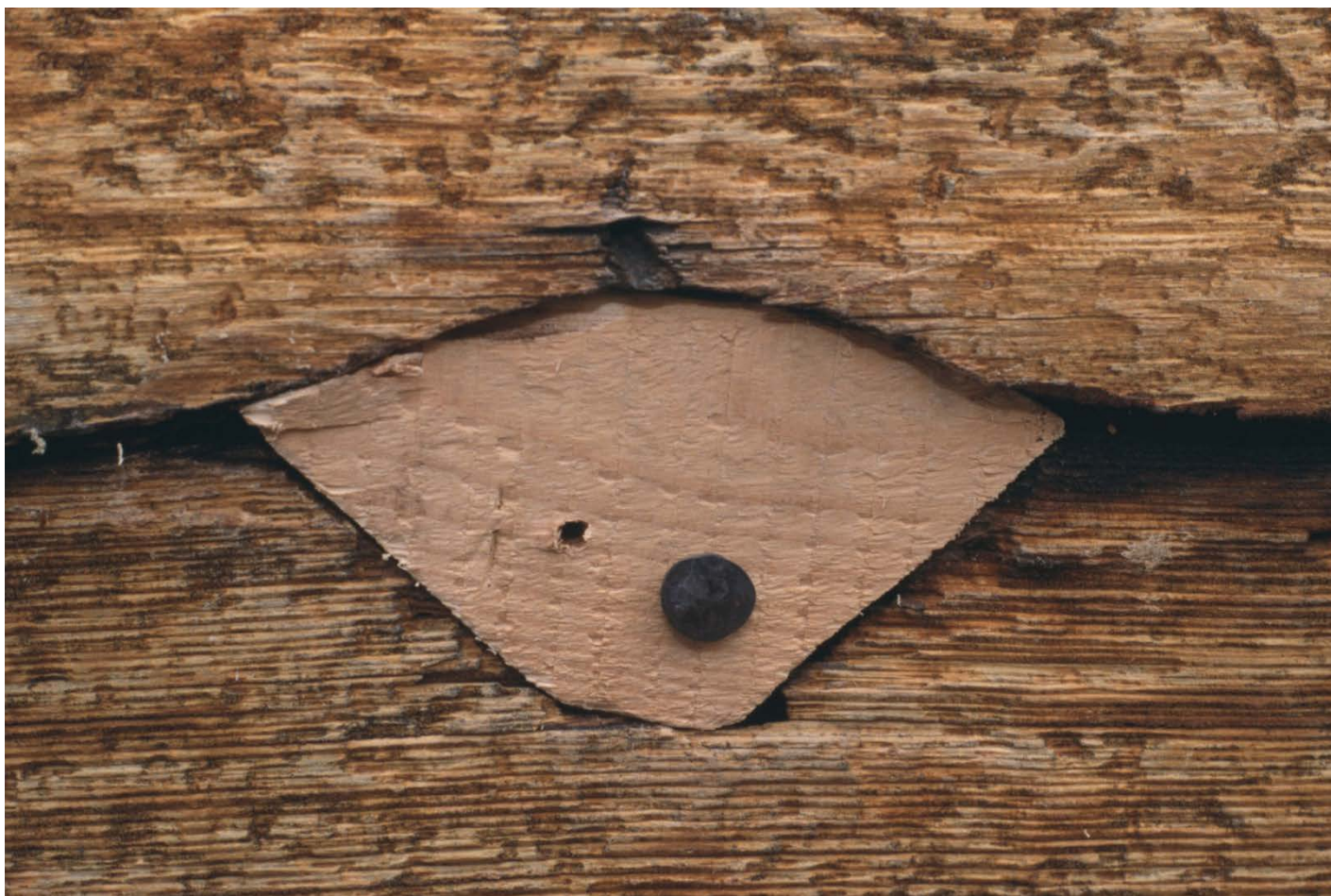
Hakkespetthol: Spunsing av hol etter hakkespett. Foto: Terje Tvenge, Riksantikvarens arkiv.
