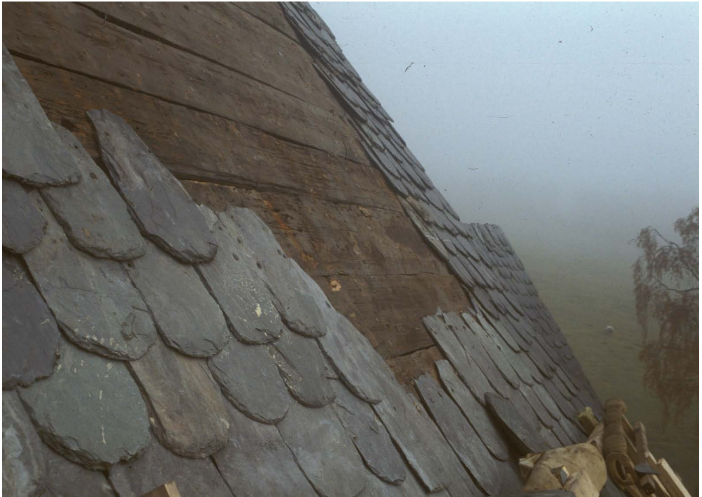
Skifertekking: Utbetring og montering av skifer. Foto: Hans Marumsrud, Riksantikvarens arkiv.
