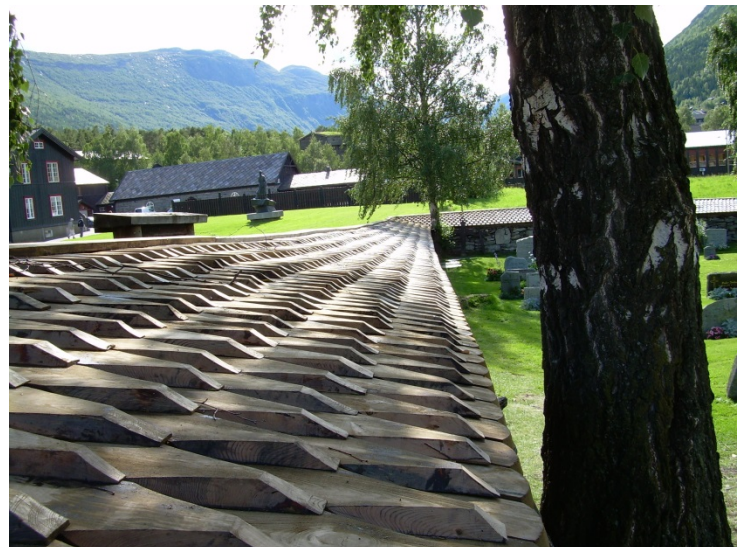
Taket: Kyrkjegardsmuren etter istandsetting. Foto: Are Flaten, Riksantikvarens arkiv.
