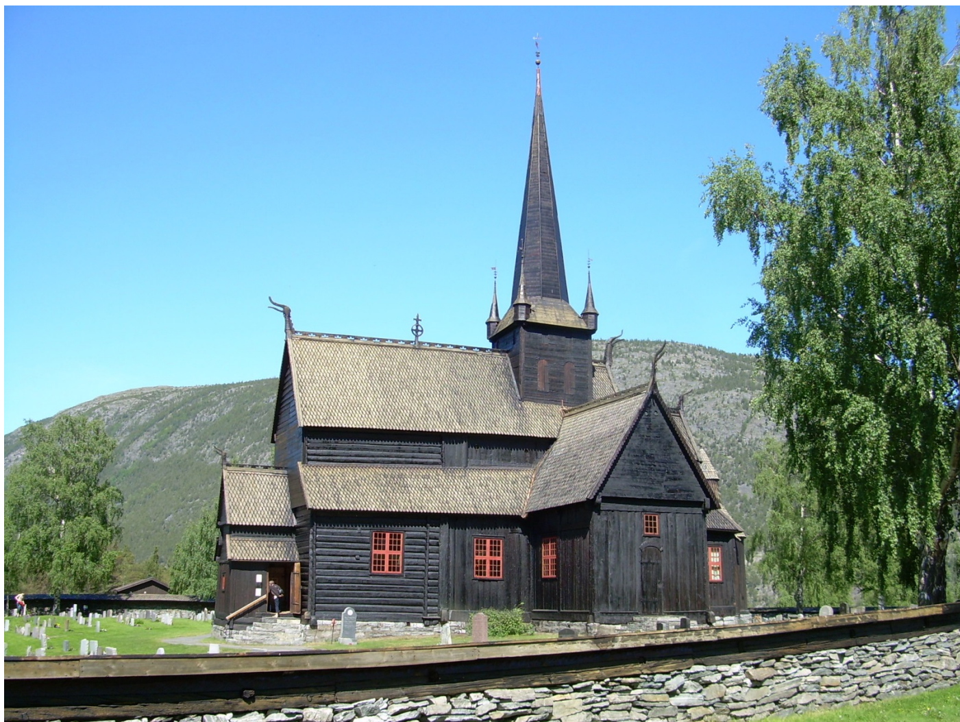
Stavkyrkjeprogrammet: Kyrkja etter tjærebreiving. Foto: Are Flaten, Riksantikvarens arkiv.
