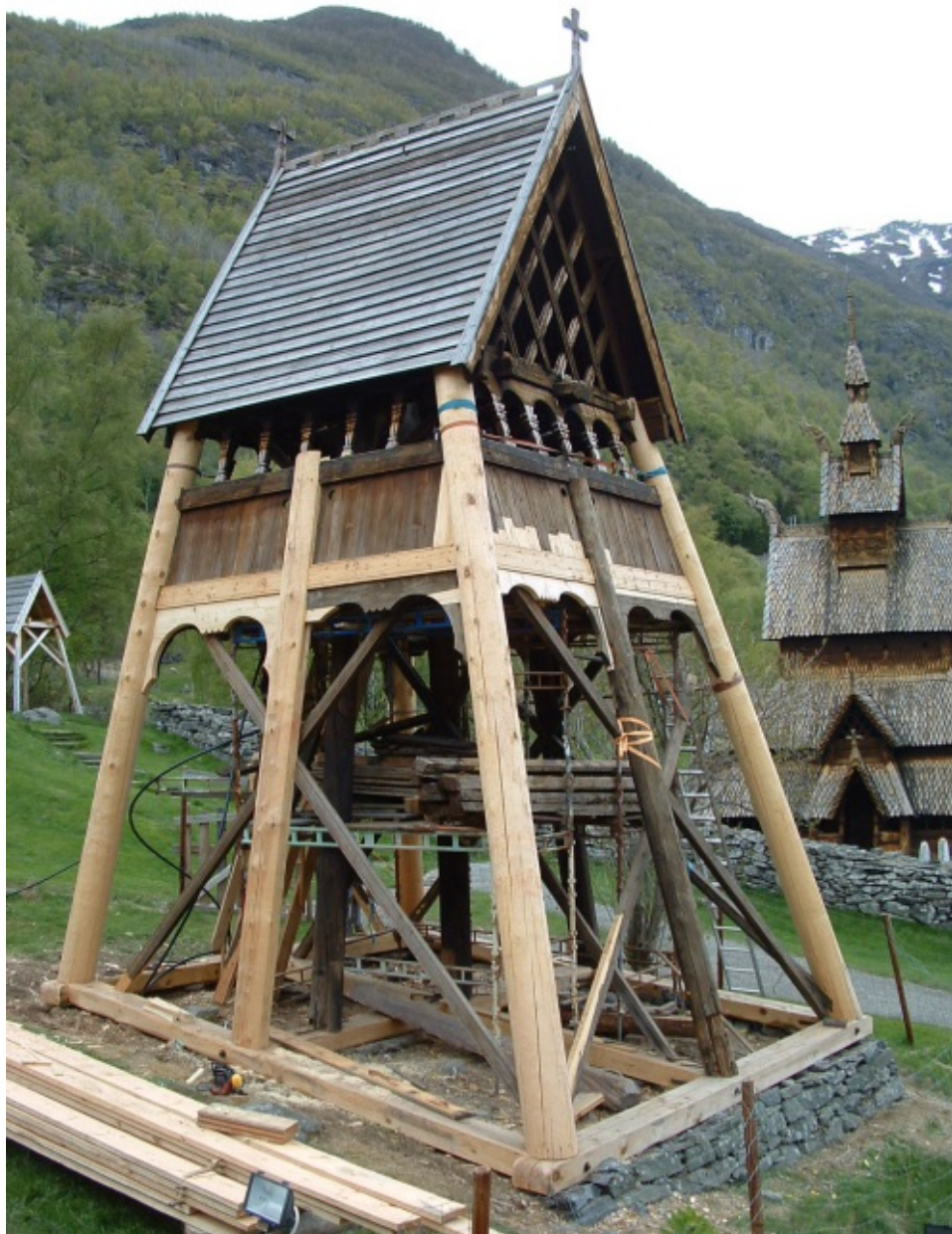
Støpulen: Før montering av ny kledning. Foto: Ellen Devold, Riksantikvarens arkiv.
