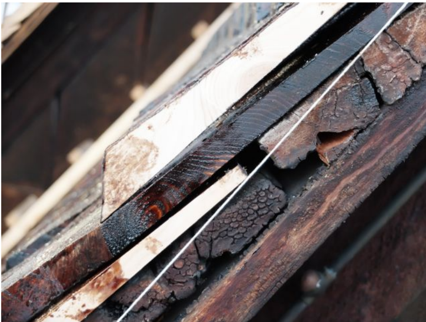
Spontekking : Ny spon over det gamle sulagde taket Foto: Bård Strømgren, Riksantikvarens arkiv.
