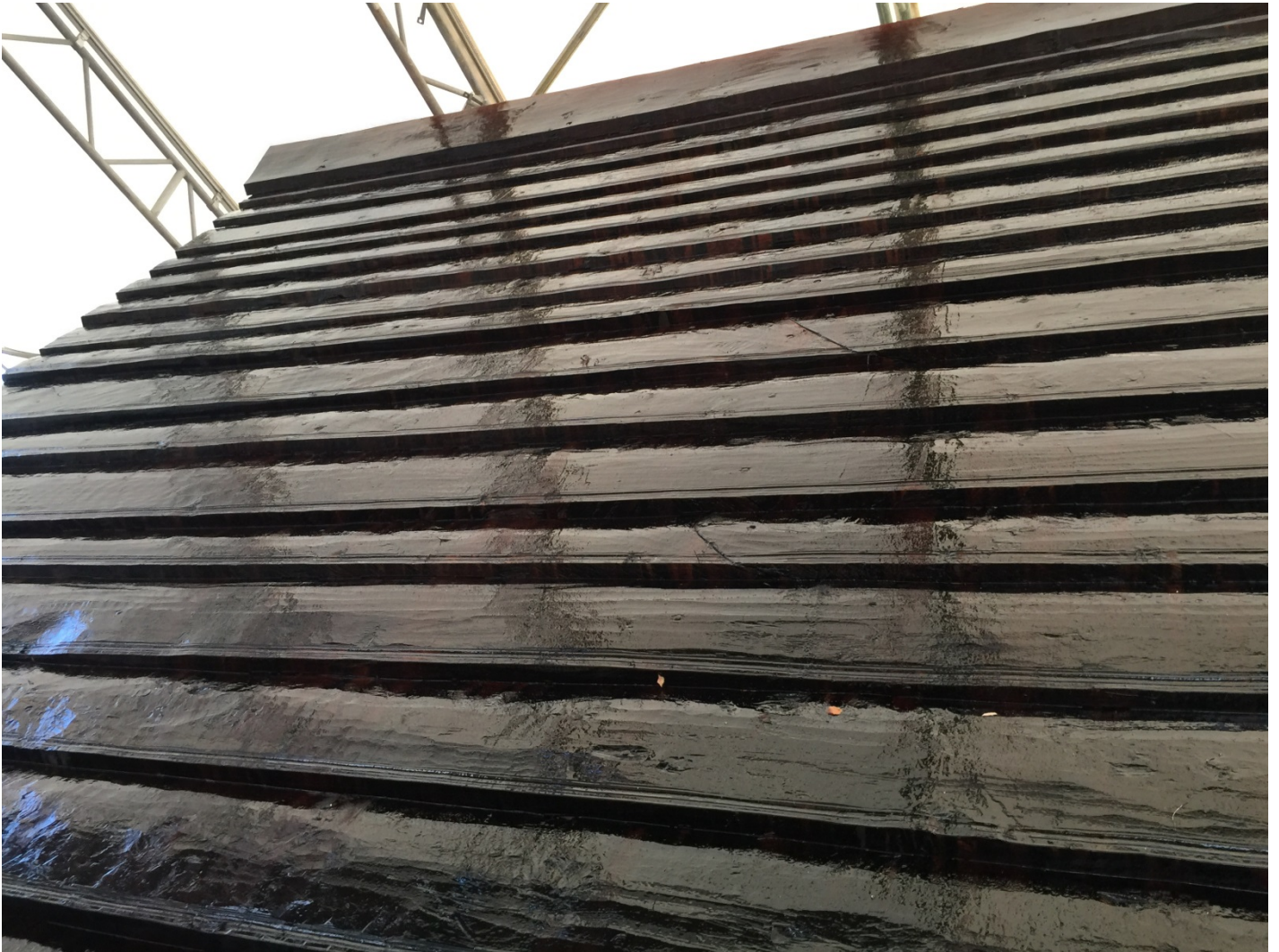
Tjærebreidd: Det nye sulagde taket på skipet. Foto: Bård Strømgren, Riksantikvarens arkiv.
