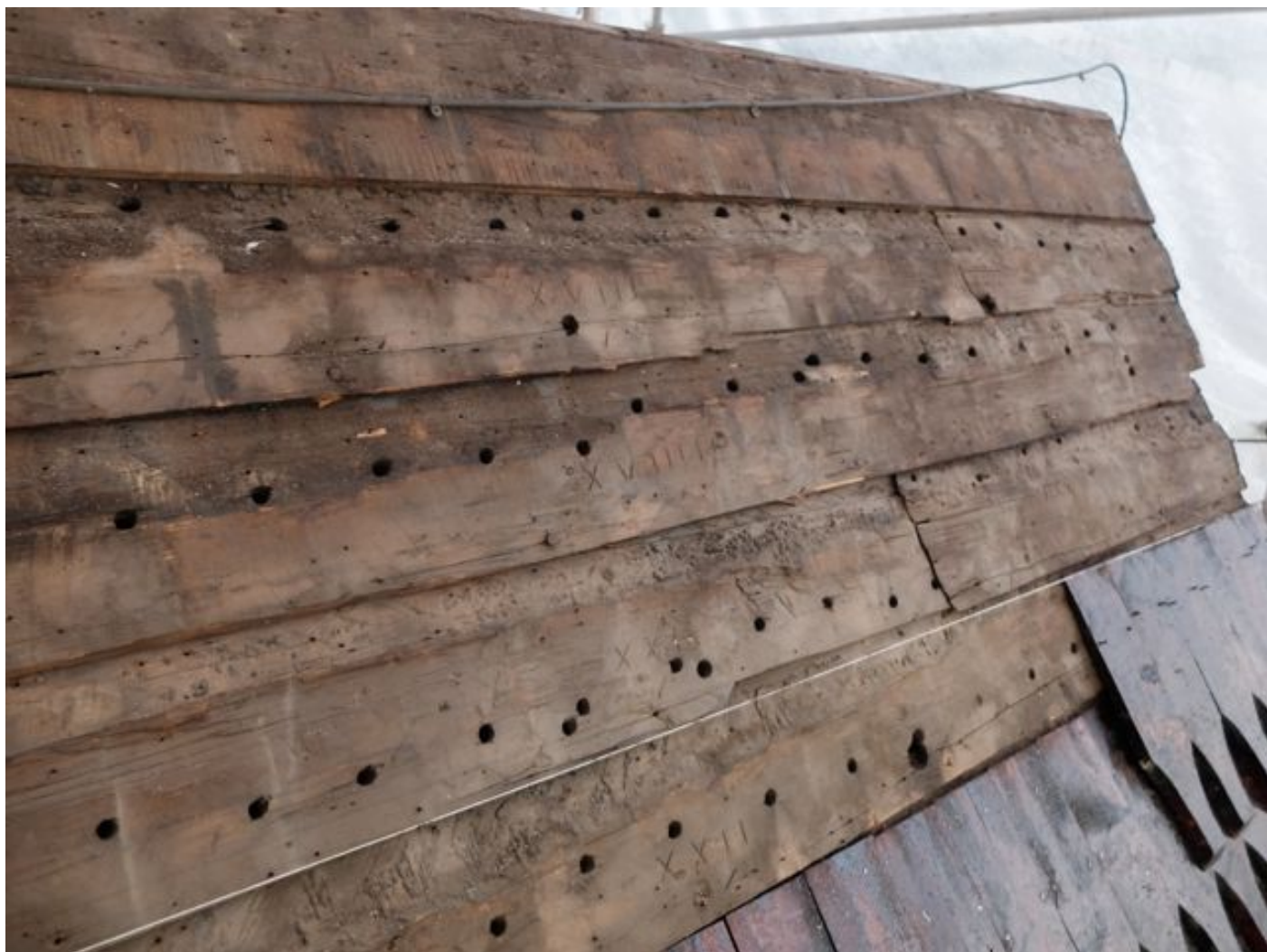
Sulagt tak: Det opphavlege sulagde taken under nyare spontekking. Foto: Bård Strømgren, Riksantikvarens arkiv.
