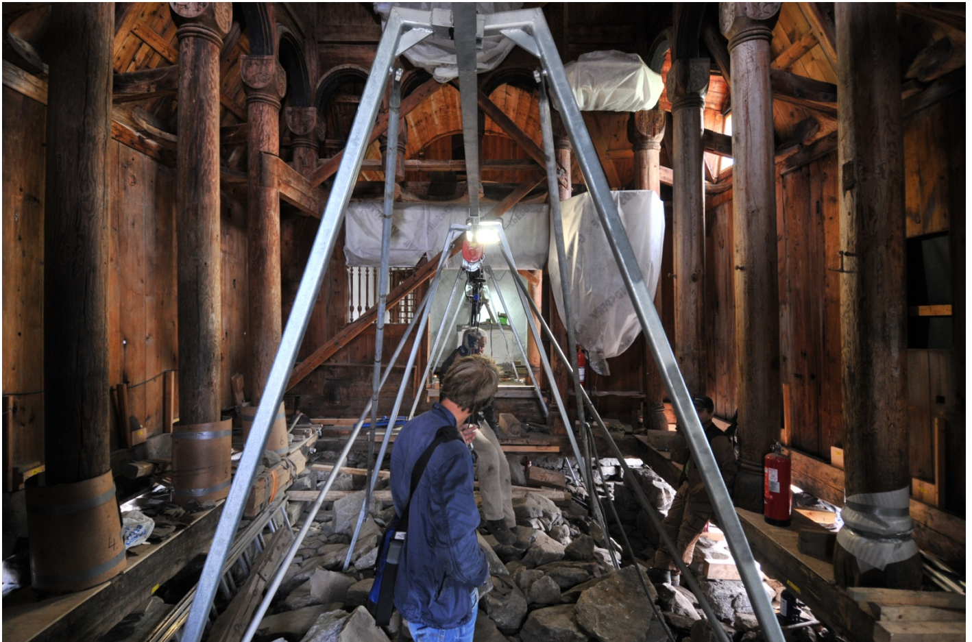
Stavkyrkjeprogrammet: Kyrkja slik ho stod under arbeidet med taket. Foto: Leif Anker, Riksantikvarens arkiv.
