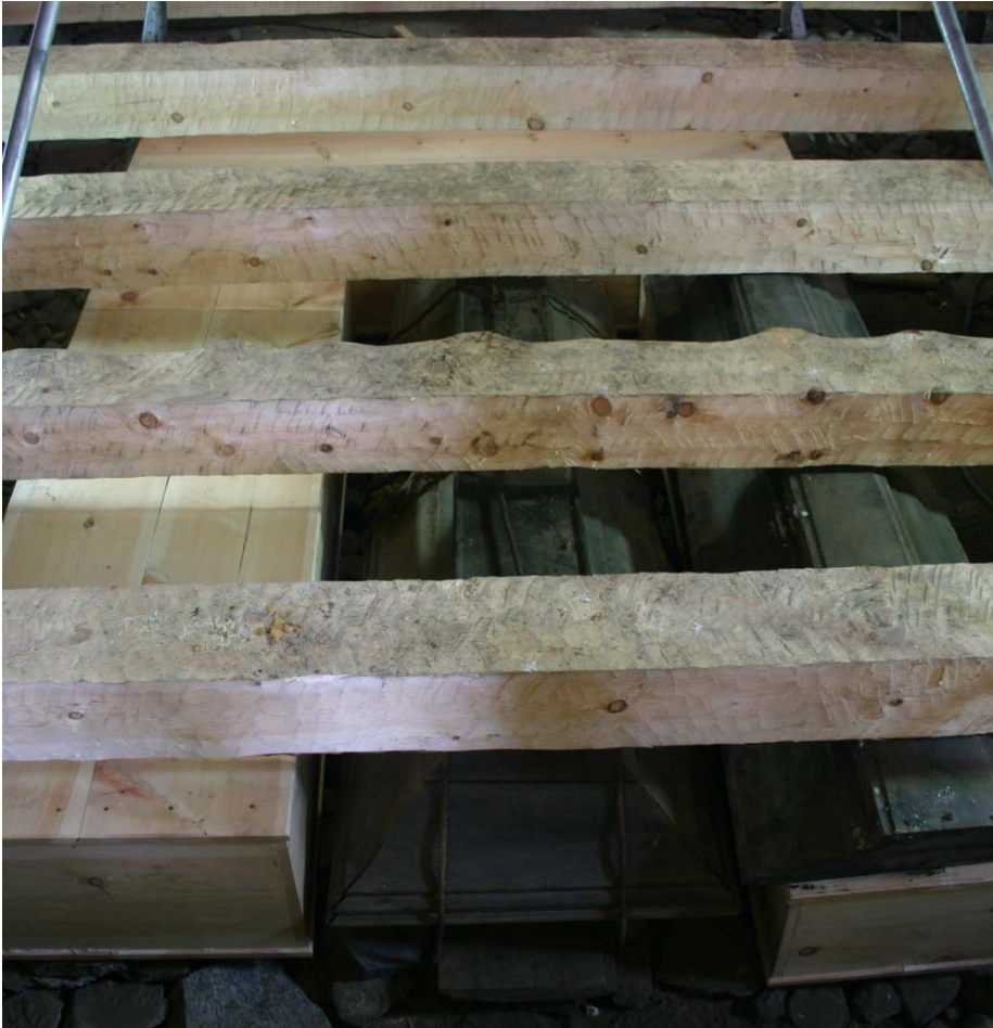
Før tilbakelegging av golv: Nye bjelkar mellom grunnstokkane og nye kister til nokre av kistebergravingane under golvet. Foto: Leif Anker, Riksantikvarens arkiv.
