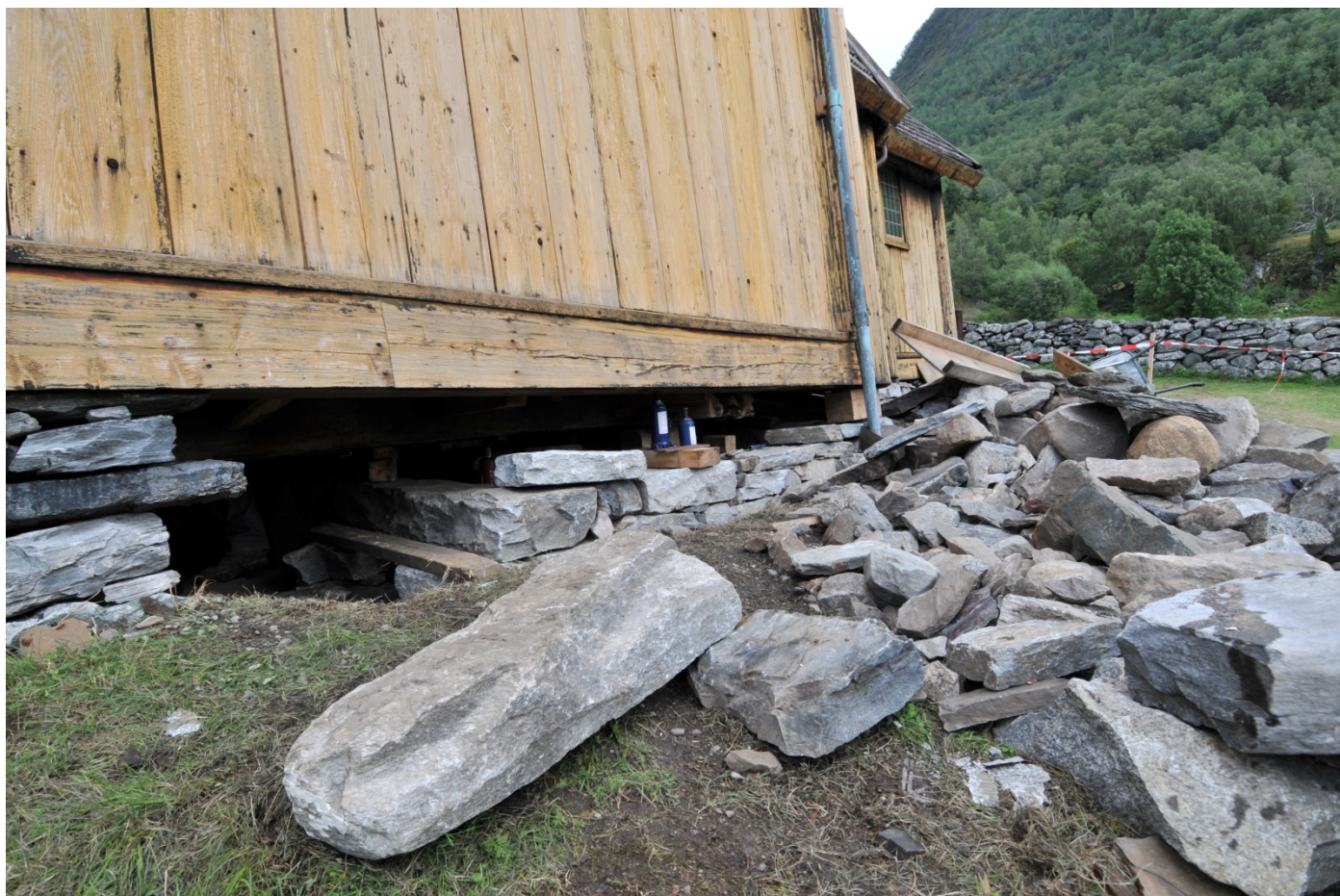
Ny grunnmur: Etablering av grunnmur med nye fundament og stabile murar. Foto: Leif Anker, Riksantikvarens arkiv.
