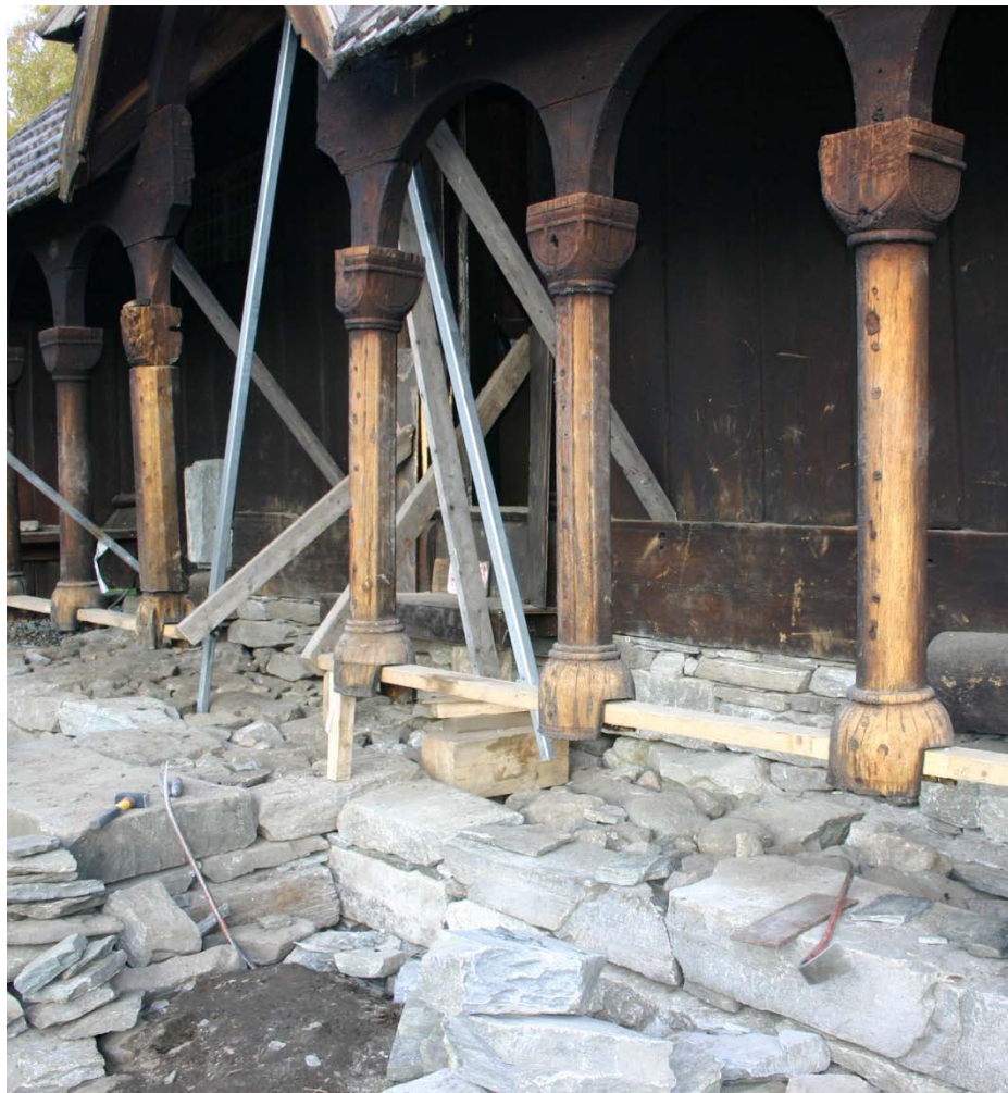
Svalgangen: Kyrkja slik ho stod under arbeidet med svalgangen. Foto: Leif Anker, Riksantikvarens arkiv.
