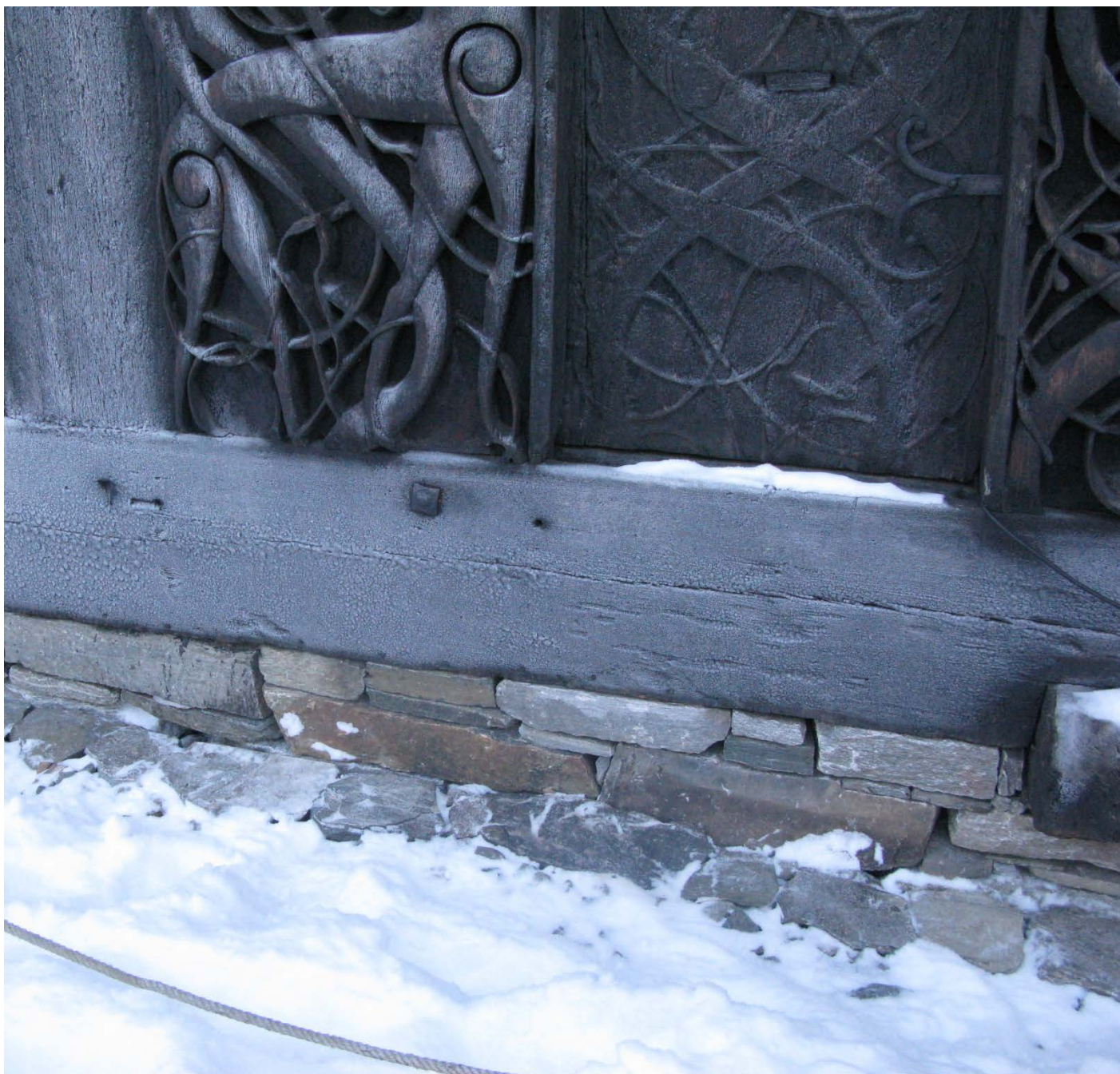
Svilla i nordveggen: Svilla vart korkje bytt eller spunsa, men fekk ny grunnmur under. Foto: Sjur Mehlum, Riksantikvarens arkiv.
