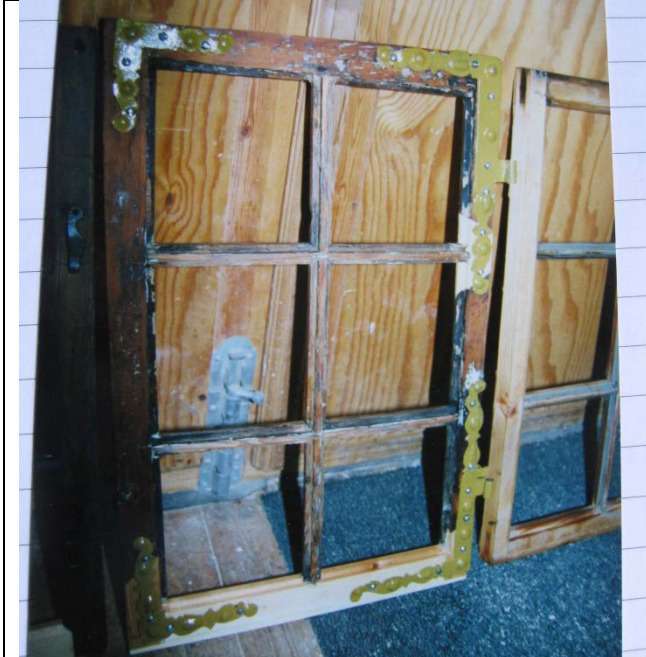
Vinduer fra vestfasadens 3.etasje under arbeid. All maling er fjernet.
