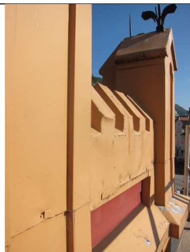
Øvre del av fasaden med metallbeslag
