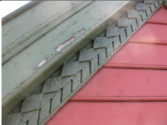
Detalj fra eldre dekor under takutspring
