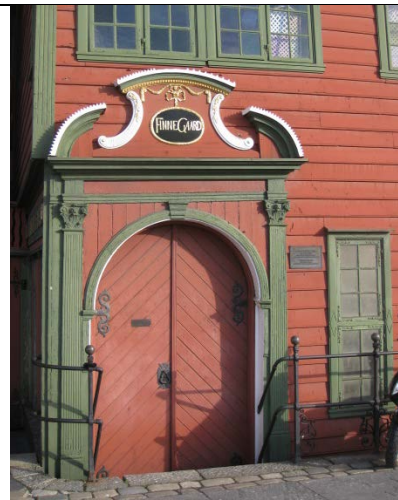
Norddør i vestfasade
