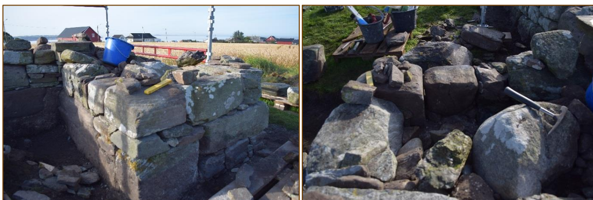
Figur 21 (a) og (b): Monteringsarbeid underveis på søndre del av vestveggen.
