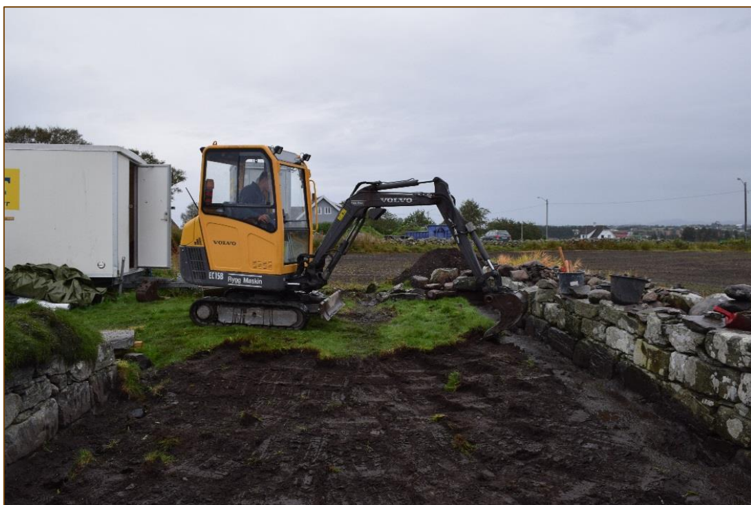
Figur 28: Fjerning av torvlaget i kirkerommet.
