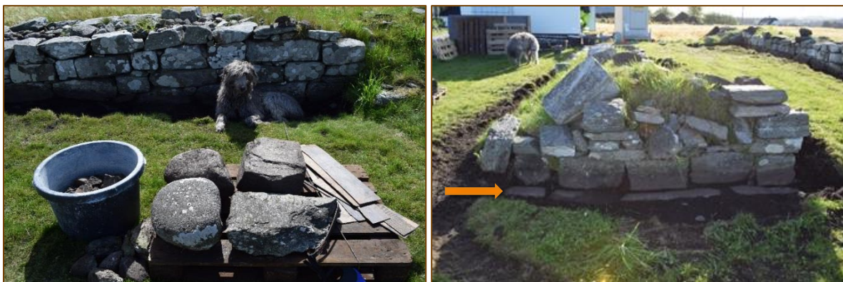
Figur 12(a): Hensiktsmessig lagring av løse steiner (b): Ytrevangen av vestvegg, torvlaget fjernet rundt murvanger. Pilen peker på steinheller, eller sokkel, som stikker ut forbi murlivet.
