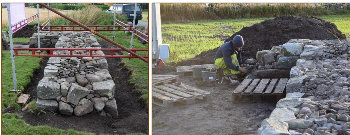
Figur 27(a): Avslutning av nordveggen (b): Arbeidet underveis ved avslutningen av østveggen.
