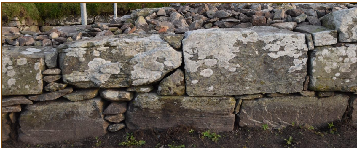
Figur 26: Stabilisering av sørveggen ved pinnesteiner. Kun pinnestein med naturlige overflater ble brukt.
