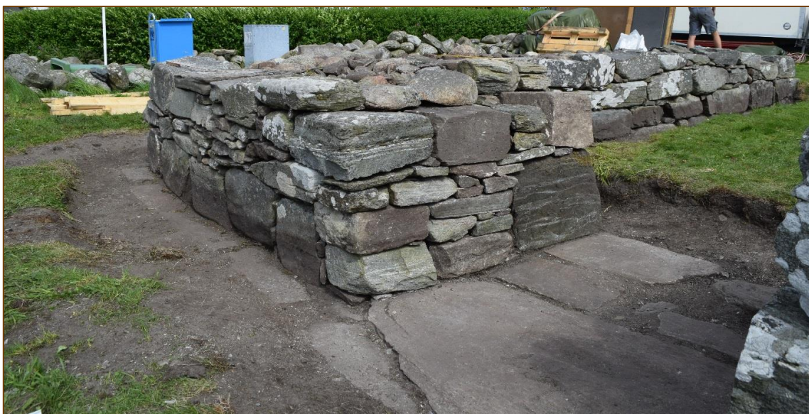
Figur 22: Vest- og nordveggene, ferdig tørrmurt. Legg merke til steinhellene i inngangspartiet og sokkelen langs vestfasaden.
