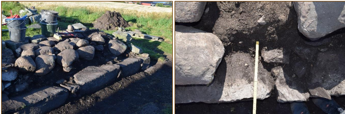
Figur 24: Ytre vangen av nordveggen (a): Murkjernen ble rensert for torv og jord, og øverste skift (steinene på «høykant») ble demontert (b) Avstanden mellom murlivet og opprinnelig kalkmurtkjernen passer kun til steiner murt tilbake på «høykant».
