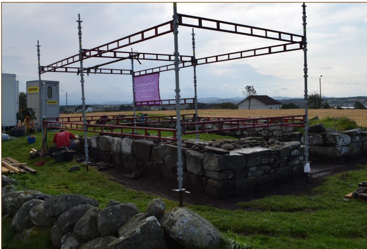
Figur 25: Ytre vangen av nordveggen. Øverste skift ble montert tilbake med steinene på «høykant».
