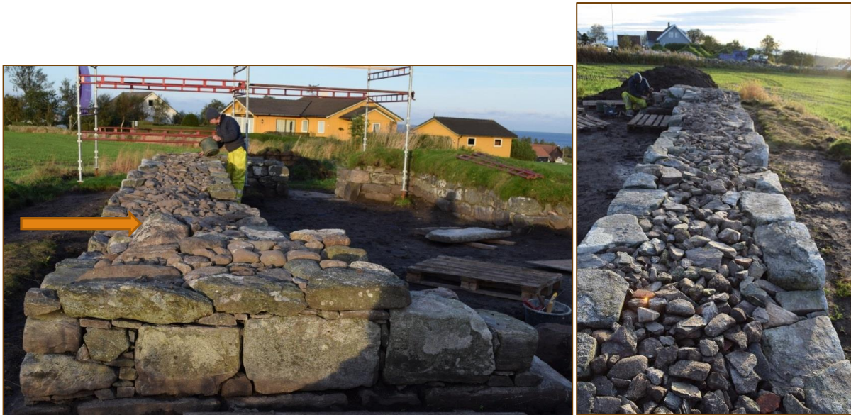
Figur 29(a) og (b): Legging av små steiner på toppdekke, pilen indikerer forhøyning av opprinnelig murkjernen i forhold til høyden på murvangene.
