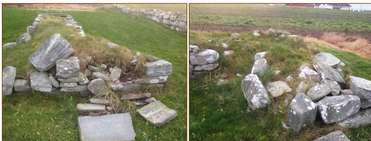
Figur 7(a): Ytrevangen av den nordvestre veggen, bilde ble tatt mot øst (b): Indre vange av sørvest hjørne, sett fra nord. Utraste steiner lå på bakken og murkjernen ble eksponert og uten støtte.
