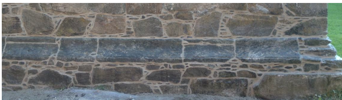
Sokkel på vestsiden av vestmur ferdig spekket og pinnet
