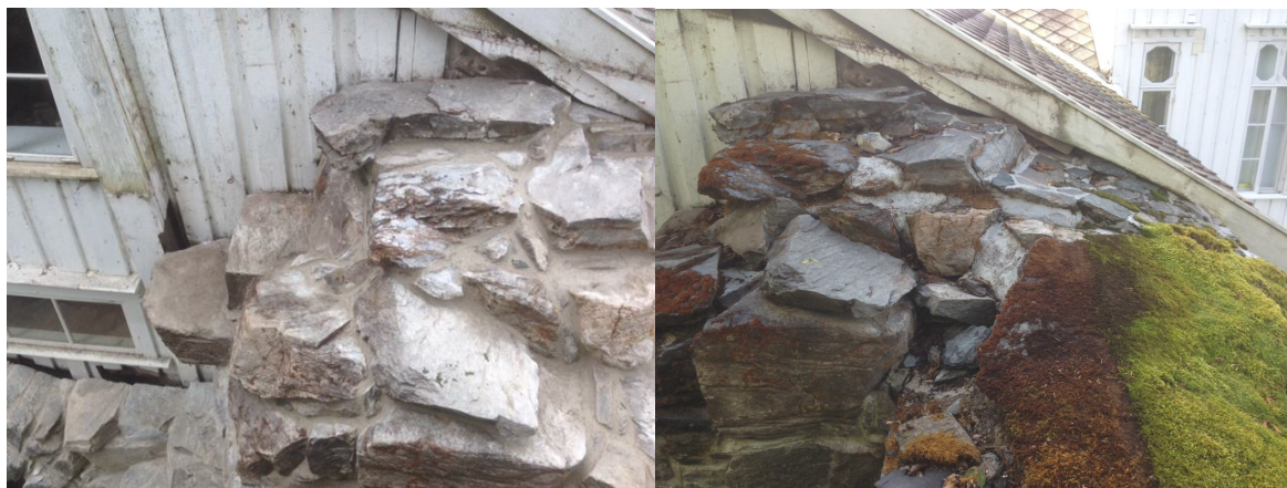
Bildet til høyre viser før inngrep. Bildet til venstre etter utført konservering
