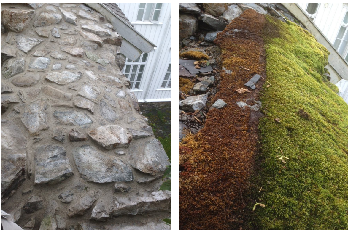
Bildet til høyre viser vestvegg i søndre tverrskip som lå under vernebygg frem til våren 2015. Bildet til venstre viser ny murt toppdekke etter at betong ble fjernet og murverket rensert for oppløst fugemateriale.
