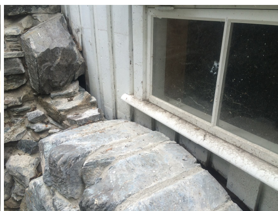
Bildet til venstre viser portalbuen og trebygning sett fra ned og opp. Tømmerstokk på bildet er også pusset etter anvisning fra arkitekt. Bildet til høyre viser toppen av buesteinene. Det vil bli påmontert et ekstra vannbord som dekker åpning mellom trebygning og buesteiner etter at tiltaket er godkjent av fylkesantikvar.
