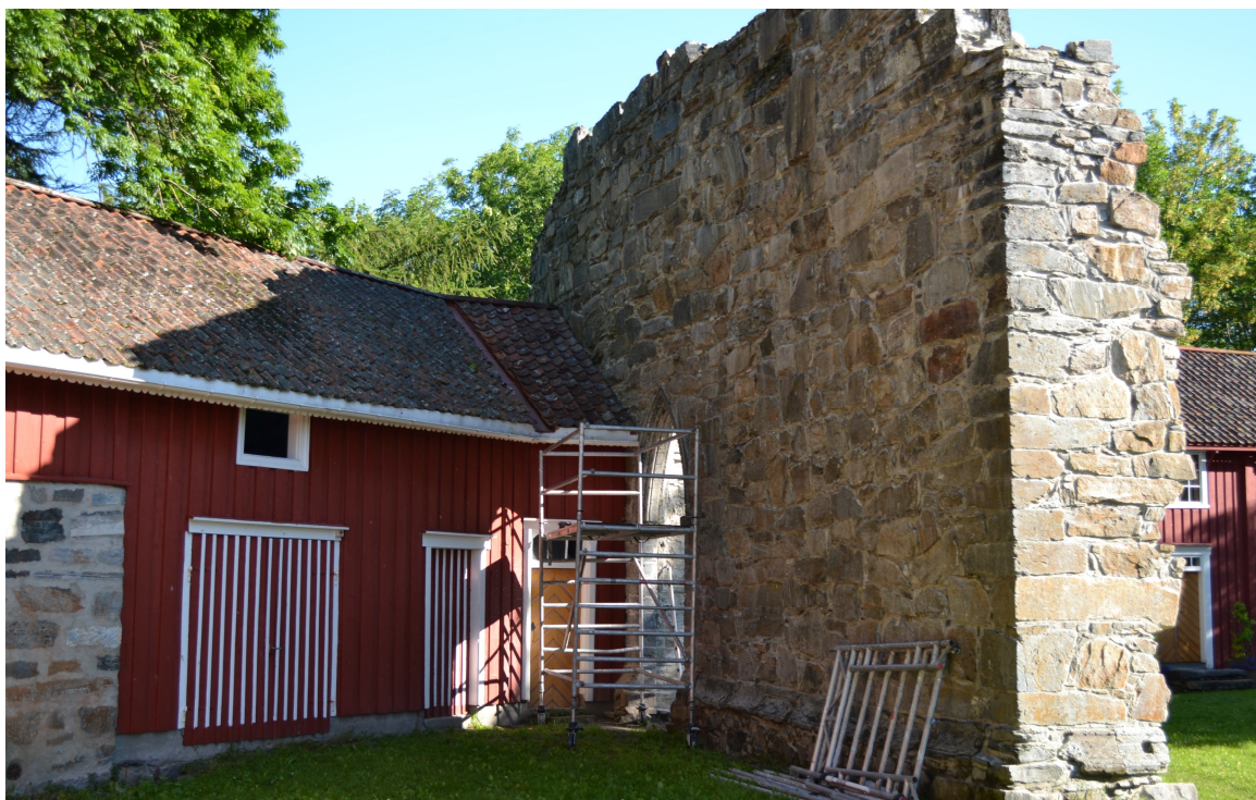
Takstein på østre del av meieribygget lagt tilbake. Takstein ble fjernet i forbindelse med bygging av stillaser til konserveringsarbeidet
