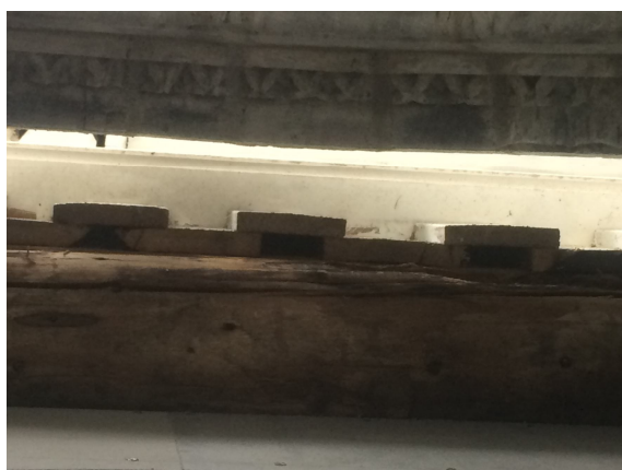
Bildet til venstre viser portalbuen og trebygning sett fra ned og opp. Tømmerstokk på bildet er også pusset etter anvisning fra arkitekt. Bildet til høyre viser toppen av buesteinene. Det vil bli påmontert et ekstra vannbord som dekker åpning mellom trebygning og buesteiner etter at tiltaket er godkjent av fylkesantikvar.
