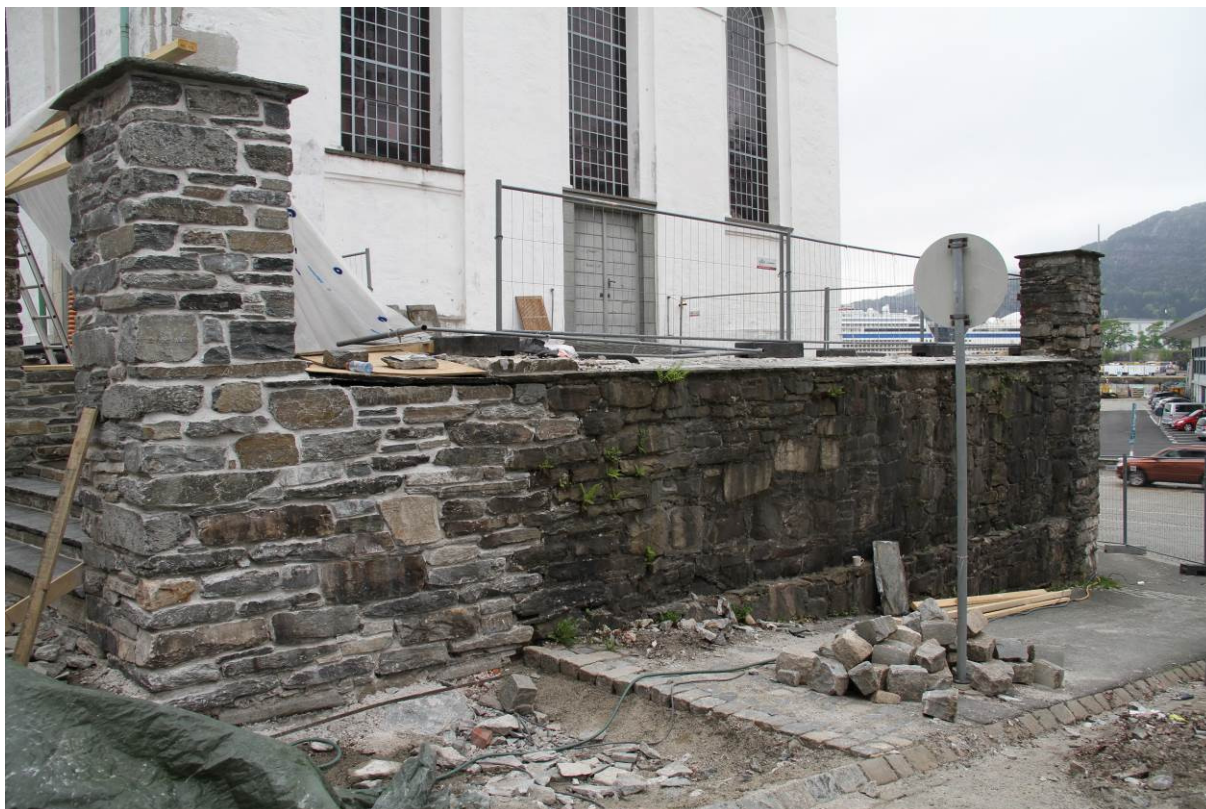
Fig. 13. Gjenetablering av trapp og pilarer (foto: Byantikvaren 2013).
