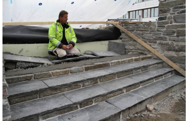
Fig. 11. Ved gjenetableringen av trappen ble trinnene murt med skiferstein, slik som de øvrige trappene omkring Nykirken (foto: Byantikvaren 2013).
