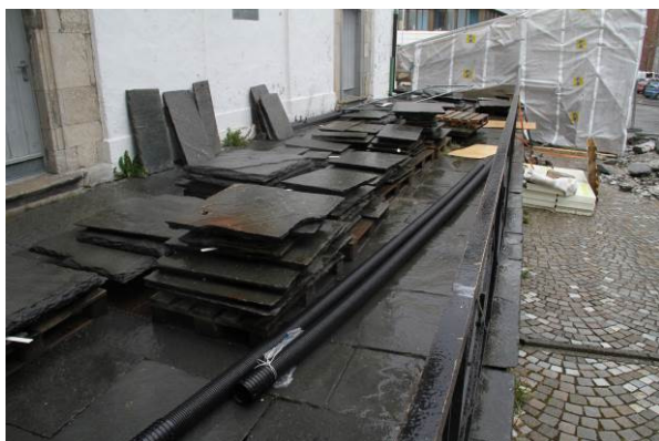
Fig. 8. Heller og gravplater ble demontert fra terrassedekket, merket og lagret under tiltakene (foto: Byantikvaren 2013).
