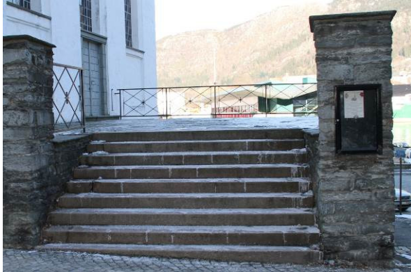
Fig. 10. Før tiltaket. Trappen med granitt-trinn før den ble demontert (foto: Byantikvaren 2010).
