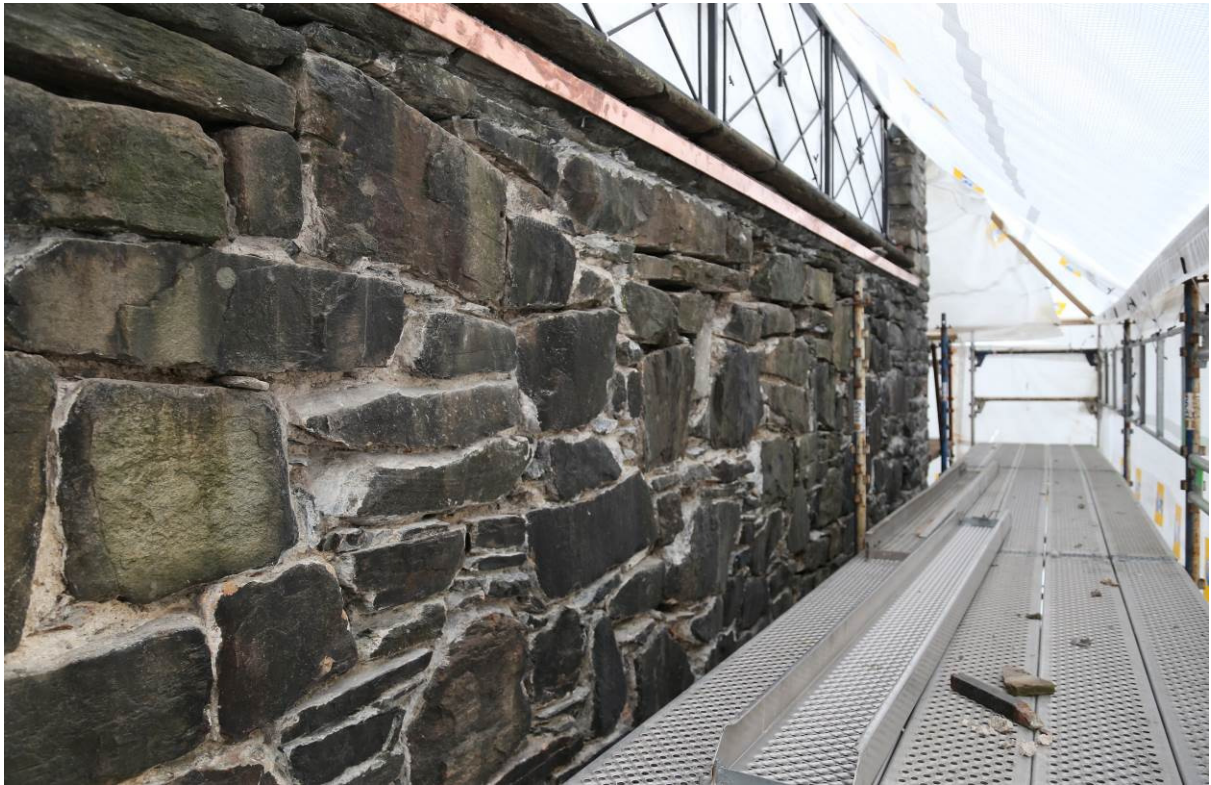
Fig. 20. Murlivet står til tørking etter utkrassing av murfugene (Foto: Byantikvaren 2013).
