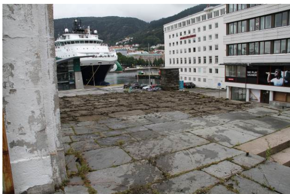
Fig. 14. Terrassedekket ble demontert (foto: Byantikvaren 2013).
