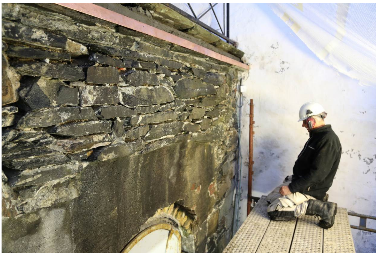
Fig. 25. Murer Arvid Grindheim fra Akasia arbeider med å krasse ut fugene ved døråpningen i det østre murlivet i terrassen (foto: Byantikvaren 2013).
