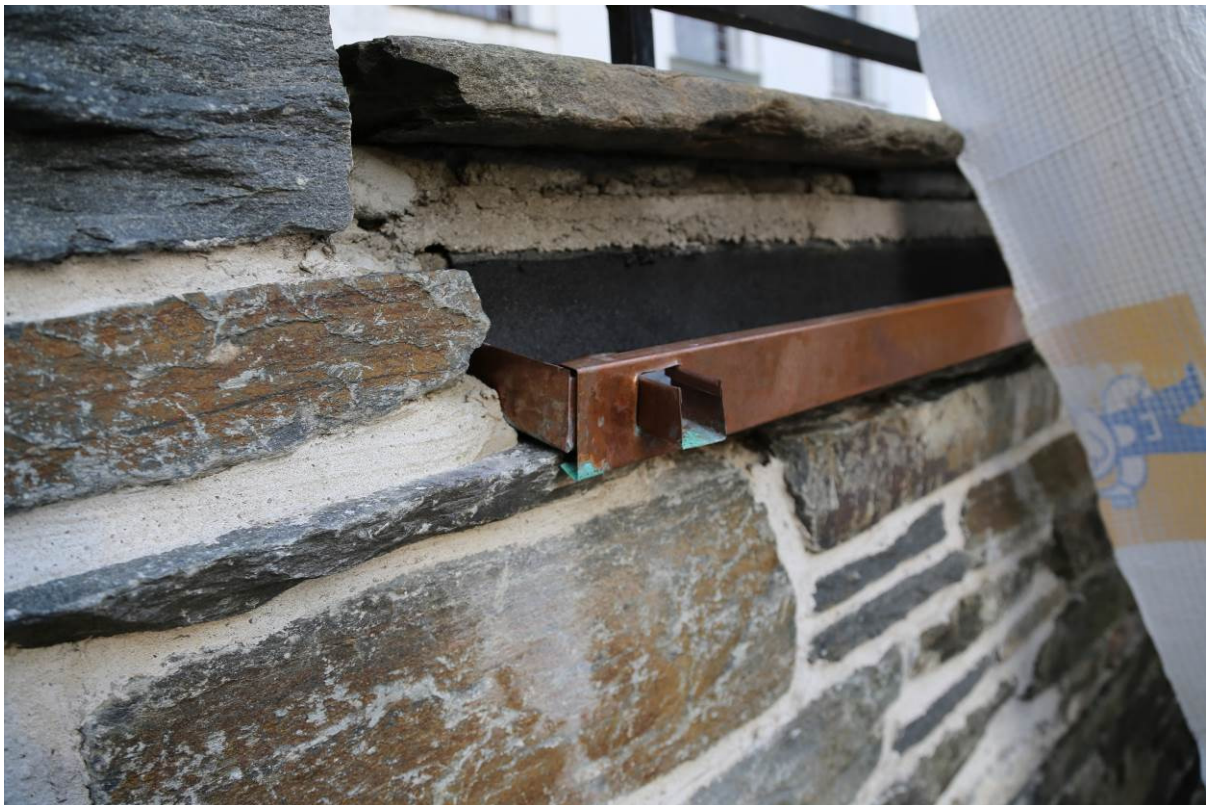
Fig. 21. Det ble montert en kobberrenne med dryppnese langs kanten av terrassekanten, over murlivet (foto: Byantikvaren 2013).
