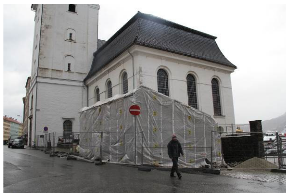
Fig. 9. Det ble oppført et midlertidig vernebygg over trappen under arbeidene (Foto: Byantikvaren 2013).
