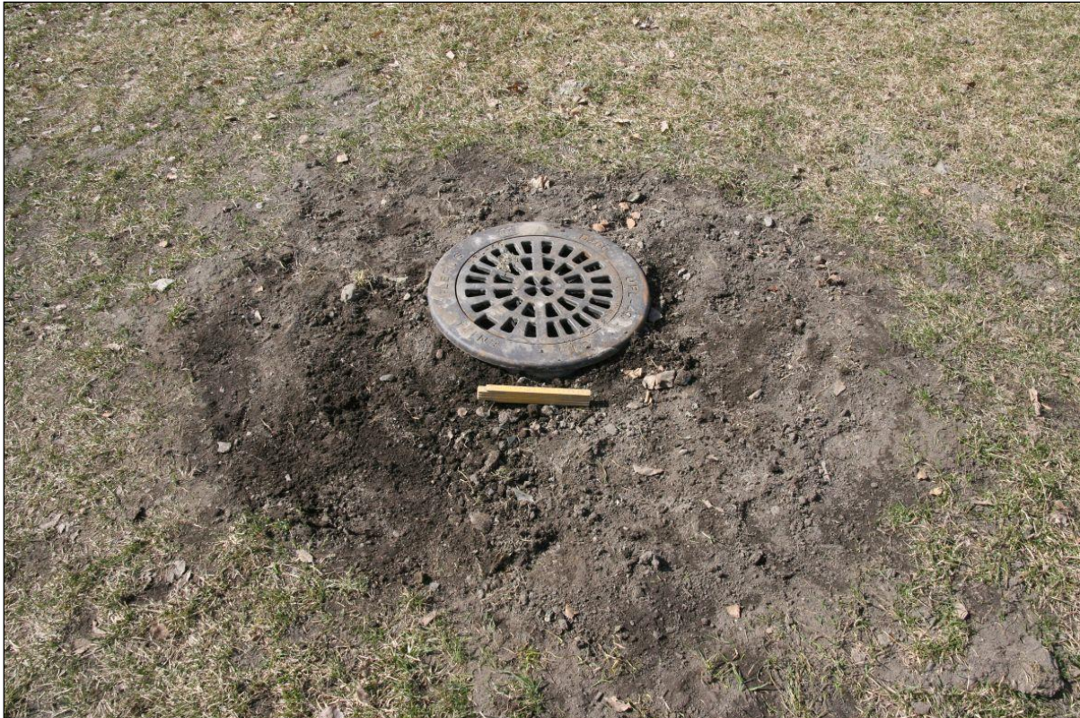
Figur 17: Omfanget av graving med gravemaskin (Foto: niku_ark_307761).
