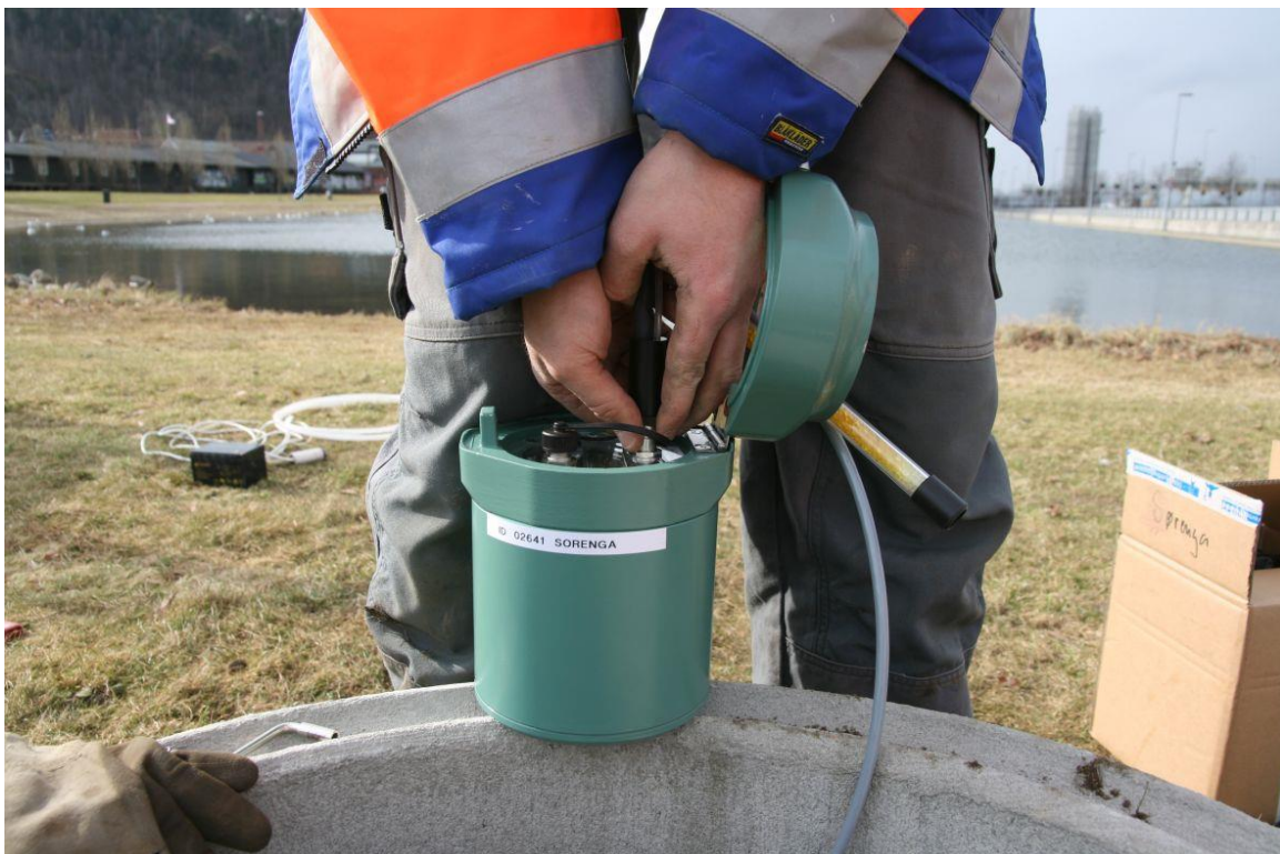
Figur 5: Logger fra peleprosjektet, Sørenga. Loggeutstyr sett fra siden. (Foto: niku_ark_307754).
