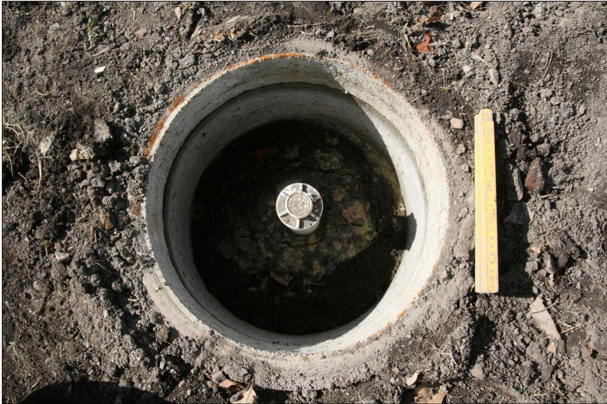
Figur 11: Kummer bestående av sementringer.
