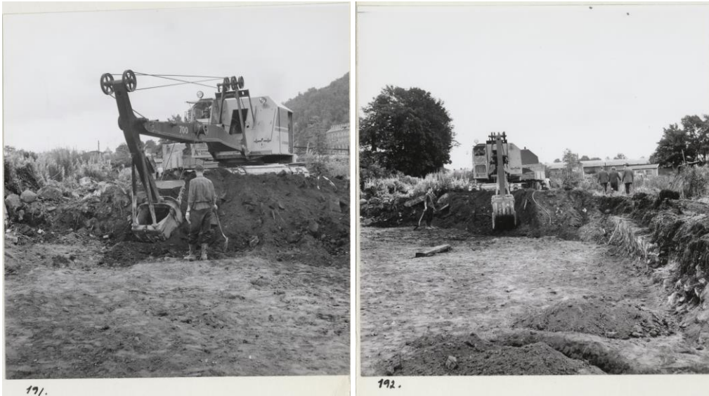
Figur 25 Maskinell graving på kirkegården med arkeologisk overvåkning.
