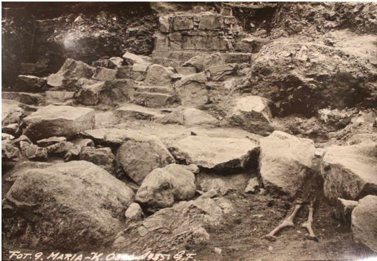
Figur 10 Foto mot øst, av kirkegårdsmuren med skjelettrestrester i forkant. Bak sees fundamentet for sørvestre hjørnepillar (Foto 9_Mariak._Oslo.1935.G.F.\Riksantikvarens arkiv).
