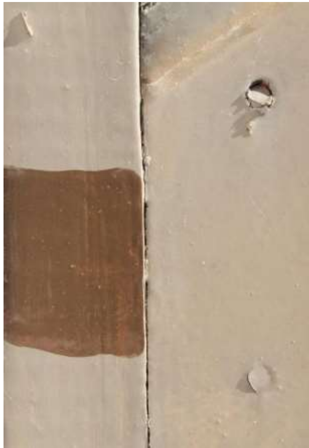
Figur 9. Ole Guldalsgate 10. Nåværende malinglag på døra er regenerert, og klar til å kodes. Pigmentene er kraftig bleket. Foto: Jon Brønne. 2015.
