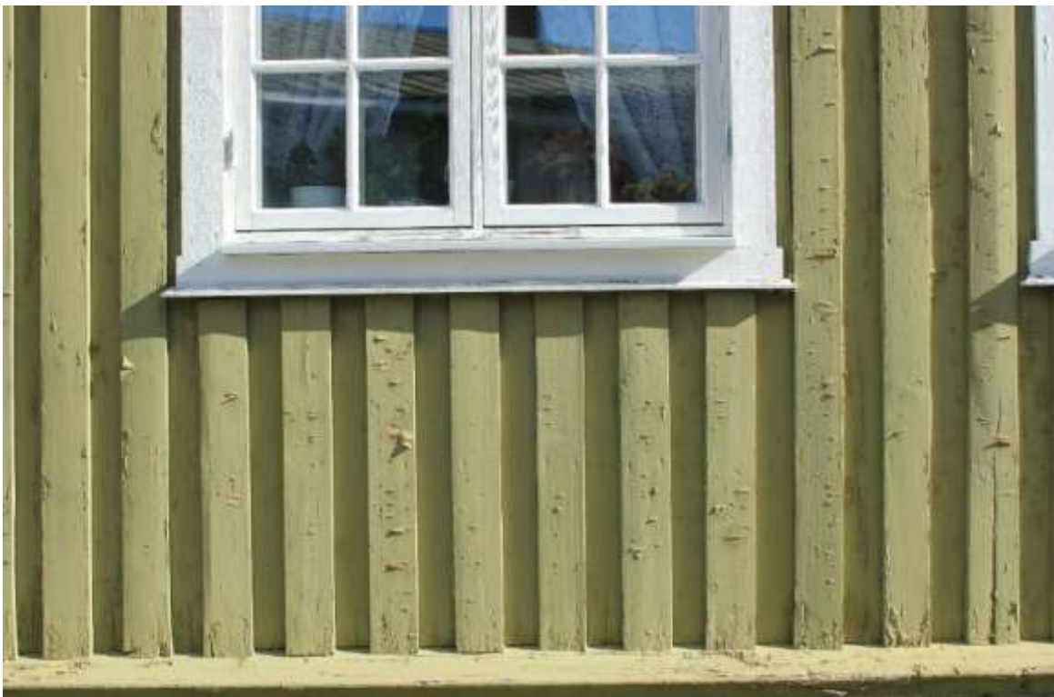
Figur 6. Ole Guldalsgate 10. Panelet, detalj av nedre del. Foto: Jon Brønne. 2015.
