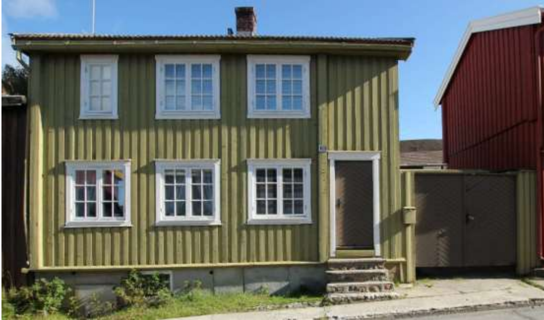
Figur 3. Ole Guldalsgate 10. Hovedfasaden sett fra syd. Foto: J. Brønne 2014.
