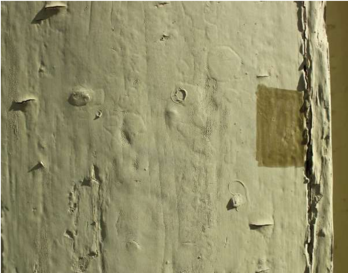
Figur 11. Ole Guldalsgate 10. Nåværende malinglag på panelet er regenerert, og klar til å kodes. Foto: Jon Brønne. 2015.
