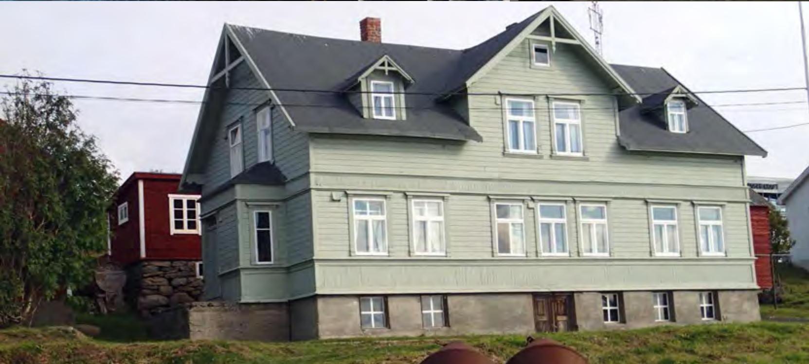
Bietilægården ligger i Indrebyen i Vadsø, tidligere kalt Indre kvenby. Gården ble bygd av kvenske innvandrere og består av bolighus, tre fjøs, kaianlegg med nothjell og slipp for båtopptrekk. Bietilægården er et viktig kulturminne som viser kvenske tradisjoner fra kystkultur og jordbruk. Den ble fredet i 1990. Foto: Siri Wolland, Riksantikvaren
