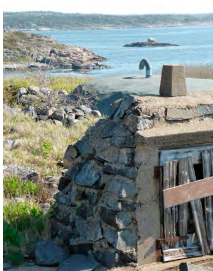
Oddane fort i Vestfold regnes som et av de best bevarte tyskbygde kystfort i Norge. Fortet ble fredet i 2015. Foto: May Britt Håbjørg, Riksantikvaren
