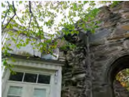
Hovudbygningen på garden på Reins kloster er bygd saman med ruinen etter klosterkyrkja. Den gamle klosterkjellaren ligg under dagens hovudbygning, som består av to delar.
