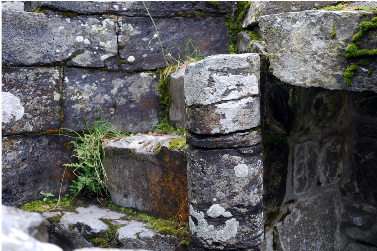
Figur 65: Skifrig kleberstein i vindeltrappen i korpartiet.
