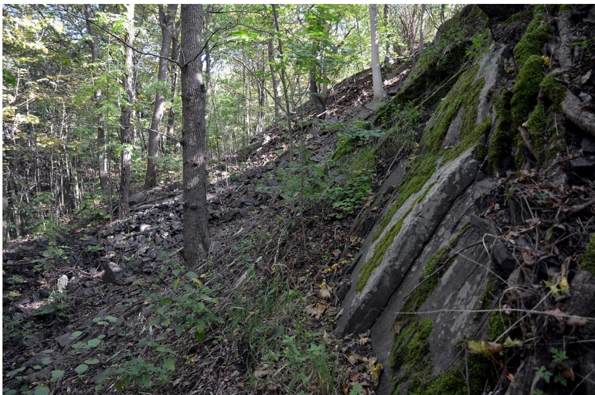
Figur 56: Detalj av sandsteinsbrudd 26. Her er det kilt og boret og brukket løs heller, sannsynligvis for bruk til 1800-tallets militære bygninger. Skrottpipen i bakkant kommer delvis fra rivning/ødeleggelser relatert til østre oppsynsmannsbolig rett ovenfor.
