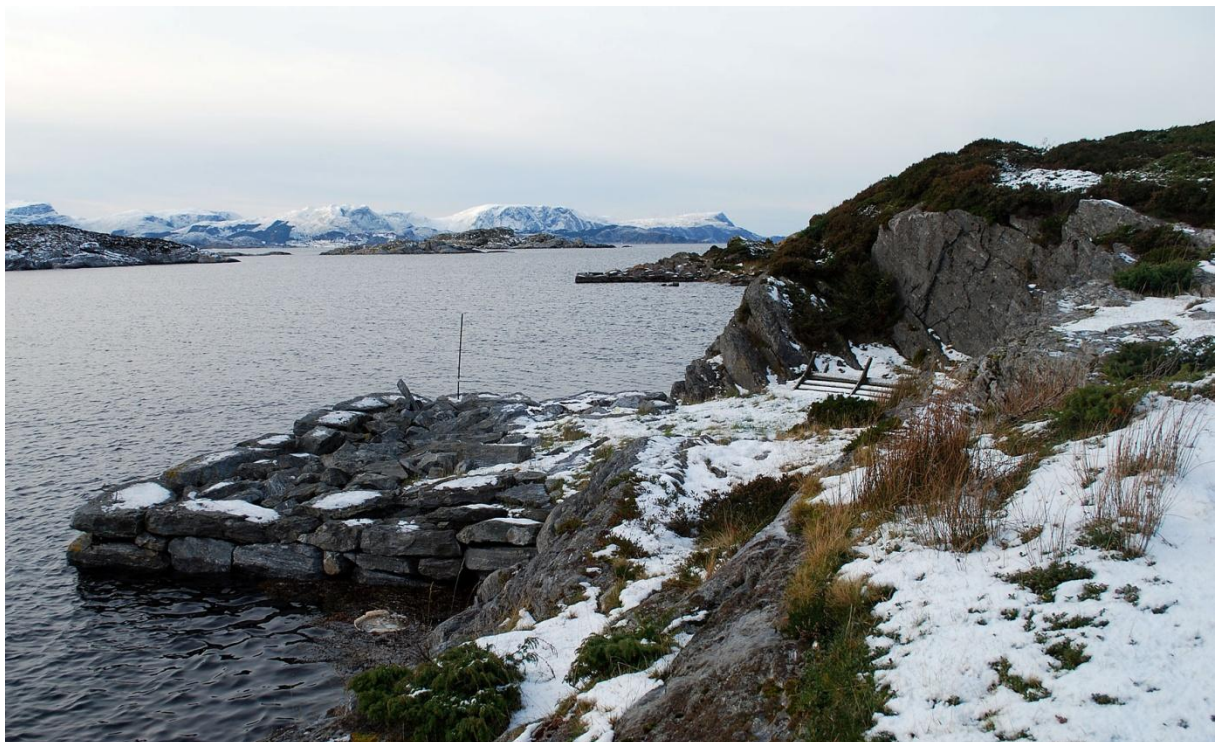
Figur 25: Moderne sprengningsbrudd i bakkant av en brygge i Klostervågen.
