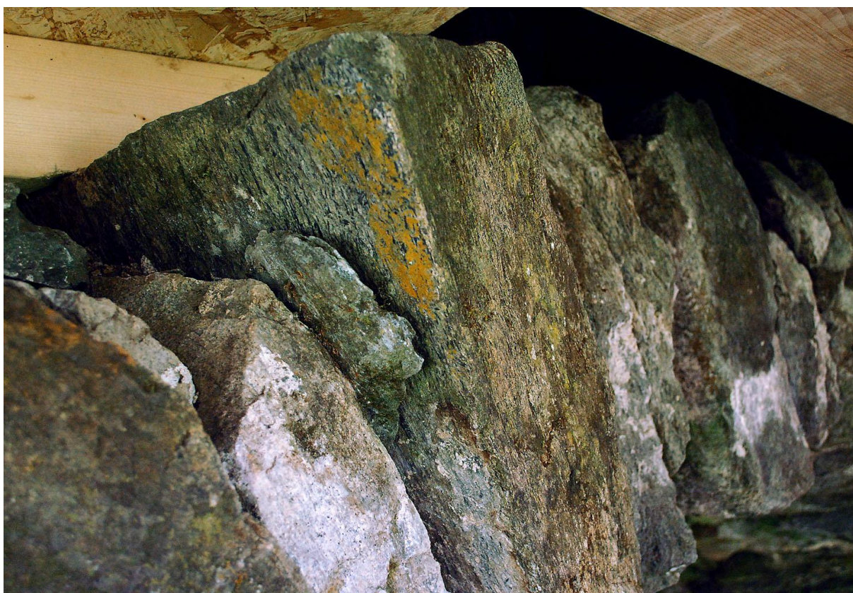
Figur 64: Kantstilte "heller" i tønnehvelvet i rommet mellom østre og søndre korsarm. Merk de utpregede amfibolnålene i den mest fremstående steinen.
