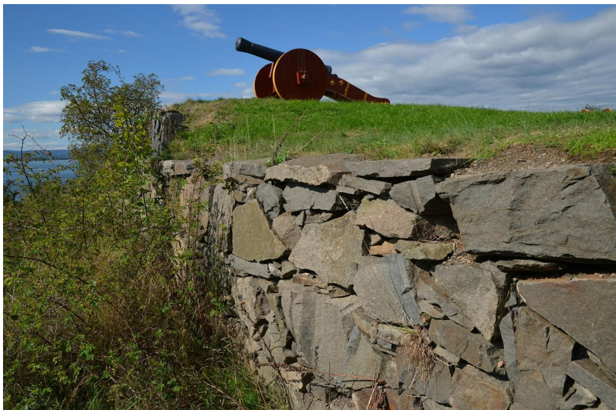
Figur 41: Muren omkring vestre kanonbatteri (bastion).
