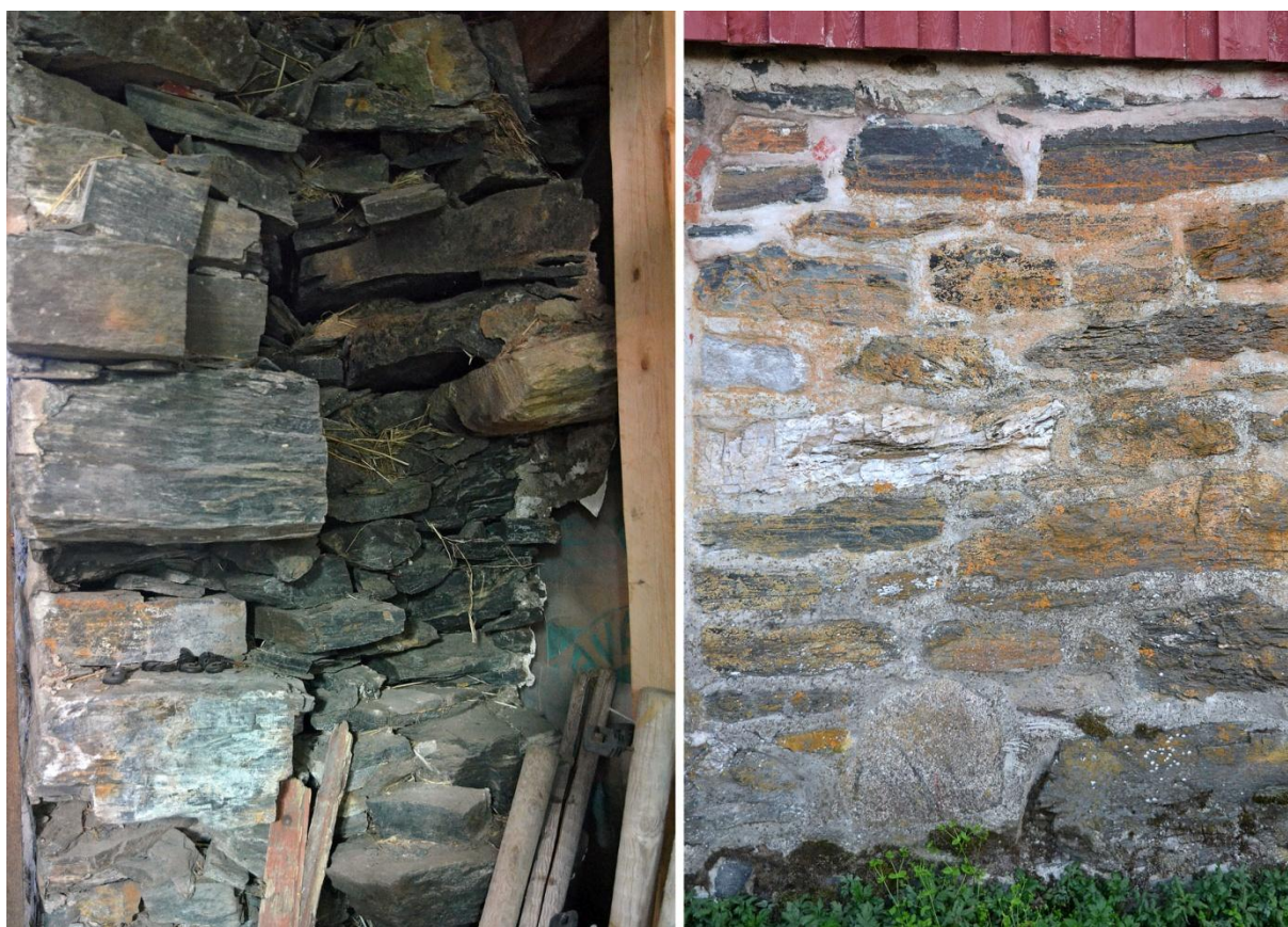
Figur 66: Grunnmurene i driftsbygningen på Rein fra andre halvdel av 1800-tallet er i stor grad bygget med amfibolittisk gneis av en type man finner i nærområdene på Reinshaugen
