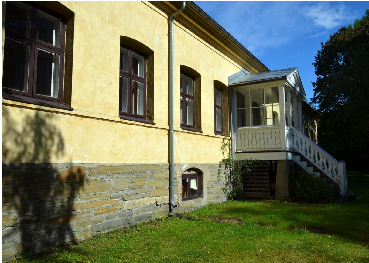
Figur 42: Sørsiden av Kommandantboligen med grunnmur oppført med murestein av stort sett sandstein.
