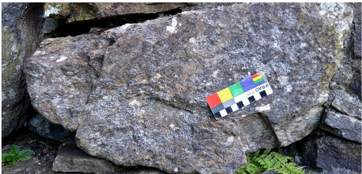
Figur 9: Sannsynlig hogget spor for tung kile for å splitte metaolivinstein, klosterfløyen, Selja (se neste side).
