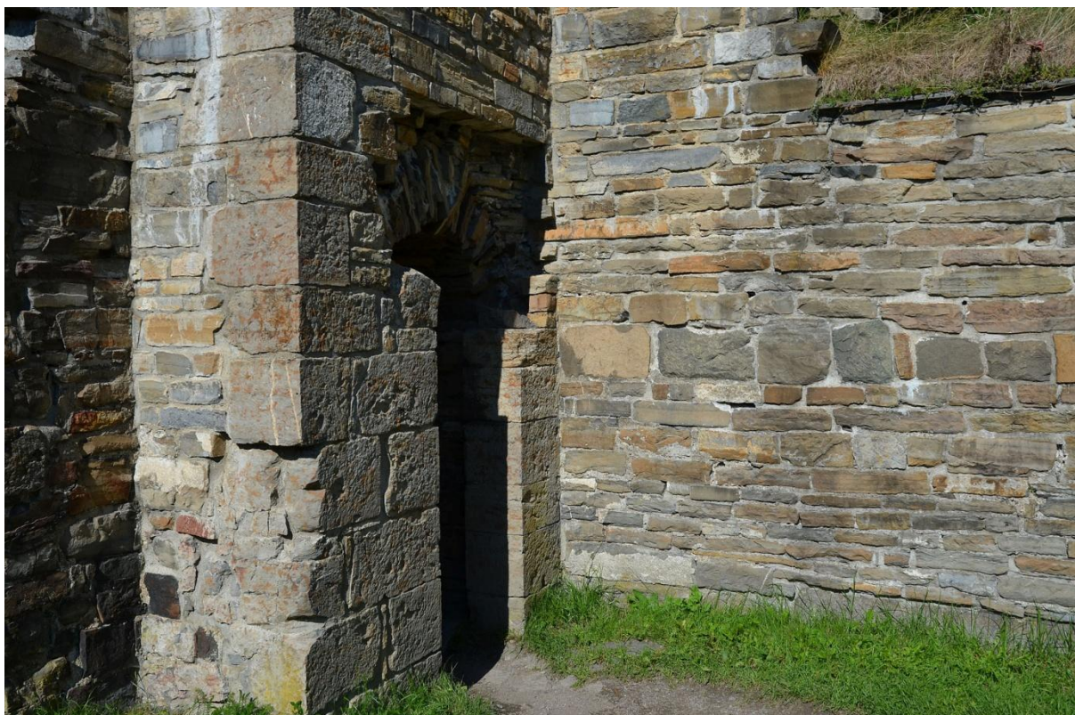
Figur 39: Edmundskirken: regelmessige murestein av sandstein, litt kalkstein - og kvadre av ortocerkalkstein. De større blokkene i sandsteinsmurverket er ulike magmatiske bergarter.
