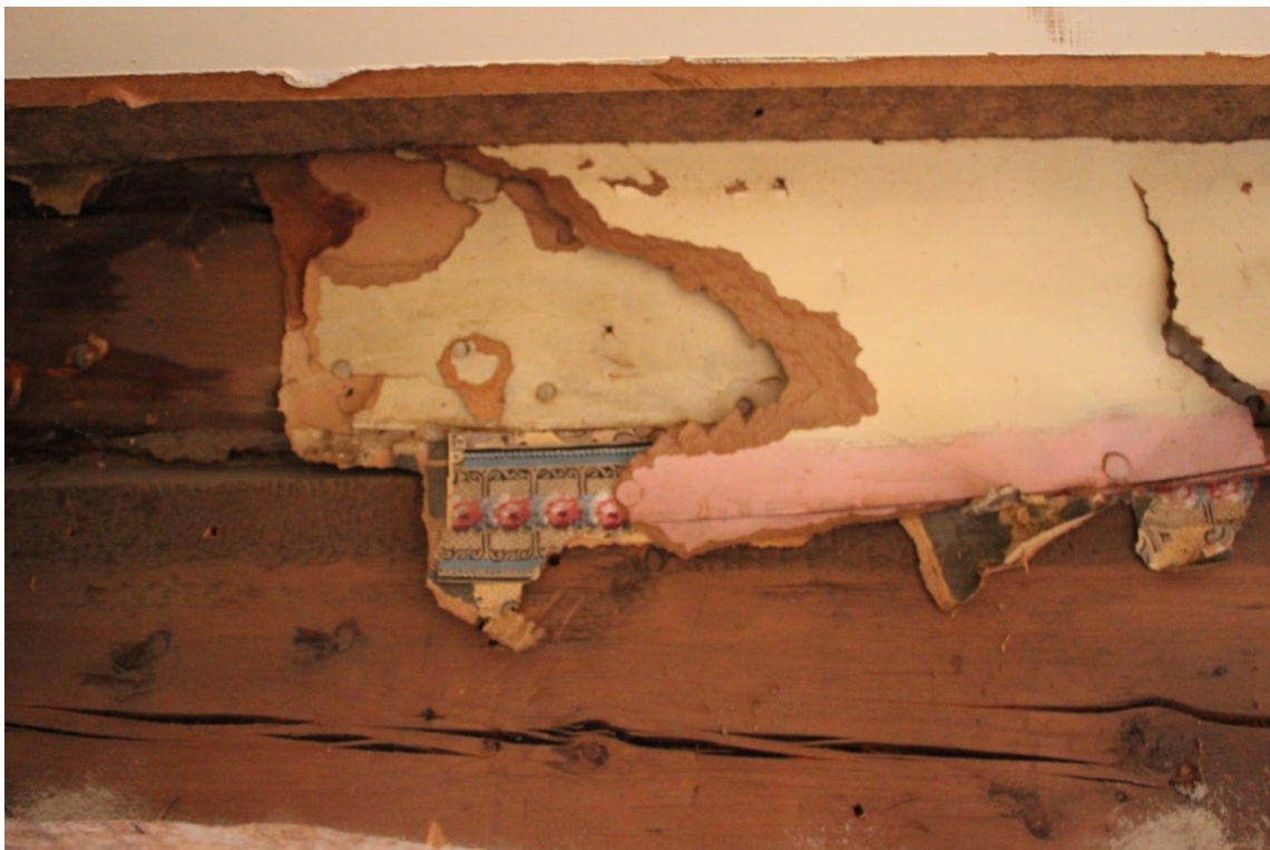
Fig. 2. Røros. Sleggveien 8. Øverste del av den opprinnelige tømmerveggen mellom det opprinnelige kammeret og stuerommet, med rester av veggpapp og tapet. Foto: J. Brønne. September 2013.
