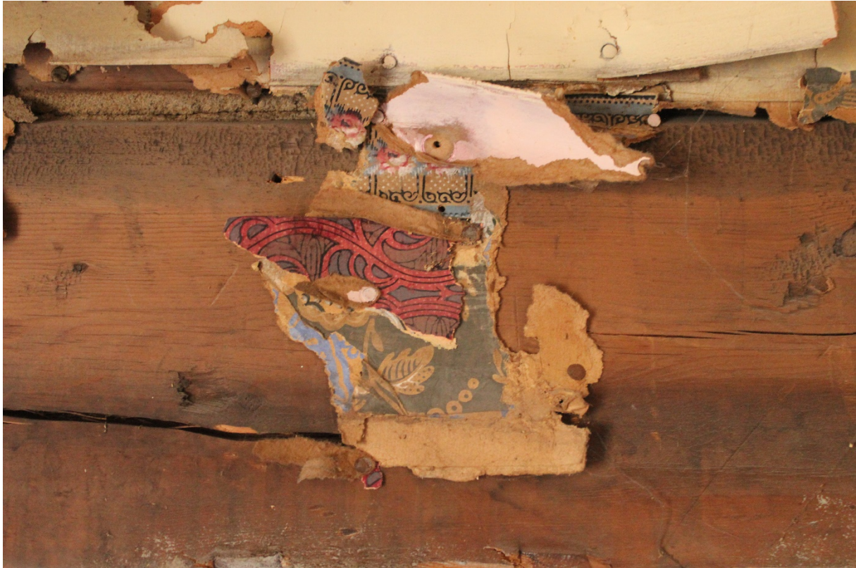
Fig. 3. Røros. Sleggveien 8. Øverste del av den opprinnelige tømmerveggen mellom det opprinnelige kammerset og stuerommet, med rester av veggpapp og tapet. Foto: J. Brønne. September 2013.
