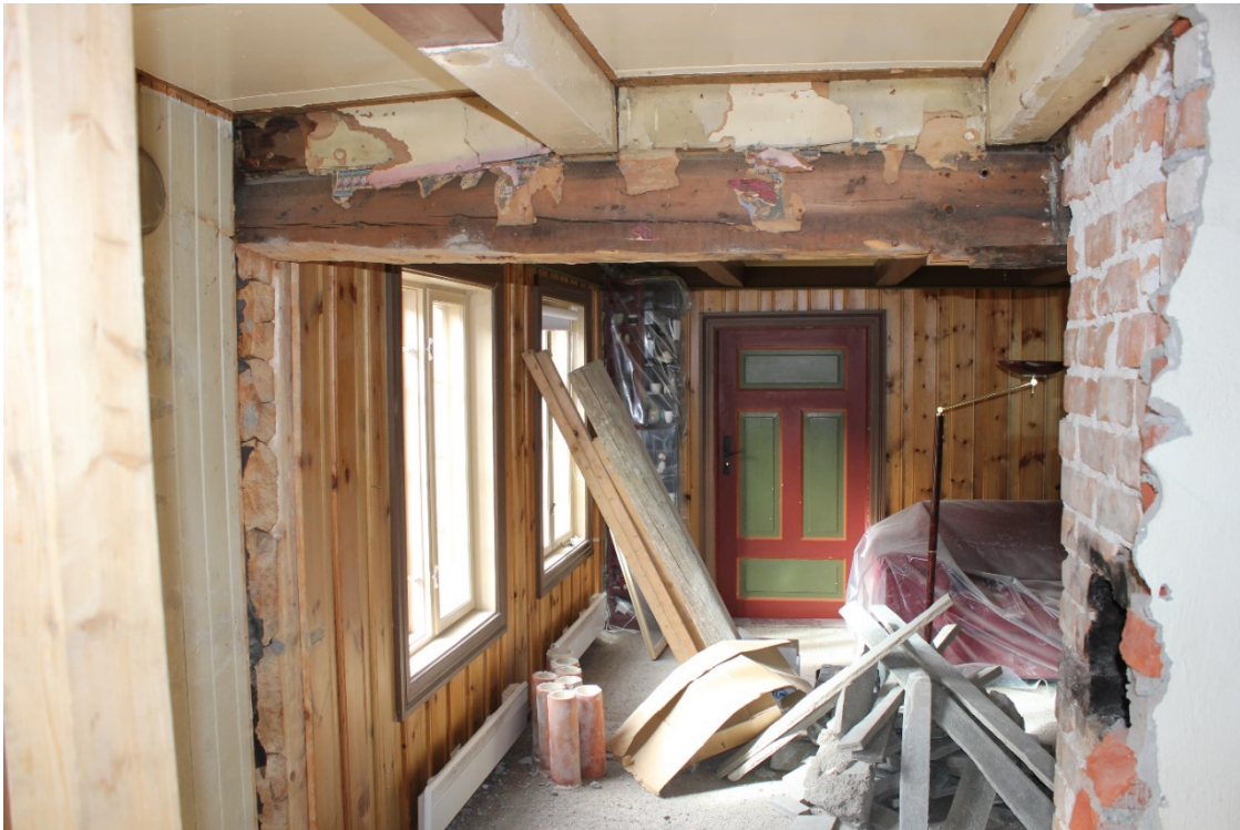
Fig. 1. Røros. Sleggveien 8. Sett fra det nåværende kjøkkenet og mot syd inn i stuerommet. Den opprinnelige tømmerveggen mellom de to rommene var tidligere forhugget, med en sekundær åpning mellom de to rommene. På de øverste to bjelkene mellom rommene sees rester av veggpapp og tapet. Til venstre sees rester av den forhuggete tømmerveggen. Til høyre sees det opprinnelige pipeløpet. Pussen mangler der hvor peisen sto inntil pipeløpet. Foto: J. Brønne. September 2013.
